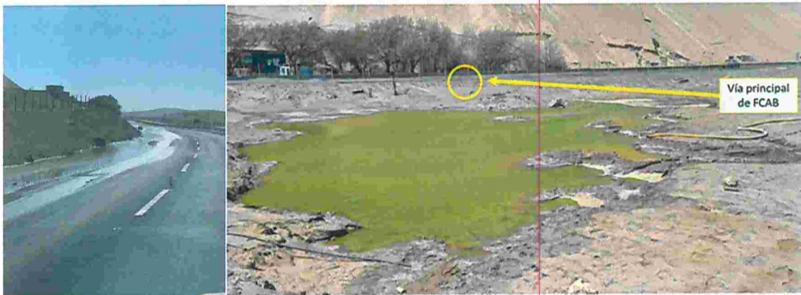
Imágenes N°1 y N°2. Derrame de PLS y posterior afloramiento
