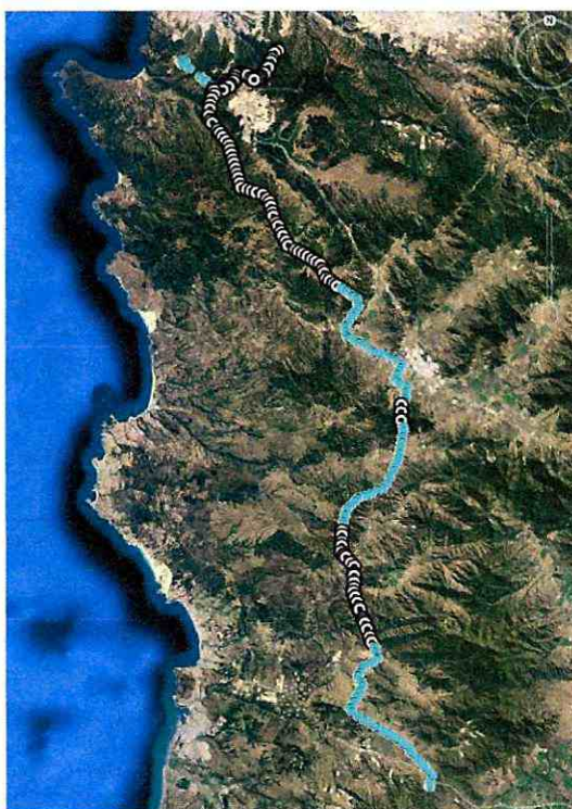
Círculos de color celeste indican la ubicación de las torres en construcción y las de color blanco, aquellas no aún iniciadas. (Elaboración propia)
