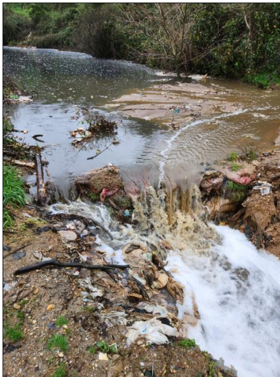
Imagen N°4: Rebalse de laguna de lixiviados
