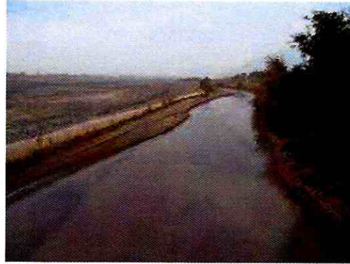
Fotografía 6: Inicio de canalización en cercanías de la estación 1
