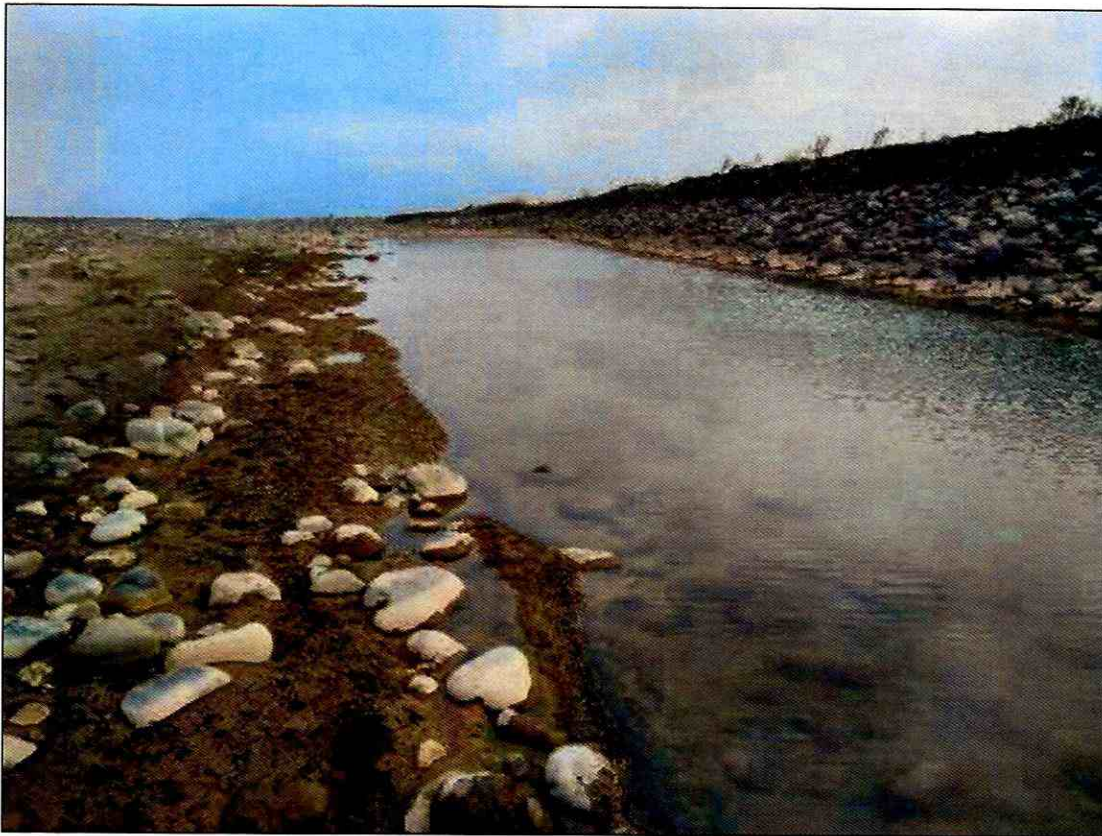
Figura 5-5: Vista general de la estación de monitoreo E4.
