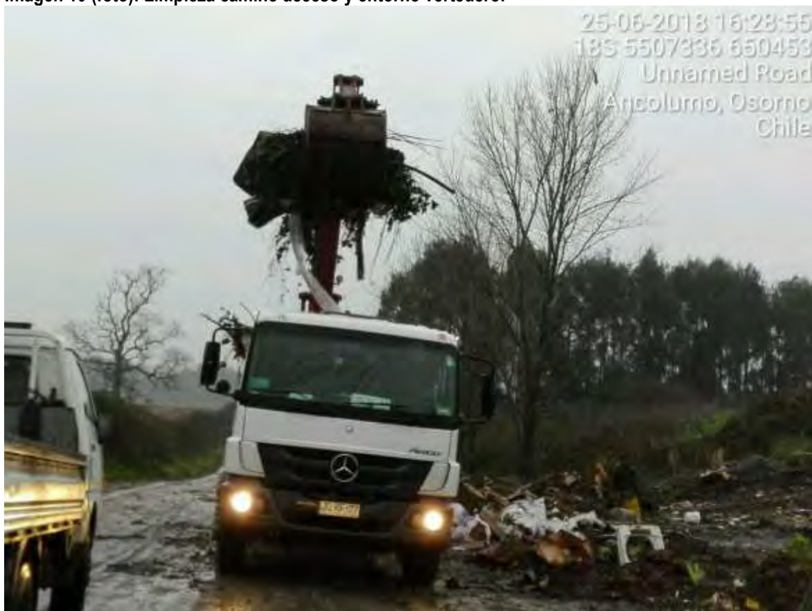
Imagen 10 (foto): Limpieza camino acceso y entorno vertedero.
