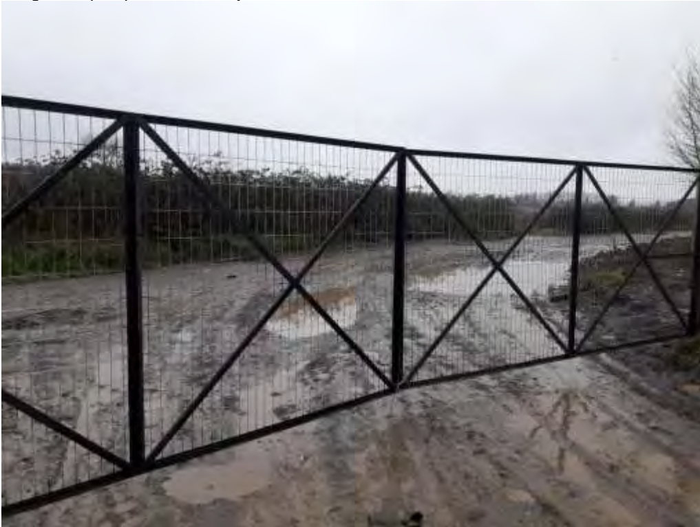
Imagen 14 (foto): Instalación portón de acceso.
