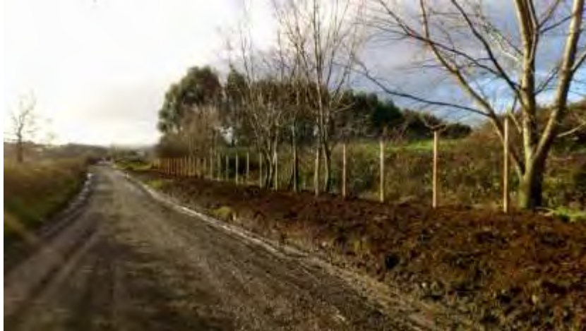
Imagen 12 (foto): Confección de 727 mts. De cerco frontis del Vertedero de Curaco:
