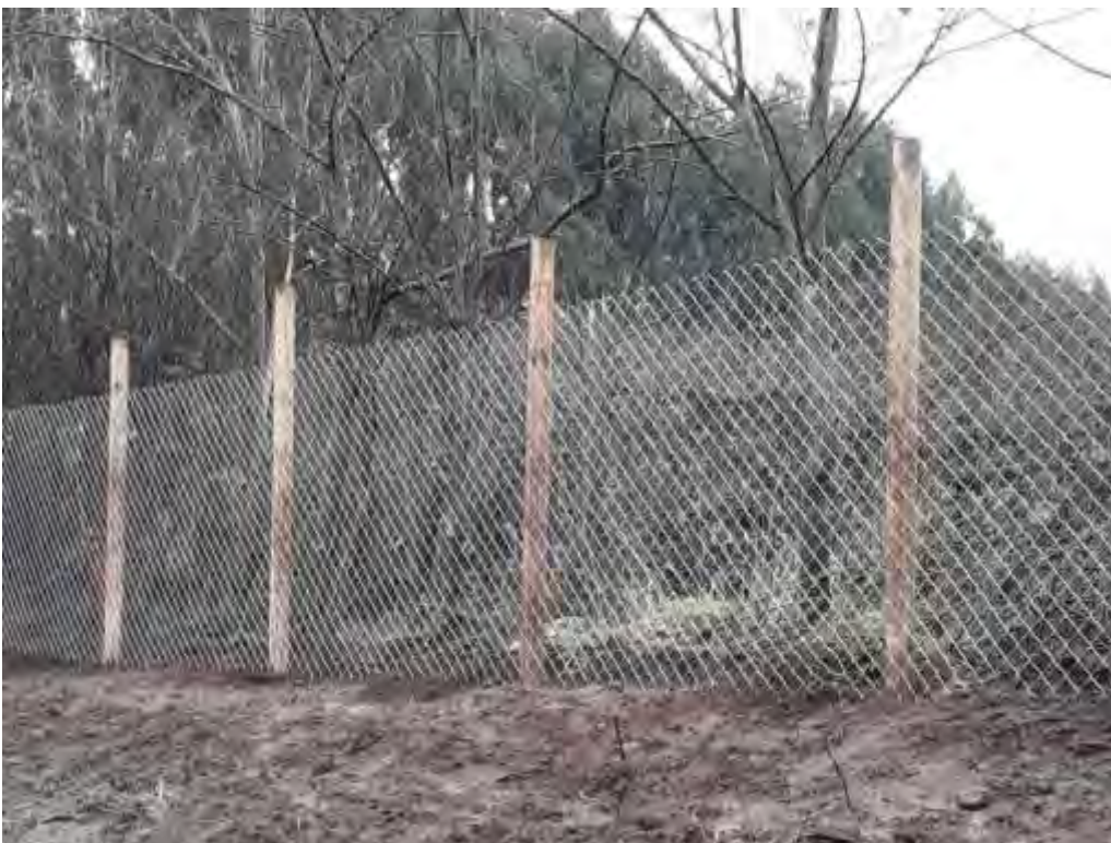
Imagen 11 (foto): Confección de 727 mts. De cerco frontis del Vertedero de Curaco.
