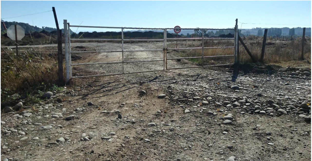
Portón Acceso a Pozo Extracción de Material.
