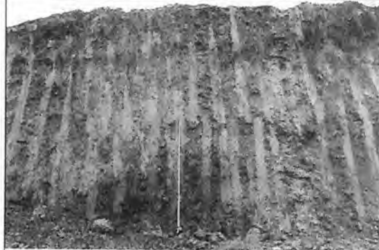
Ilustración 7. Inspección de perfiles expuestos luego de escarpe de máquinas (Sector Lote A)
