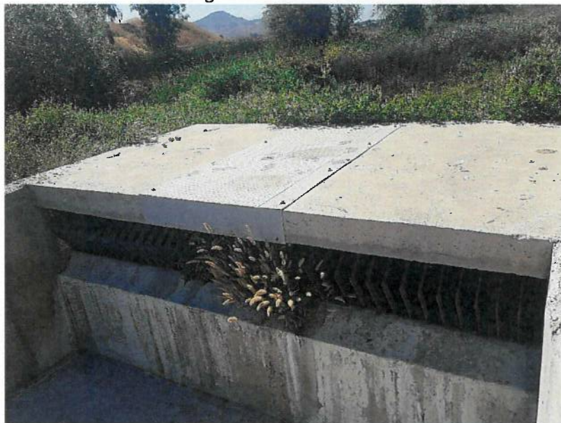
Fotografía 2. Obra de rebalse
