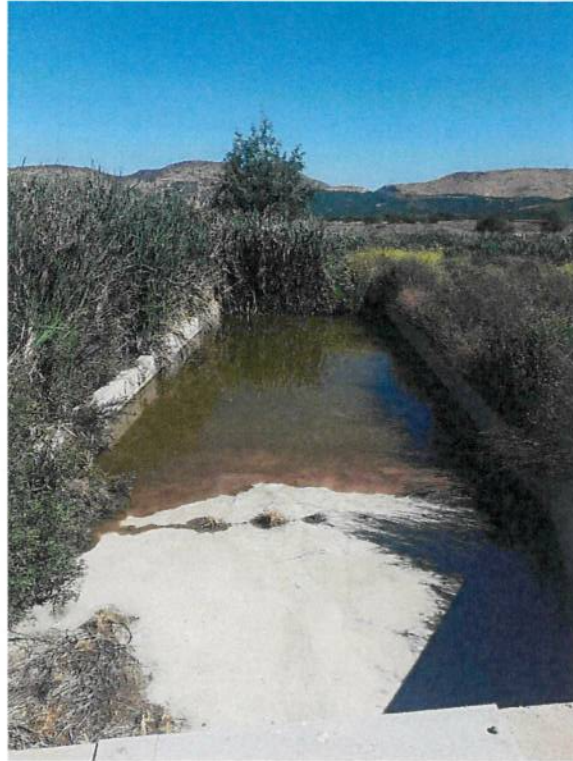
Fotografía 1. Plataforma de derrame existente (vista hacia el norte)
