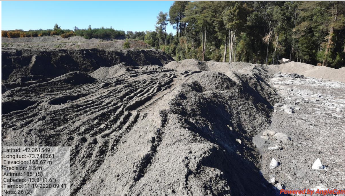
Fotografía N°10 – Pretil poniente de la Zanja N°6, al inicio de la jornada
