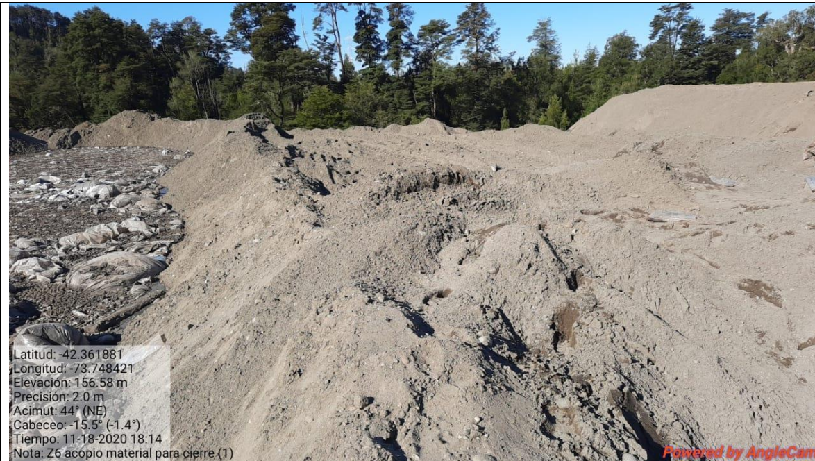
Fotografía N° 11 – Pretil oriente de la Zanja N°6, al fin del día
