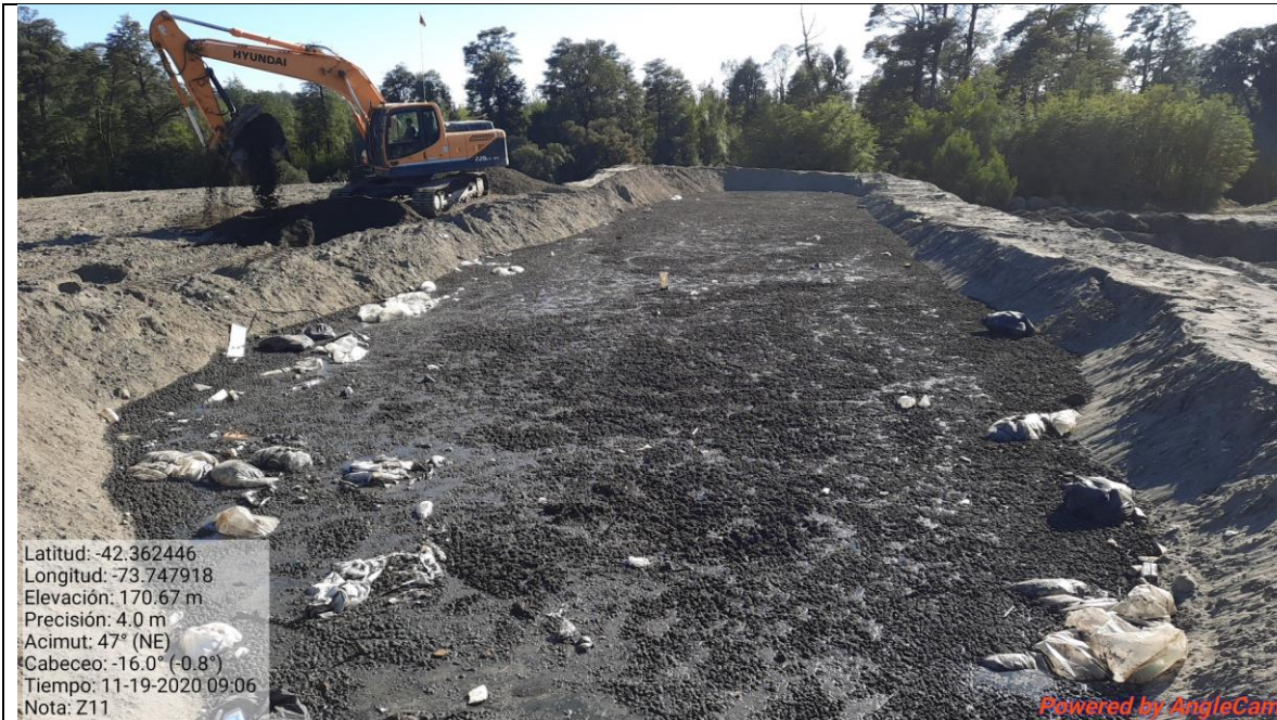
Fotografía 13: Zanja N°11 en proceso de cierre. Pretiles laterales anchos
