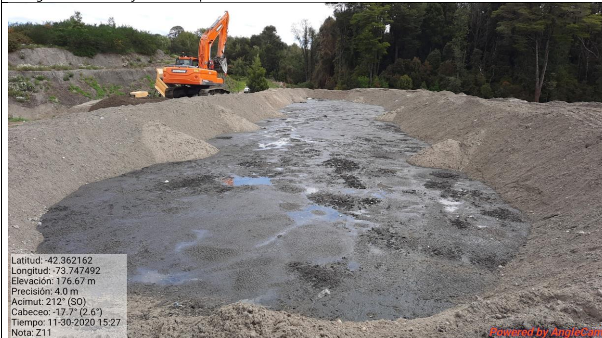
Fotografía N°16: Zanja N°11 en proceso de cierre.
