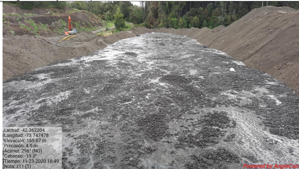
Fotografía 14: Zanja N°11 en proceso de cierre.
