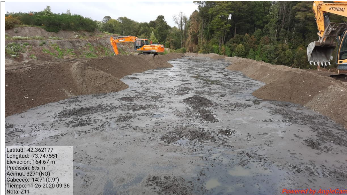
Fotografía N°15: Zanja N°11 en proceso de cierre.
