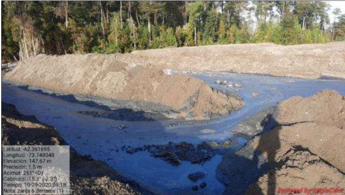
FIGURA-2: Derrame de Zanja N° 6
