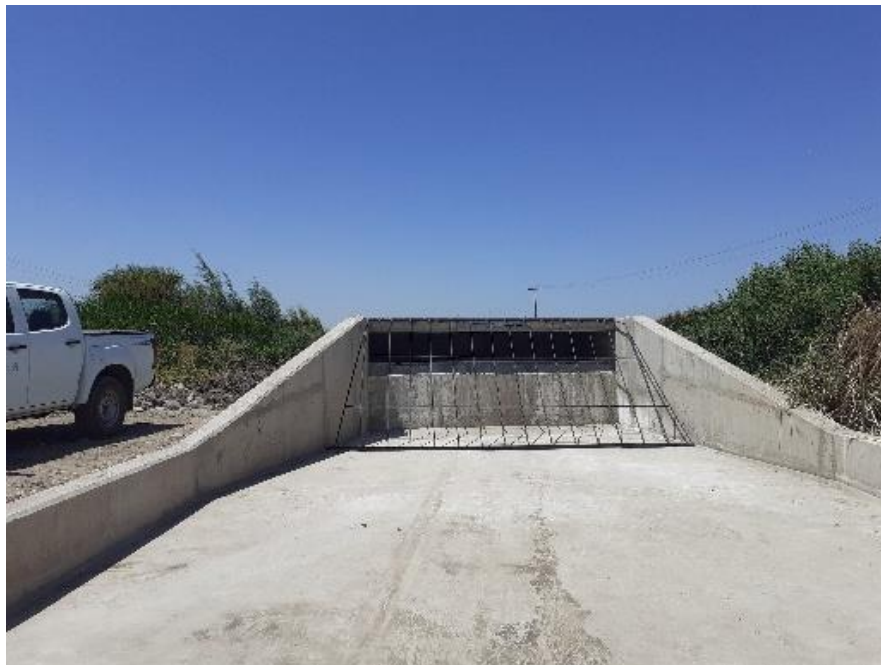
Instalación de reja de protección Fecha: 18 de enero 2021. Coordenadas geográficas Este: 333422.54 Norte: 6325105.46
