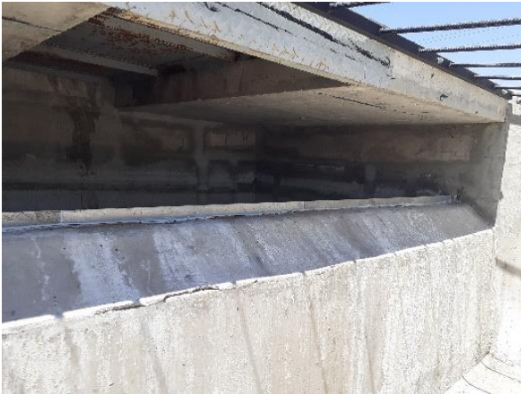
Instalación y nivelación de vertedero Fecha: 05 y 06 de enero 2021 Coordenadas geográficas Este: 333422.54 Norte: 6325105.46
