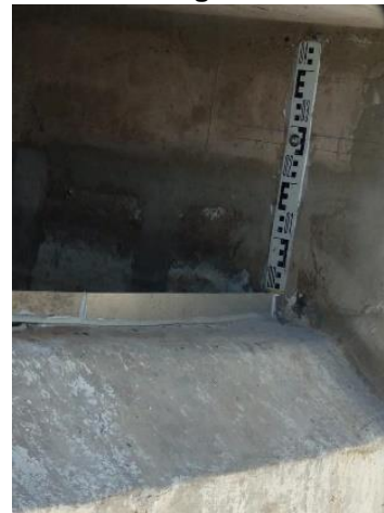
Instalación de regla de medición Fecha: 06 de enero 2021 Coordenadas geográficas Este: 333422.54 Norte: 6325105.46
