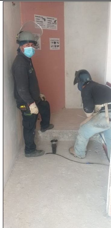
Trabajos con Esmeril angular
