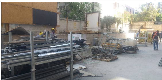
Golpes por movimiento de material
