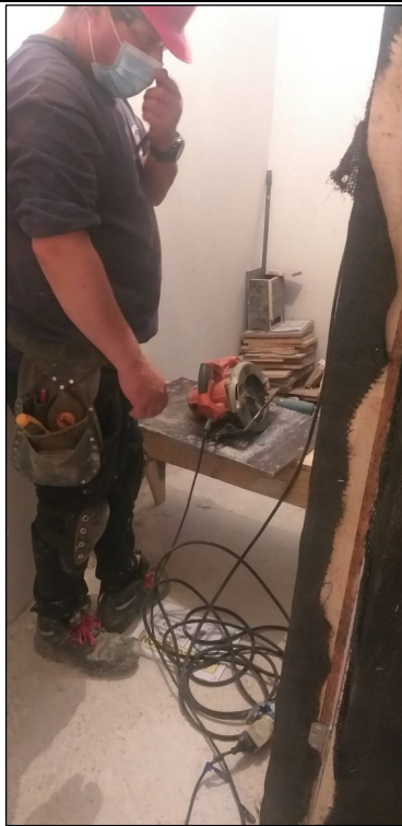
Trabajos con Sierra Circular
