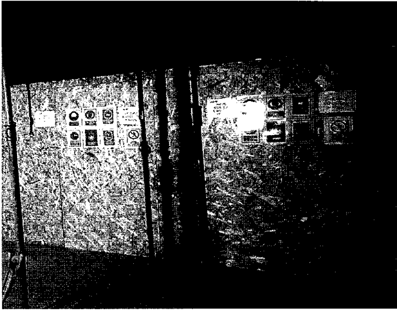
Imagen N° 3. Biombo acústico en piso 2. Con su señalética de uso e instructivo de EPP obligatorio. Confeccionado de OSB de 15mm y lana mineral de 50 mm de espesor.
