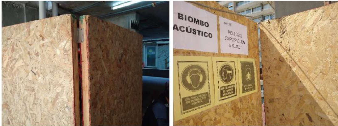
Figura 4 – Registro fotográfico de rendijas en biombos.
