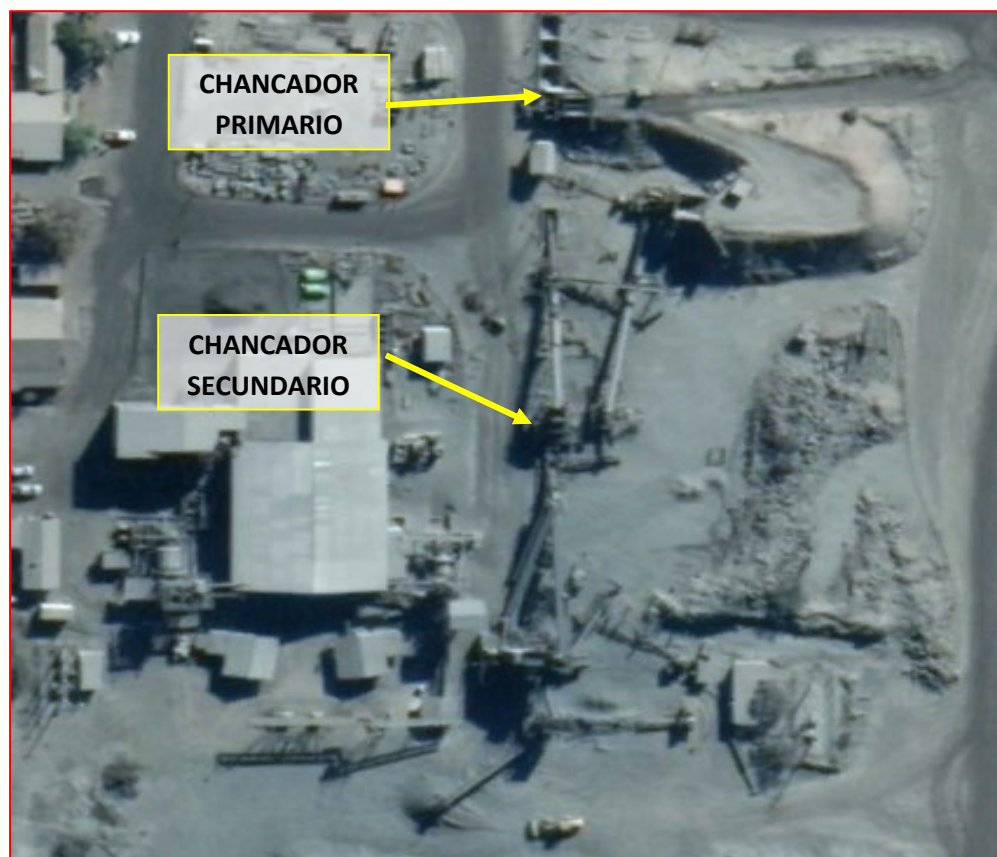
Imagen N°1: Mapa esquemático – Localización de los trabajos correctivos en ejecución.
