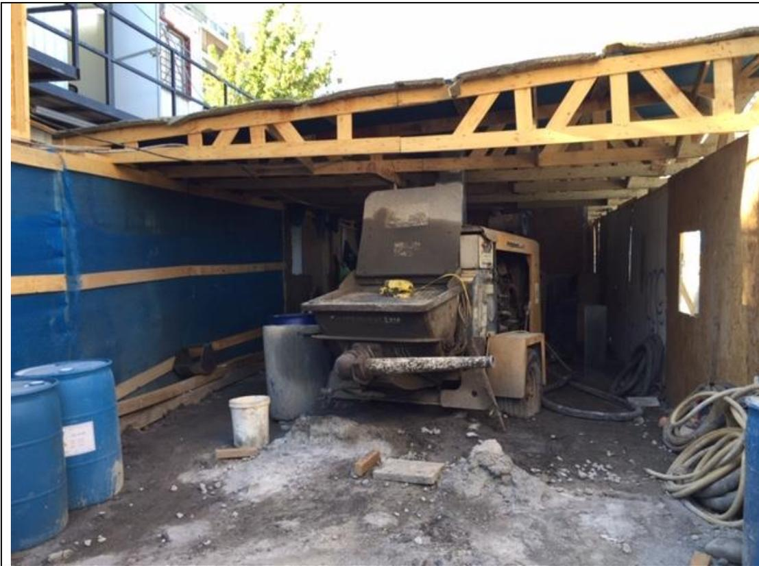
Imagen de avance de biombos acústicos laterales y superiores para bomba de hormigón
