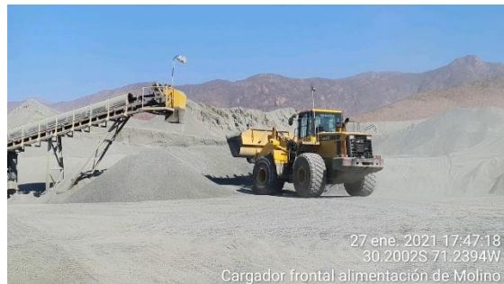
Maquinaria en cancha de acopio
