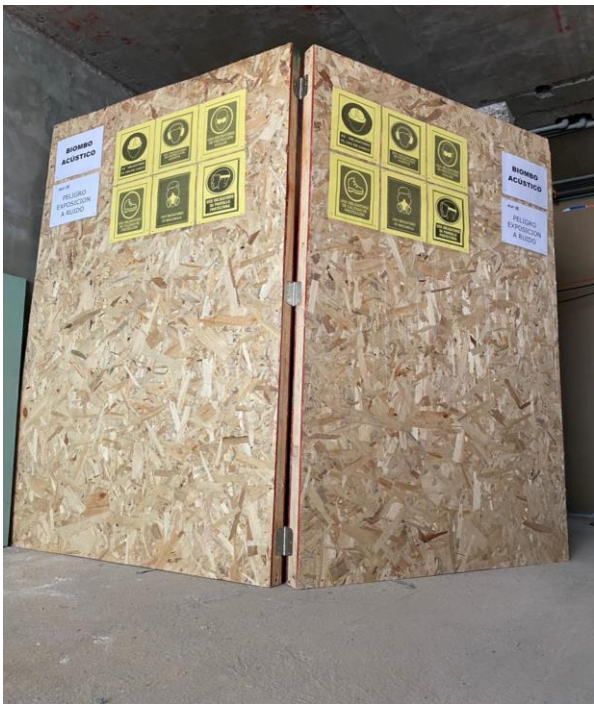
Imagen N° 3. Biombo acústico en piso 2. Con su señalética de uso e instructivo de EPP obligatorio. Confeccionado de OSB de 15mm y lana mineral de 50 mm de espesor.
