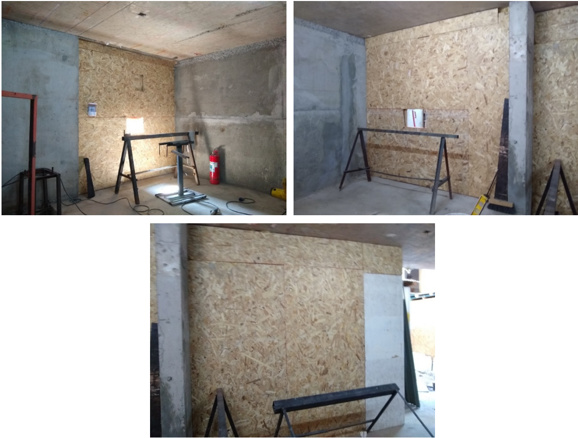
Figura 2 – Registro fotográfico de taller de corte del piso 1.
