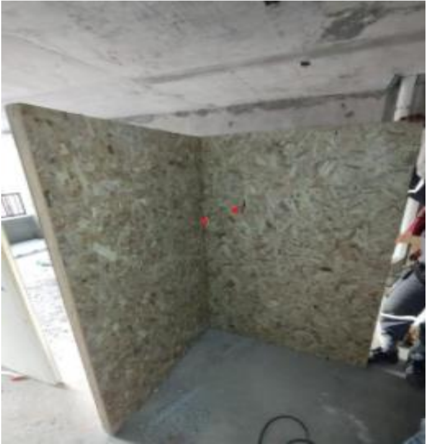
Ilustración 2 Mejora de los biombos acústicos, visión interior.
