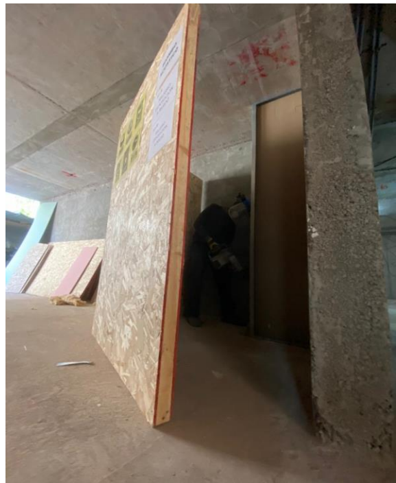
Imagen N° 3. Biombo acústico en piso 2. Con su señalética de uso e instructivo de EPP obligatorio. Confeccionado de OSB de 15mm y lana mineral de 50 mm de espesor.
