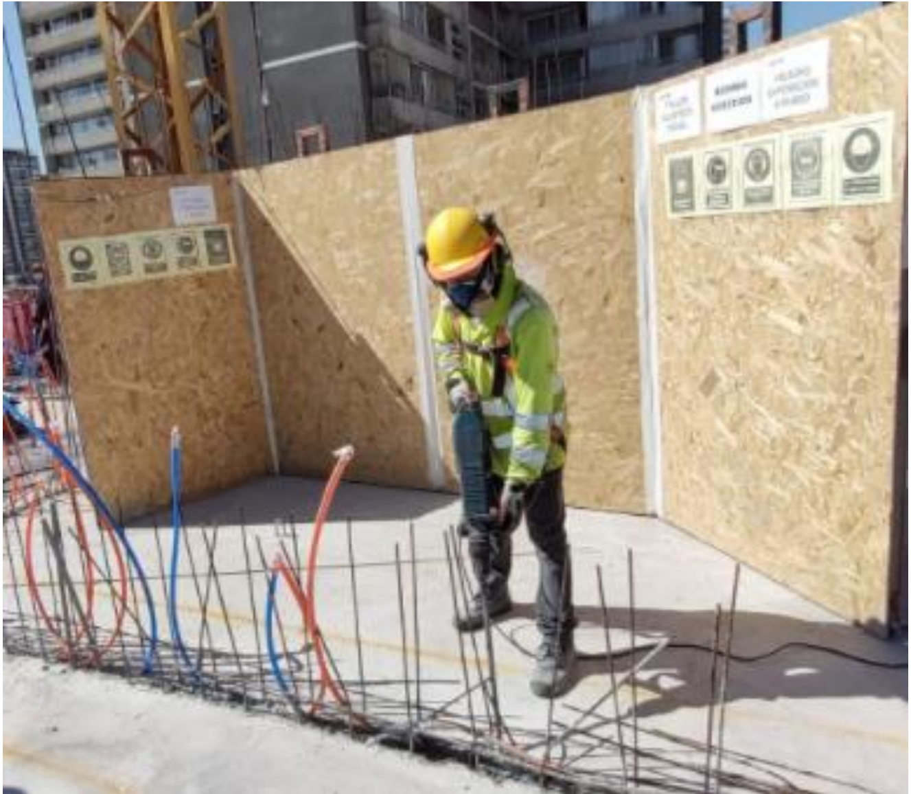
Ilustración 5 - Sello en aberturas del taller móvil de la losa de avance, usado para labores de tratamiento de muros.
