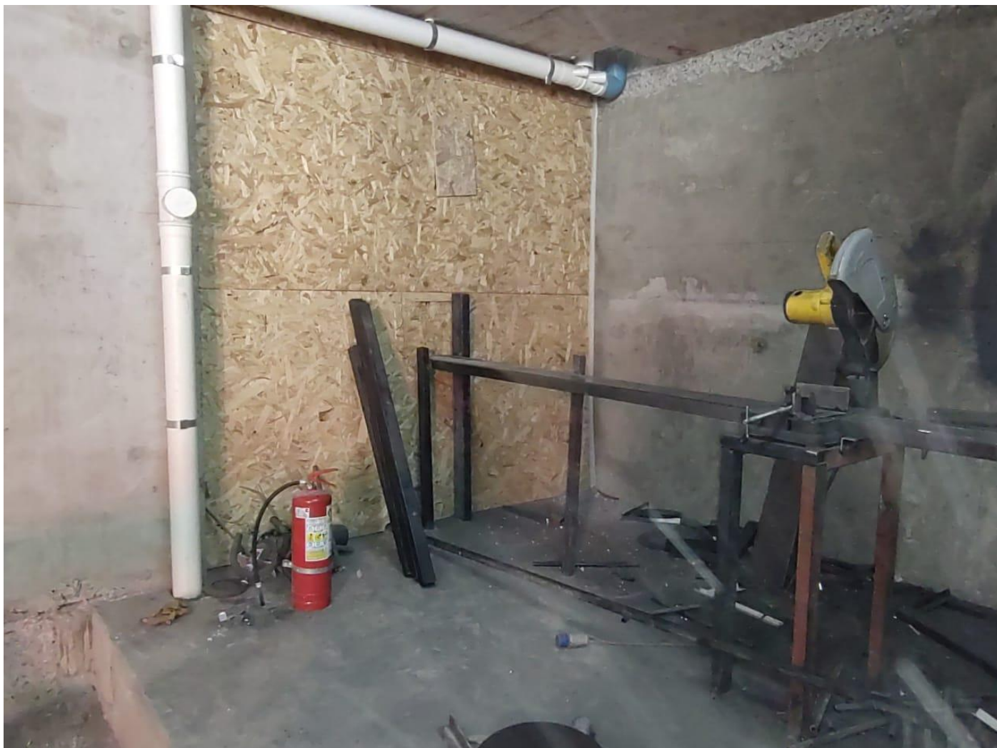
Ilustración 9 – Sello de abertura interior del taller costado oriente.
