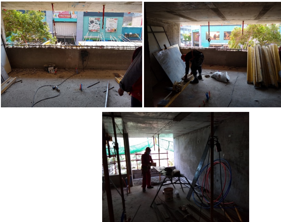
Figura 7 – Vanos sin cerrar, con uso de martillo demoledor (arriba a la izquierda), herramienta eléctrica de corte (arriba a la derecha), ambos hacia calle San Diego. Mientras, en la parte inferior se muestra una herramienta eléctrica en un sector sin paneles hacia sector sur.
