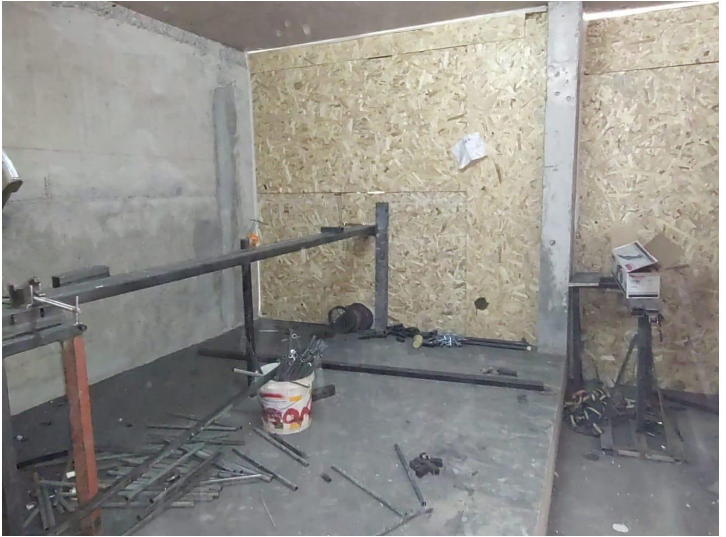
Ilustración 10 – Sello de abertura interior del taller costado poniente.
