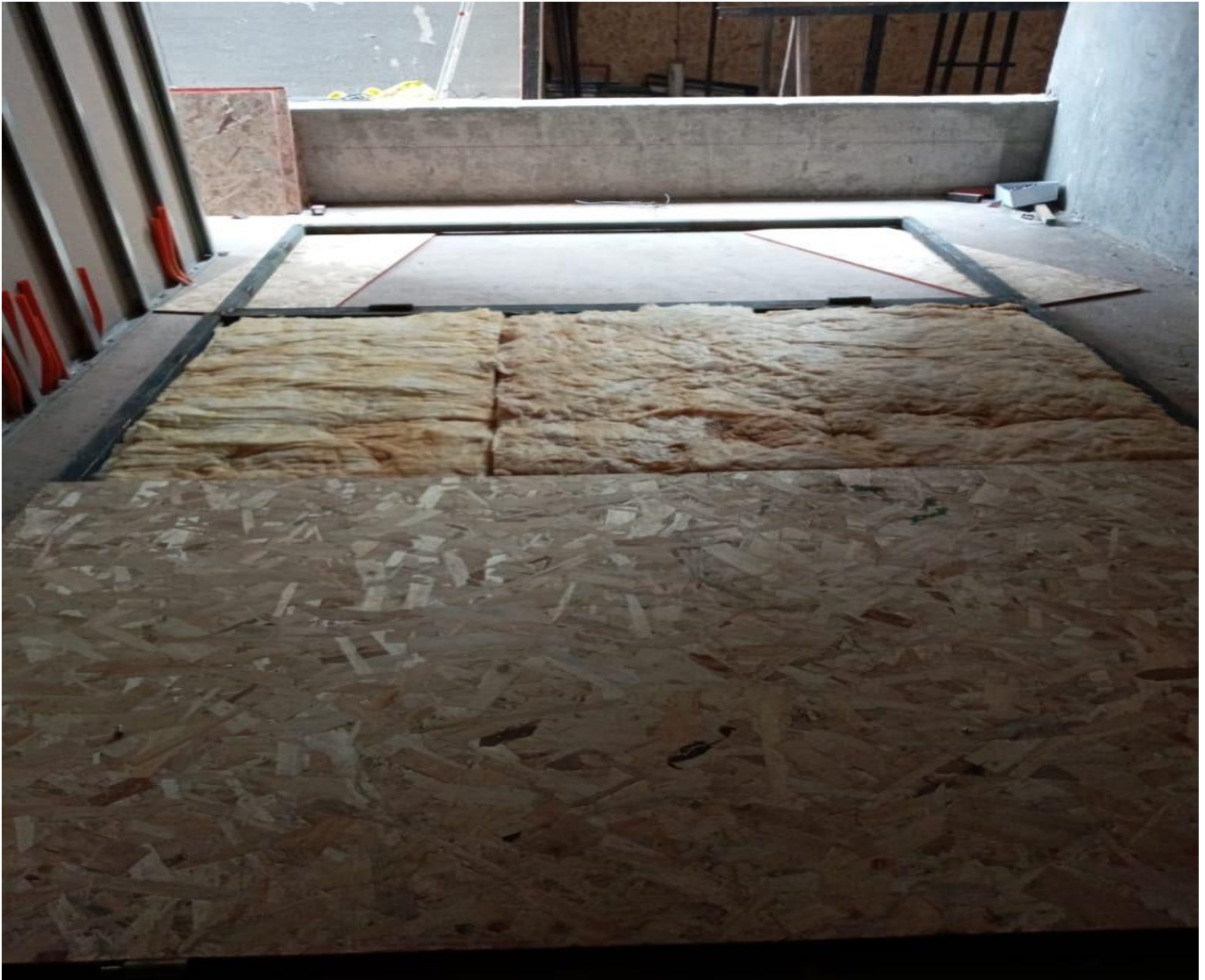
Ilustración 8- Fotografía que ilustra la fabricación de paneles acústico, doble cara de OSB 9,5mm, interior de 50 mm de aislación acústica y bastidores perimetrales.
