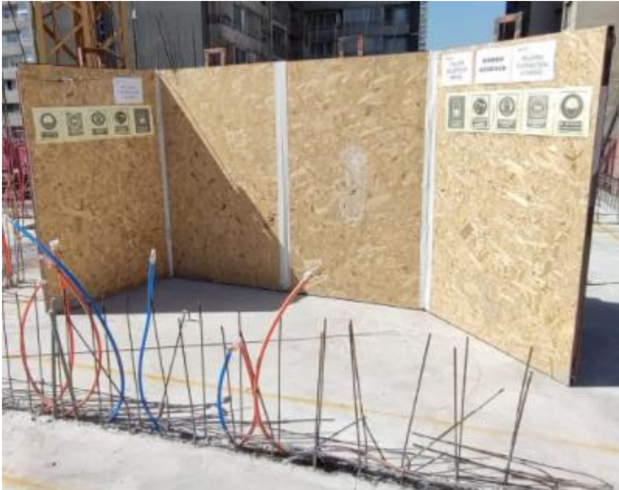
Ilustración 3 - Sello en aberturas del taller móvil de la losa de avance, cara interior.
