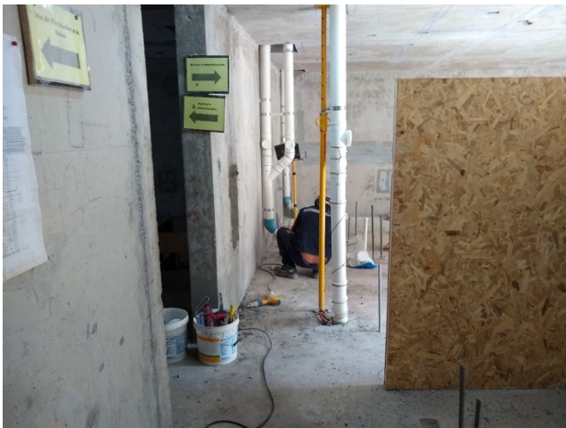
Figura 6 – Trabajador utilizando herramienta eléctrica con biombo con caras interiores hacia la cámara fotográfica en un sector cercano a Receptor 3.
