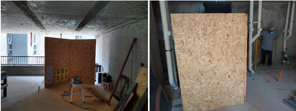
Figura 3 – Registro fotográfico de biombos dentro del edificio en construcción
