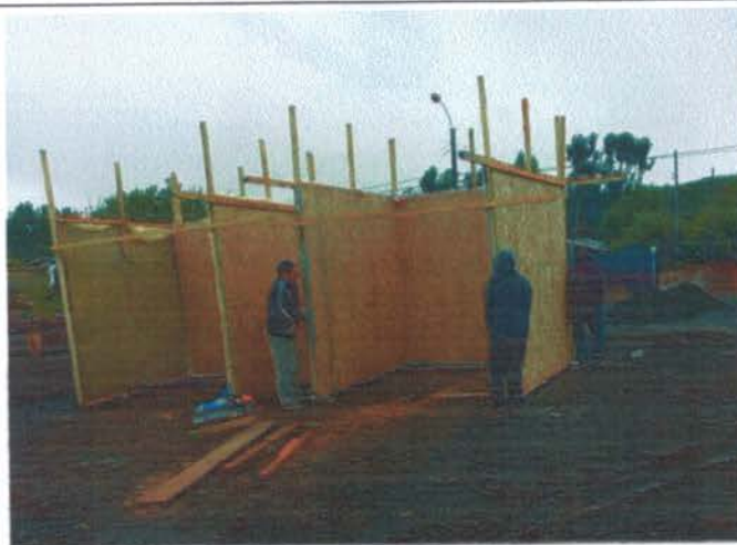
Se evidencia la movilidad de los biombos para ser utilizado en el lugar donde se este trabajando con ruido.
