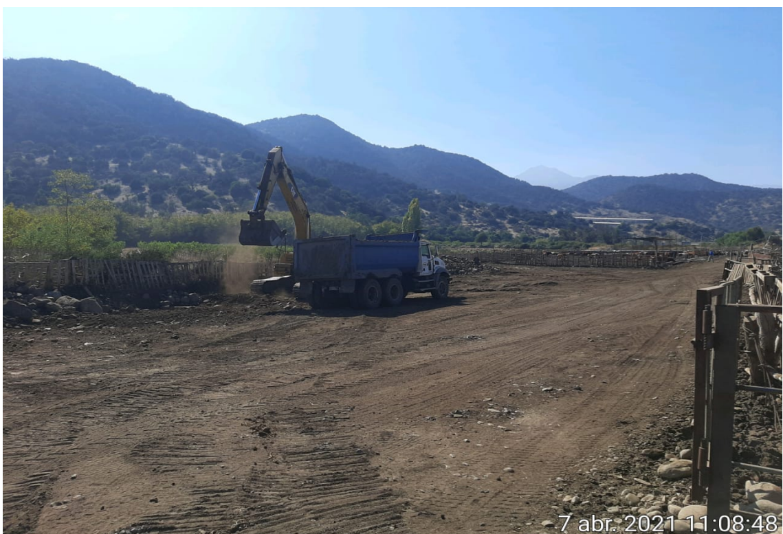
Fotografía Num 4 . Trabajos de limpieza del area de acopio de guano .
