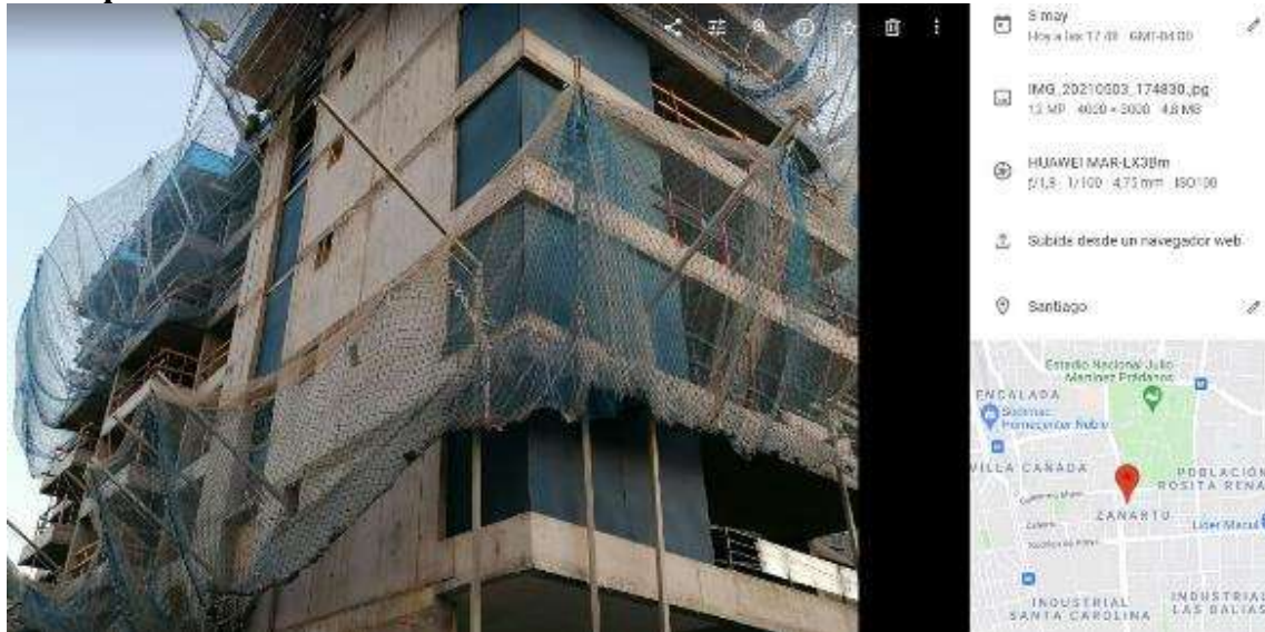
Sello de vanos fachada oriente.
