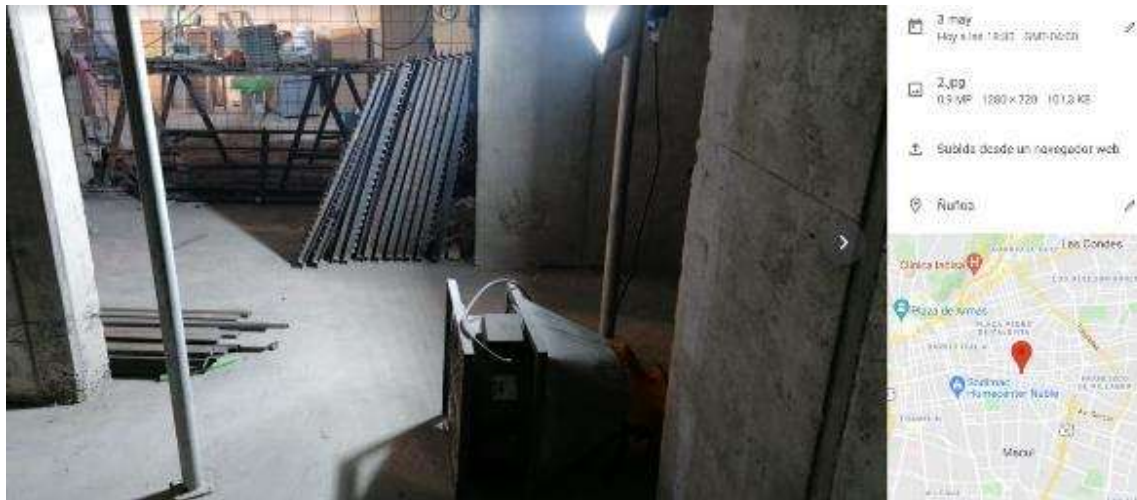
Taller de corte y soldadura en subterráneo 1.
