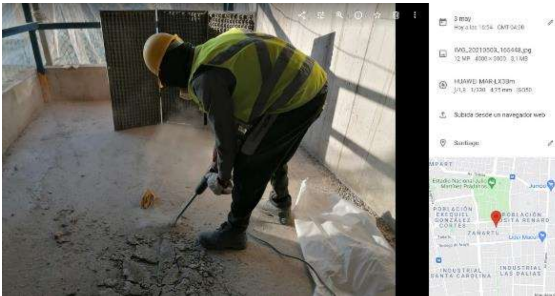
Biombo acústico utilizado en faena de descarachado, departamento 407.
