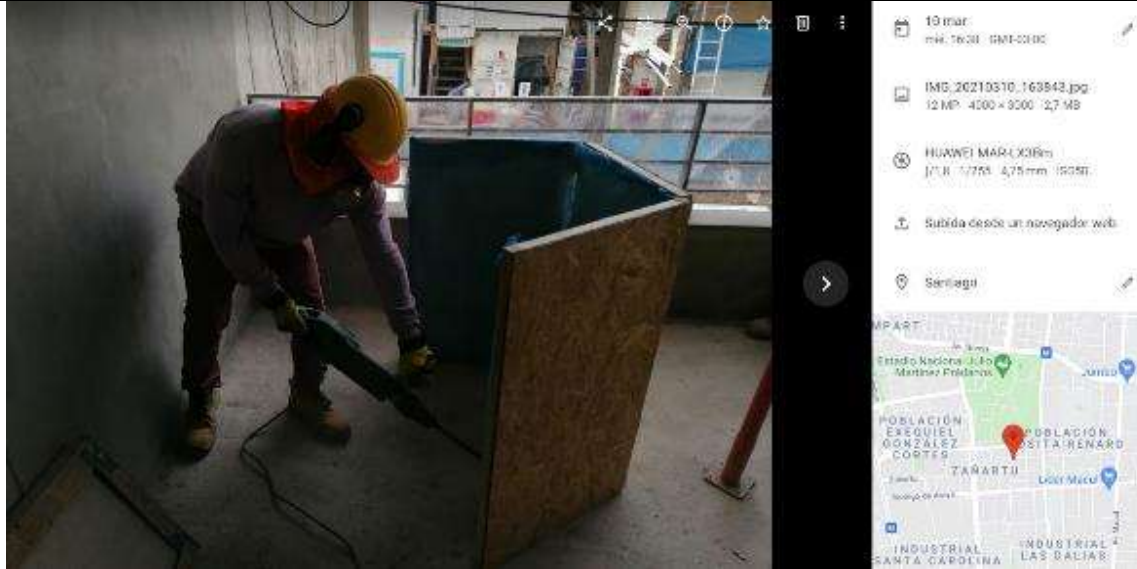
Biombo acústico utilizado en faena de descarachado, departamento 206.
