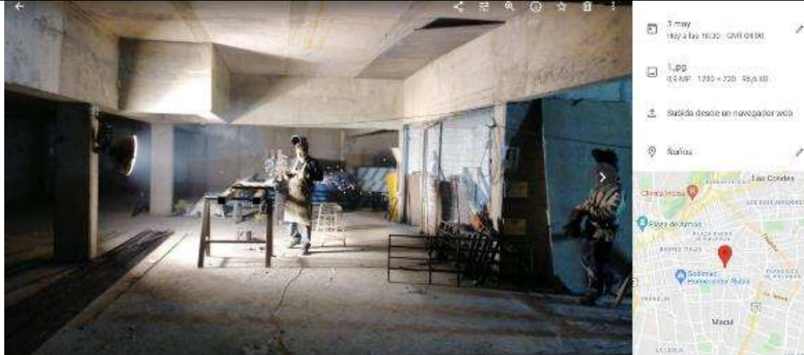
Taller de corte y soldadura en subterráneo 1.
