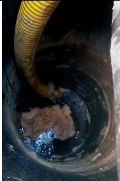
Fotografía N°7: Retiro de Lixiviados de cámaras de inspección de sobrecelda- Zanja Sanitaria N°1, por Empresa Aconser. Tomada: Viernes 09 de Julio del 2021.
