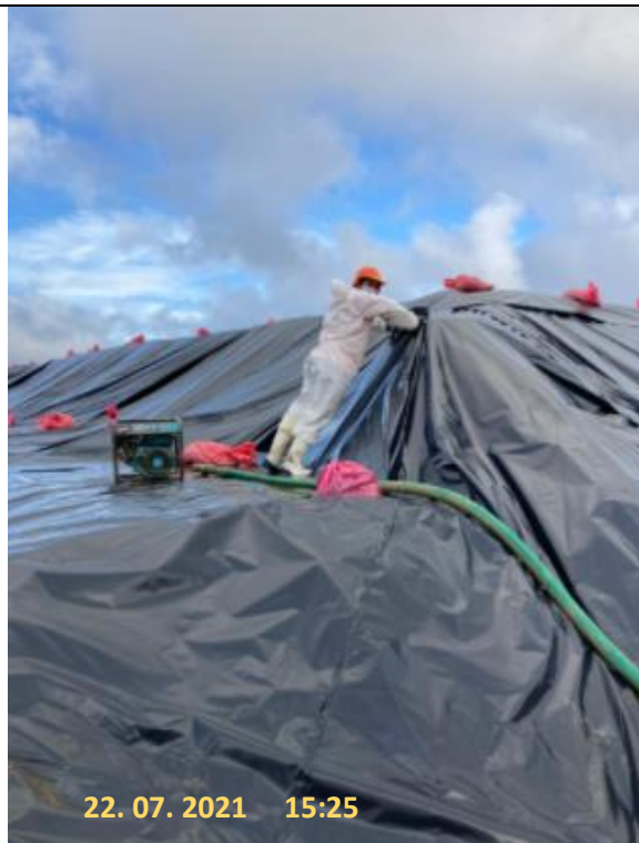
Fotografía N°5: Retiro de Lixiviados desde Cámaras de inspección de sobrecelda zanja N°1 zona norte cámara 10, por Empresa Crecer. Tomada: Jueves 22 de Julio del 2021.
