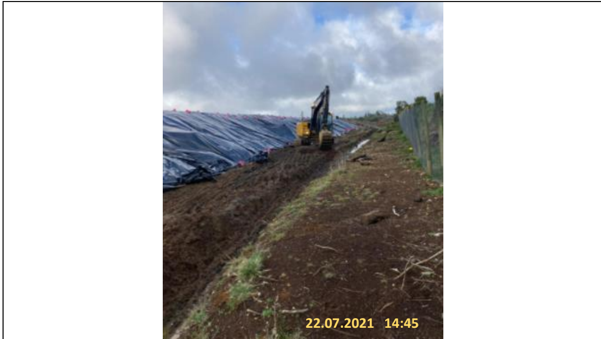
Fotografía N°16: Retiro de Material contaminado zona Oeste Zanja Sanitaria N°1, por Empresa Crecer Tomada: jueves 22 de Julio del 2021.
