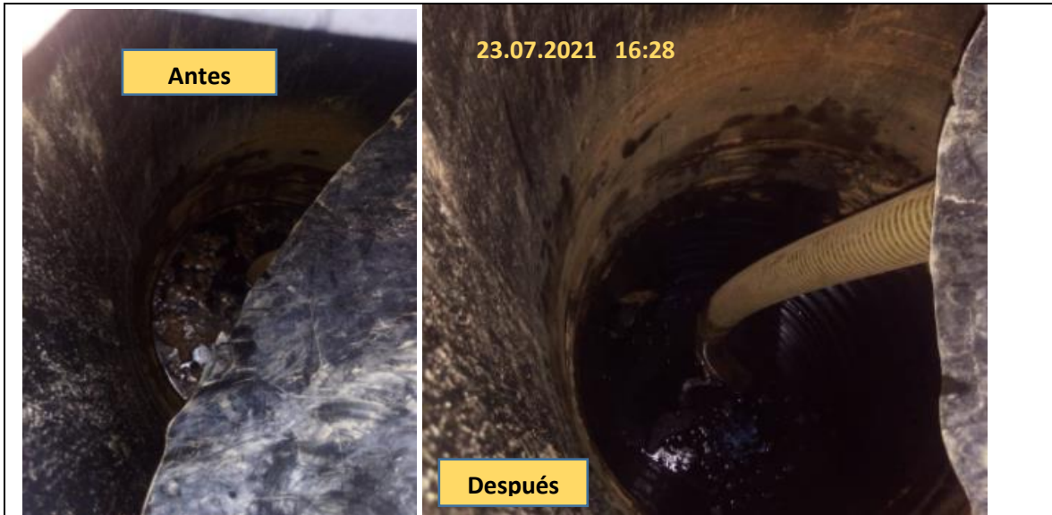
Fotografía N°6: Retiro de Lixiviados desde cámaras de inspección de sobrecelda, Zanja Sanitaria N°1 a batea de acumulación, por Empresa Crecer. Tomada: Viernes 23 de Julio del 2021.
