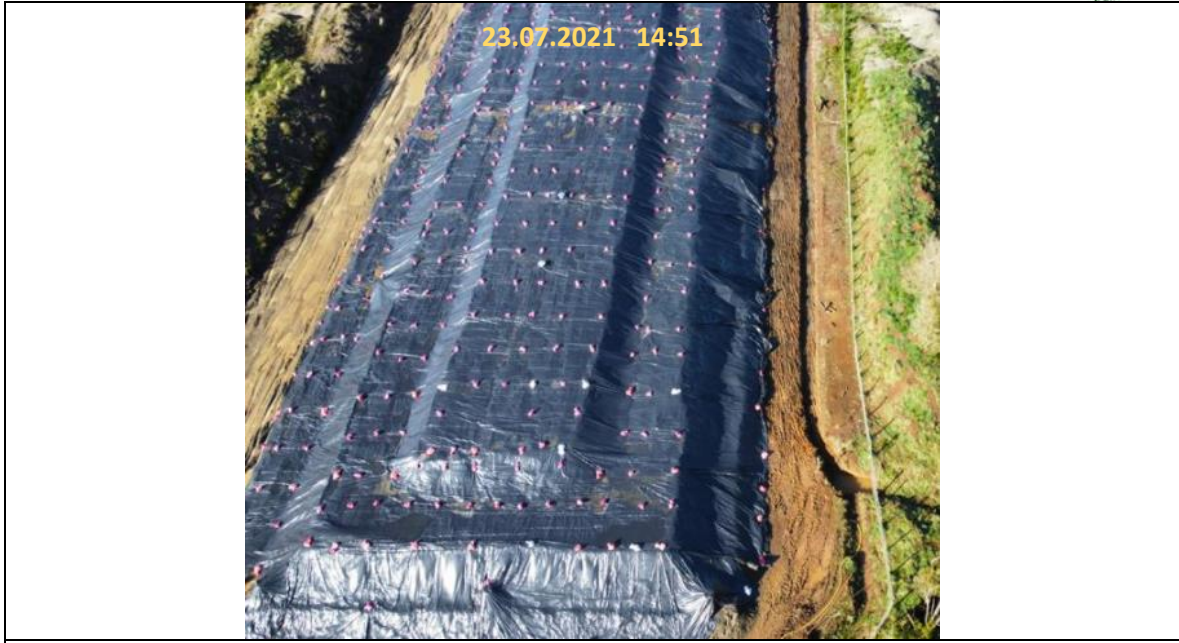
Fotografía N°20: Retiro de Material contaminado zona Oeste Zanja Sanitaria N°1, por Empresa Crecer
