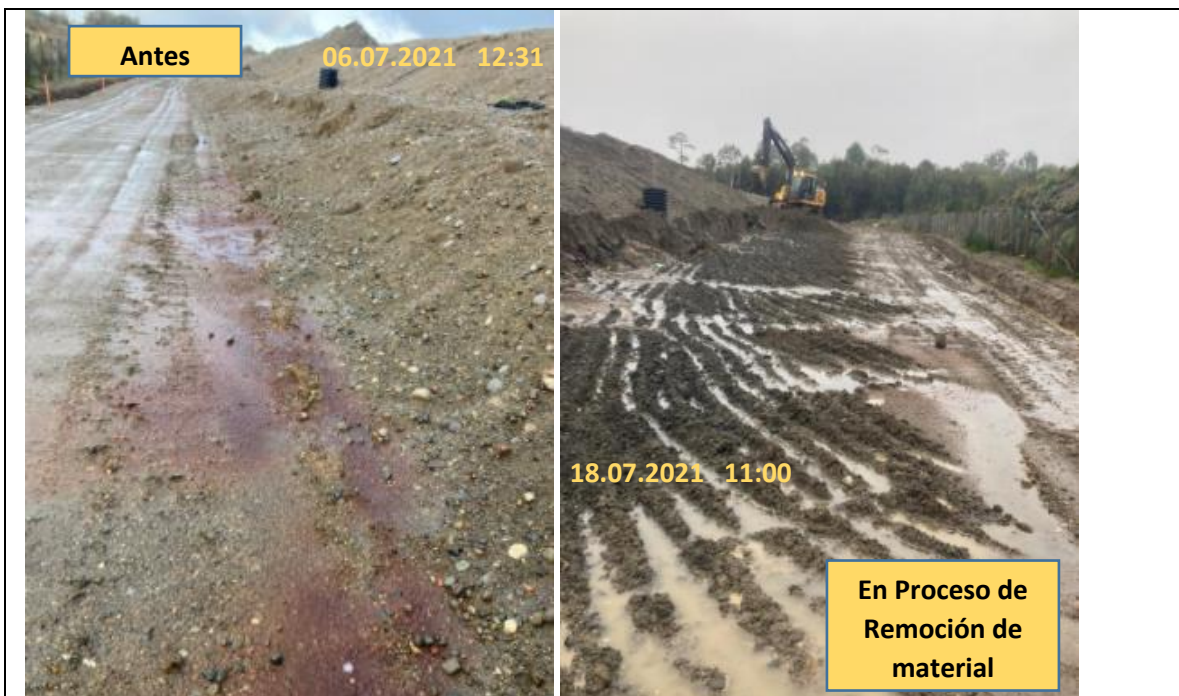
Fotografía N°13: Remoción de material correspondiente al pretel de contención ubicado en la zona Este de la Zanja Sanitaria, por Empresa Crecer.
