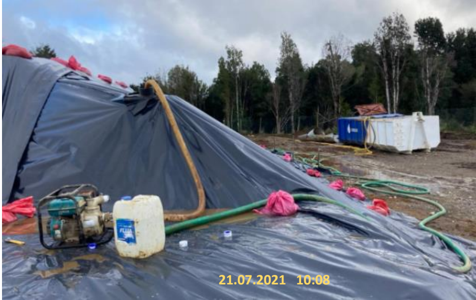
Fotografía N°4: Retiro de Lixiviados de cámaras de inspección de sobrecelda zona norte- Zanja Sanitaria N°1, por Empresa Crecer. Tomada: Miércoles 21 de Julio del 2021.
