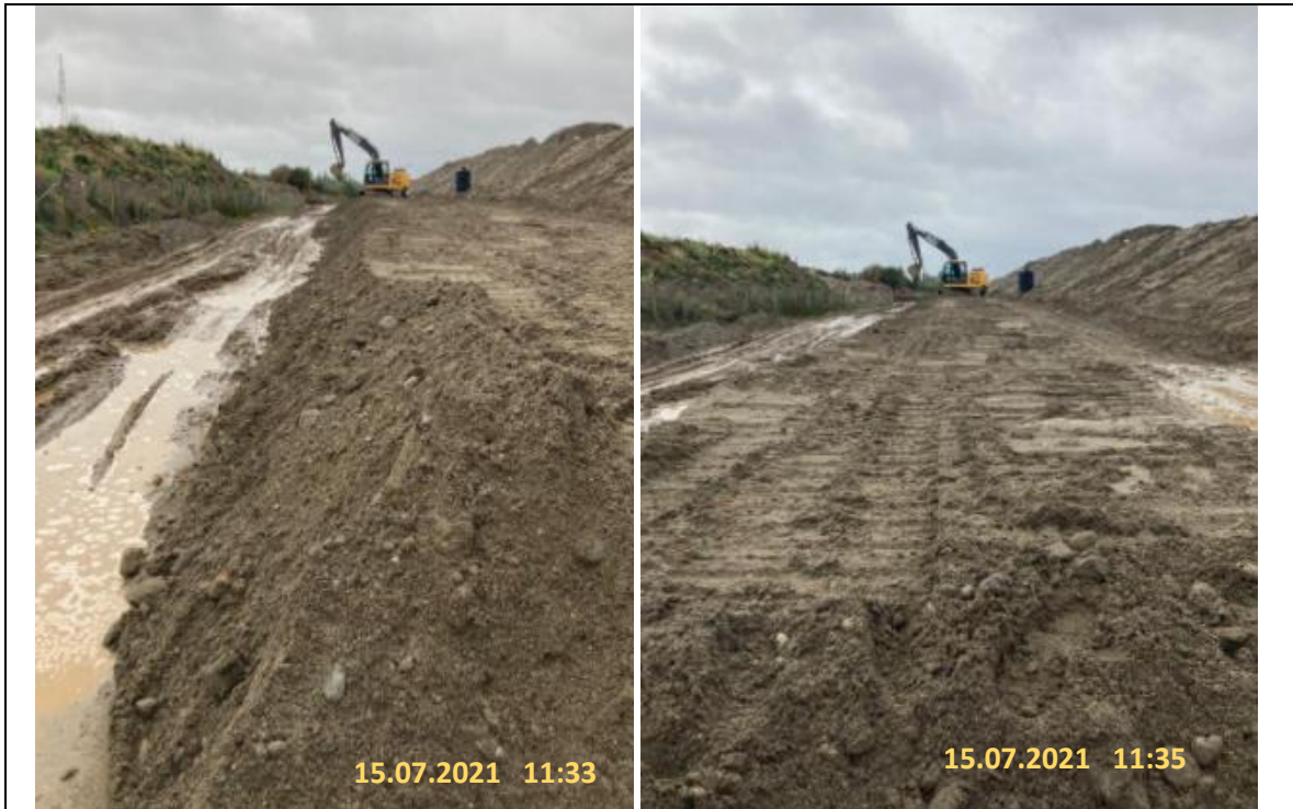
Fotografía N°15: Pretil de contención con material limpio ubicado en la zona Este de la Zanja Sanitaria, por Empresa Crecer
