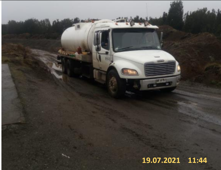
Fotografía N°2: Retiro de Lixiviados desde cámaras de inspección de sobrecelda zona norte- Zanja Sanitaria N°1 y batea de acumulación, por Empresa Aconser Tomada: Lunes 19 de Julio del 2021.
