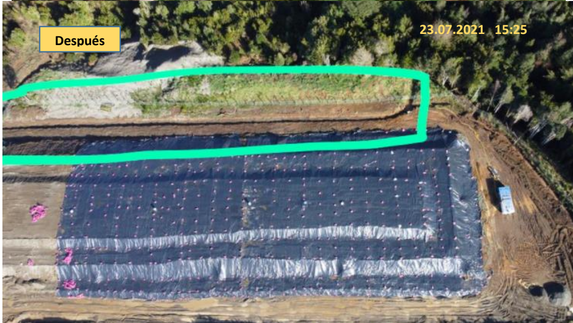
Fotografía N°19: Antes y Después zona Este zanja Sanitaria N°1.
