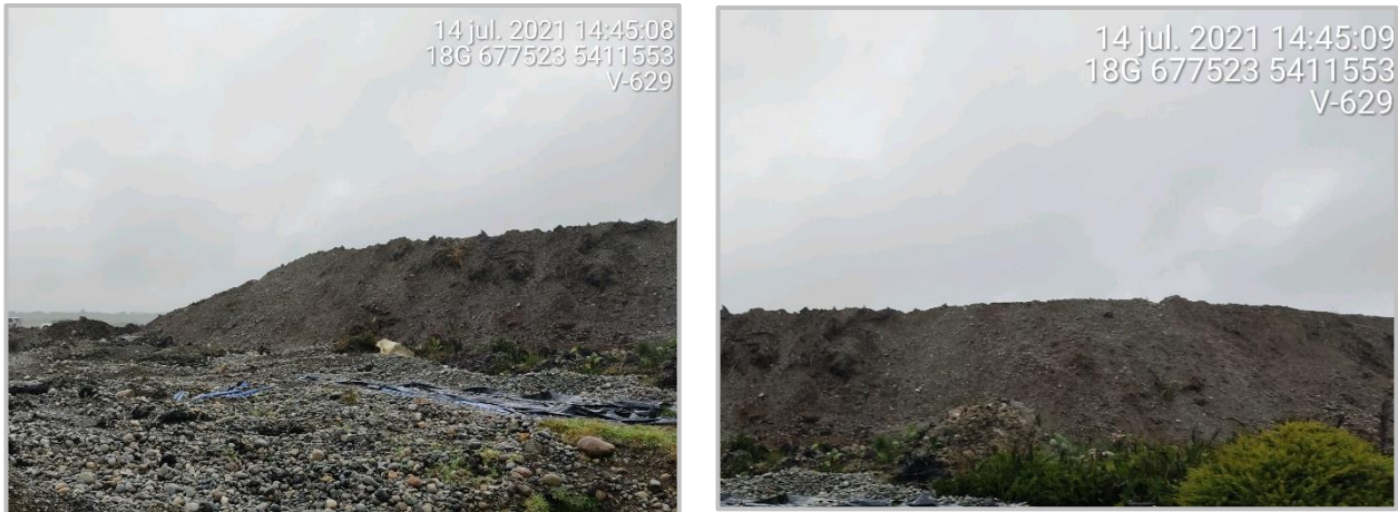
Figura 4: Barrera de acopio de material
