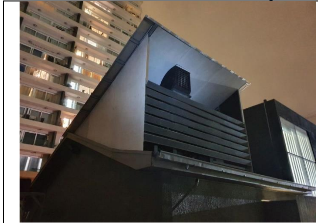
Semiencierro extractor – Vista oriente
