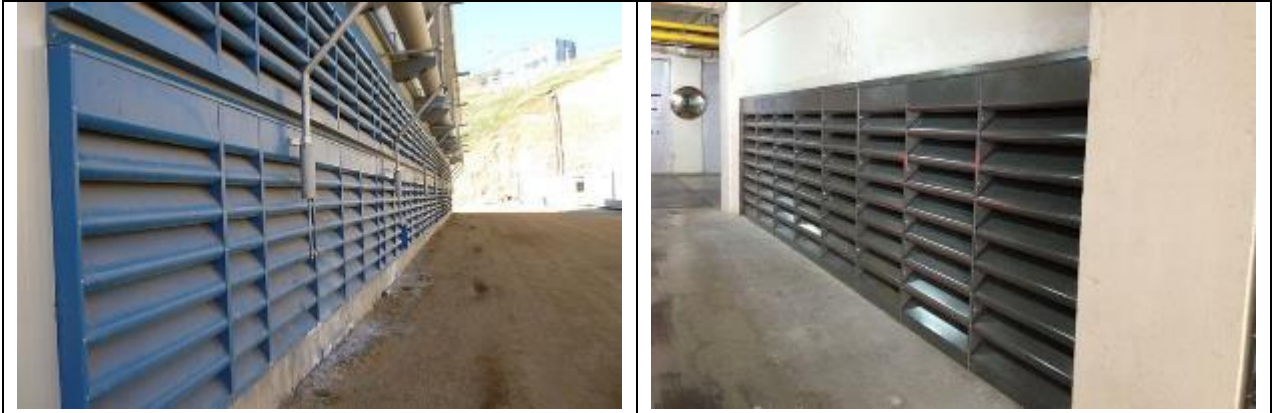
Ilustración 8: Ejemplos de Celosías Acústicas.
