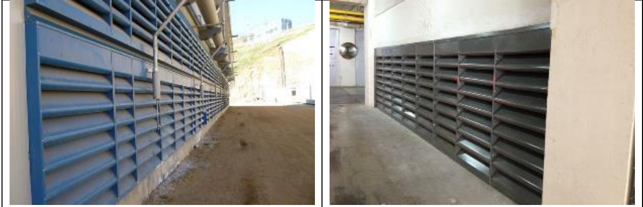
Ilustración 5: Ejemplos de Celosías Acústicas.
