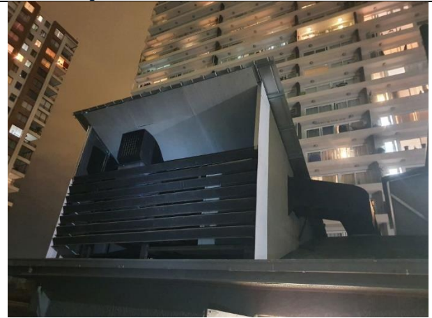
Semiencierro extractor – Vista poniente
