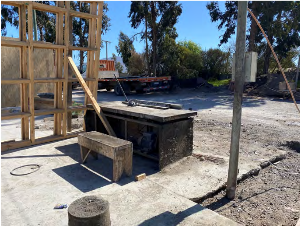
Mesa vibradora N°2
