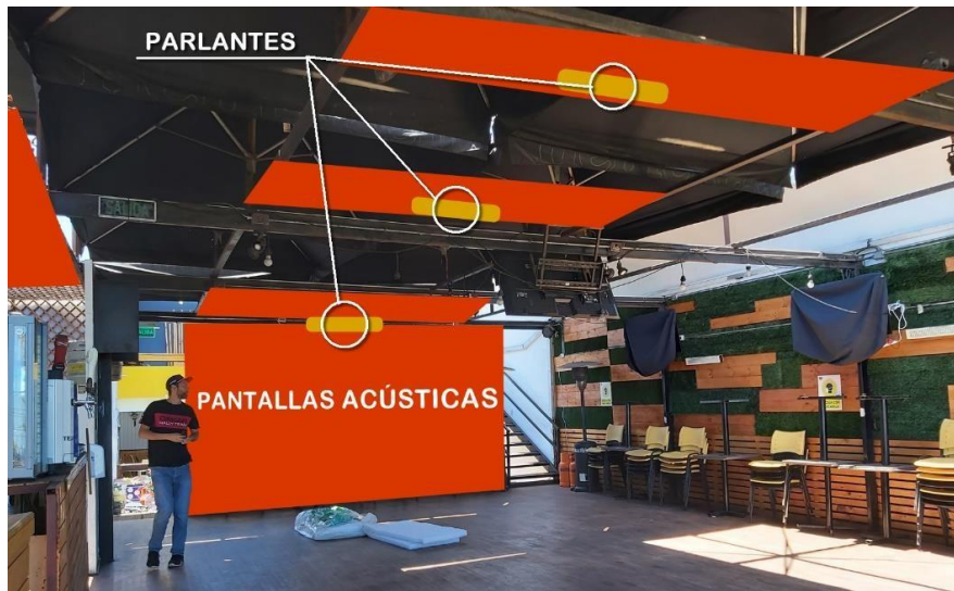
Figura 10. Ubicación de parlantes y pantallas acústicas.
