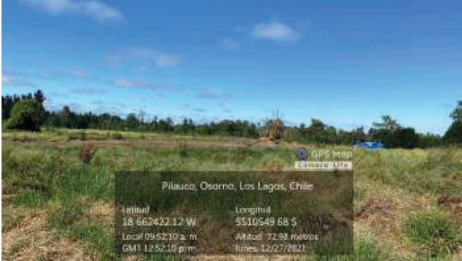
Limpieza de Posas
