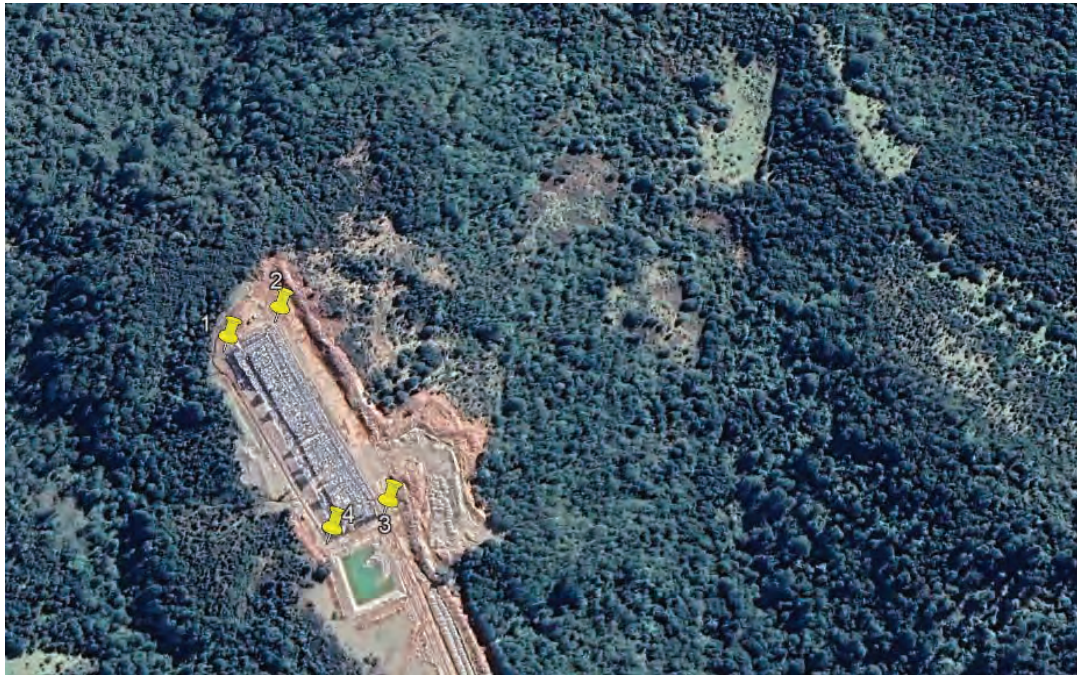
Figura 1. Emplazamiento celda residuos Relleno Sanitario Puntra
