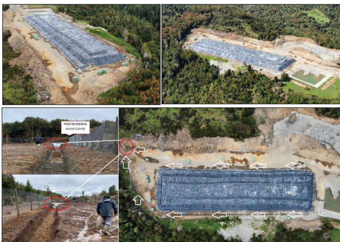
Figura 8. Superficie cubierta del R.S. Puntra (10-11-2021) y esquema de salidas de las aguas lluvias por los canales perimetrales hacia el pozo drenante zona norte.
