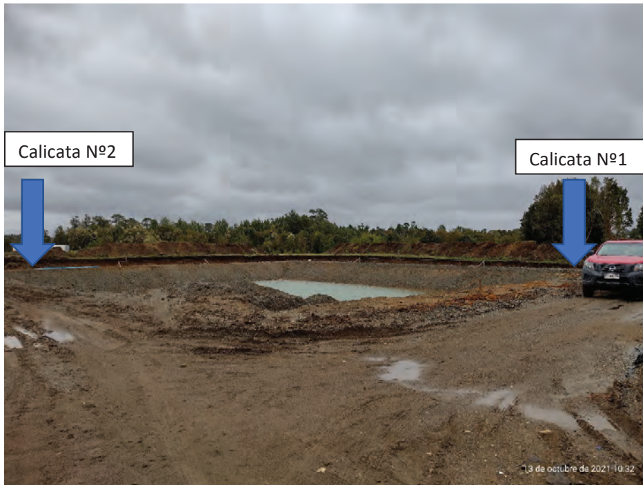
Fotografía 1. Ubicación de calicatas en terreno.
