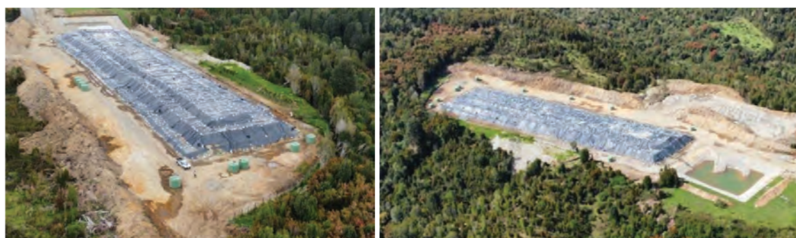
Figura 9. Estado del vertedero cubierta su superficie con polietileno (10-11-2021).
