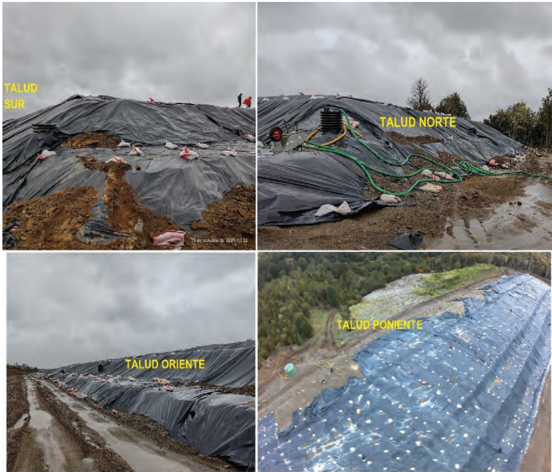
Figura 3. Geometría actual del relleno sanitario Puntra El Roble (13 y 16 de octubre 2021).
