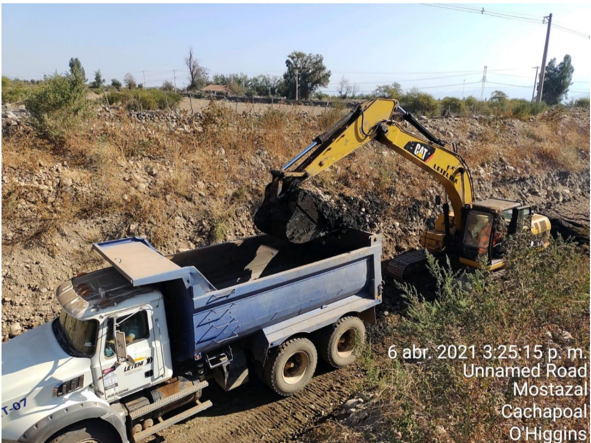
Fotografía 3. Trabajos para despejar el acopio de guano.
