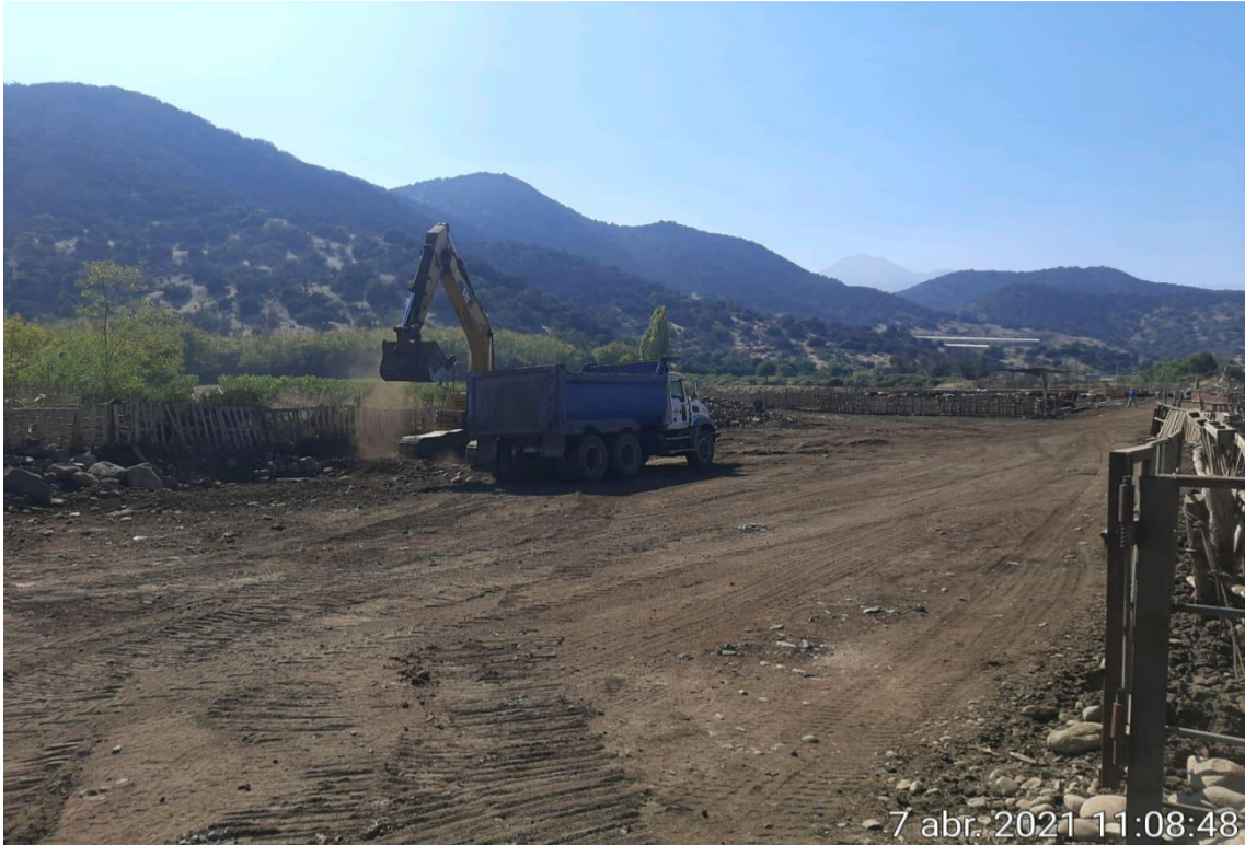
Fotografía Núm. 4 . Trabajos de limpieza del area de acopio de guano .
