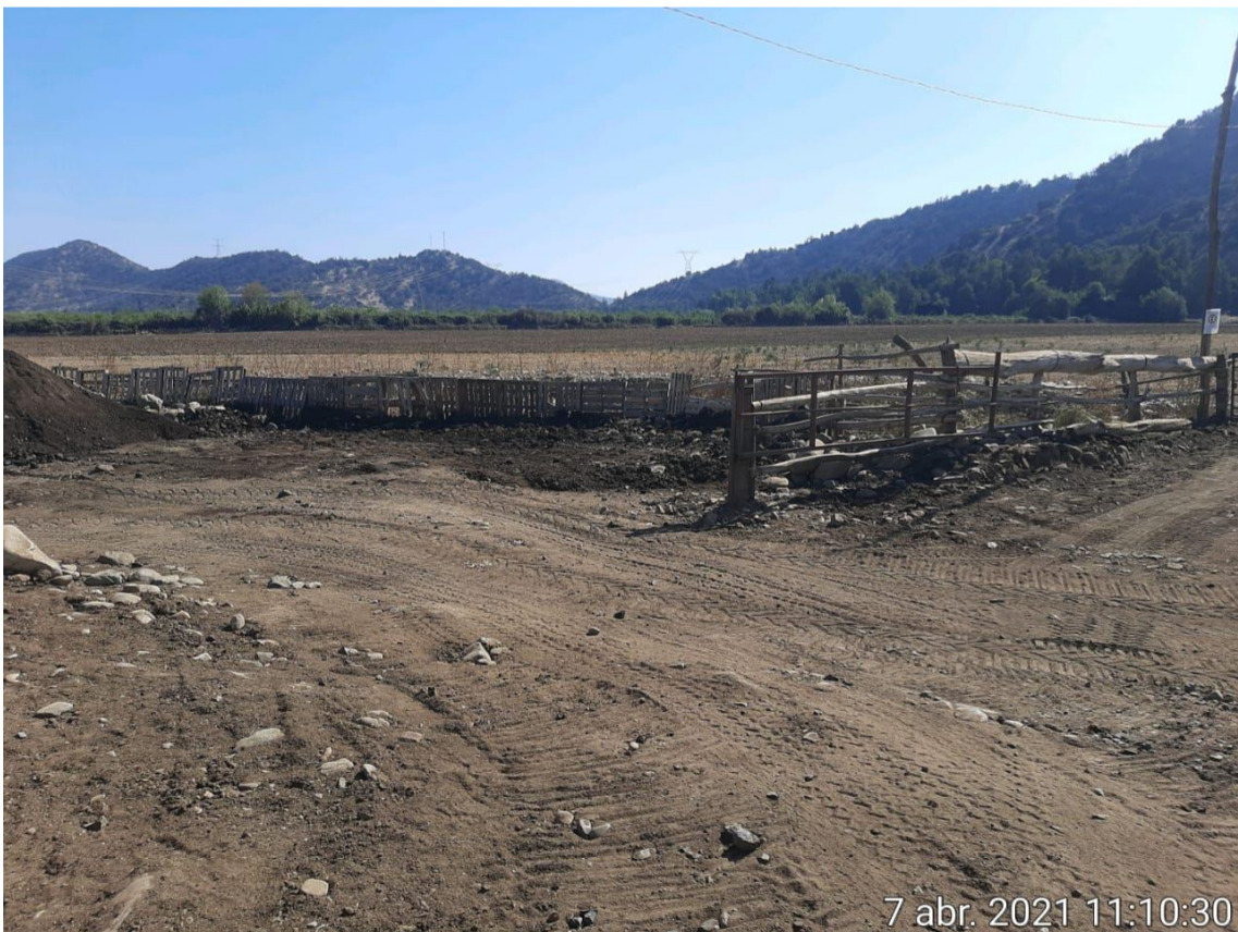
Fotografía Num 5 . Retiro de guano y limpieza del lugar
