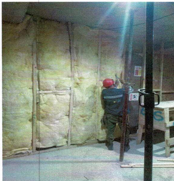
Foto3: Acondicionamiento interior taller
