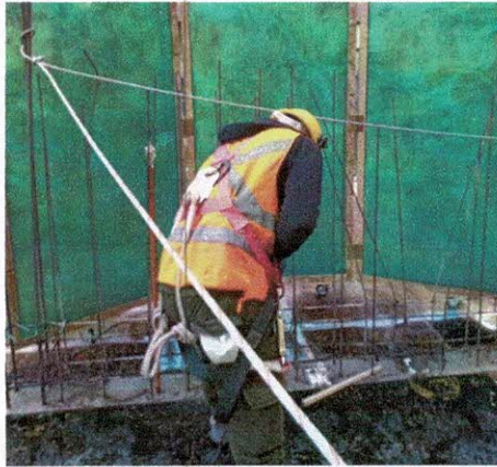
Foto 1: Biombo en labor de picado
