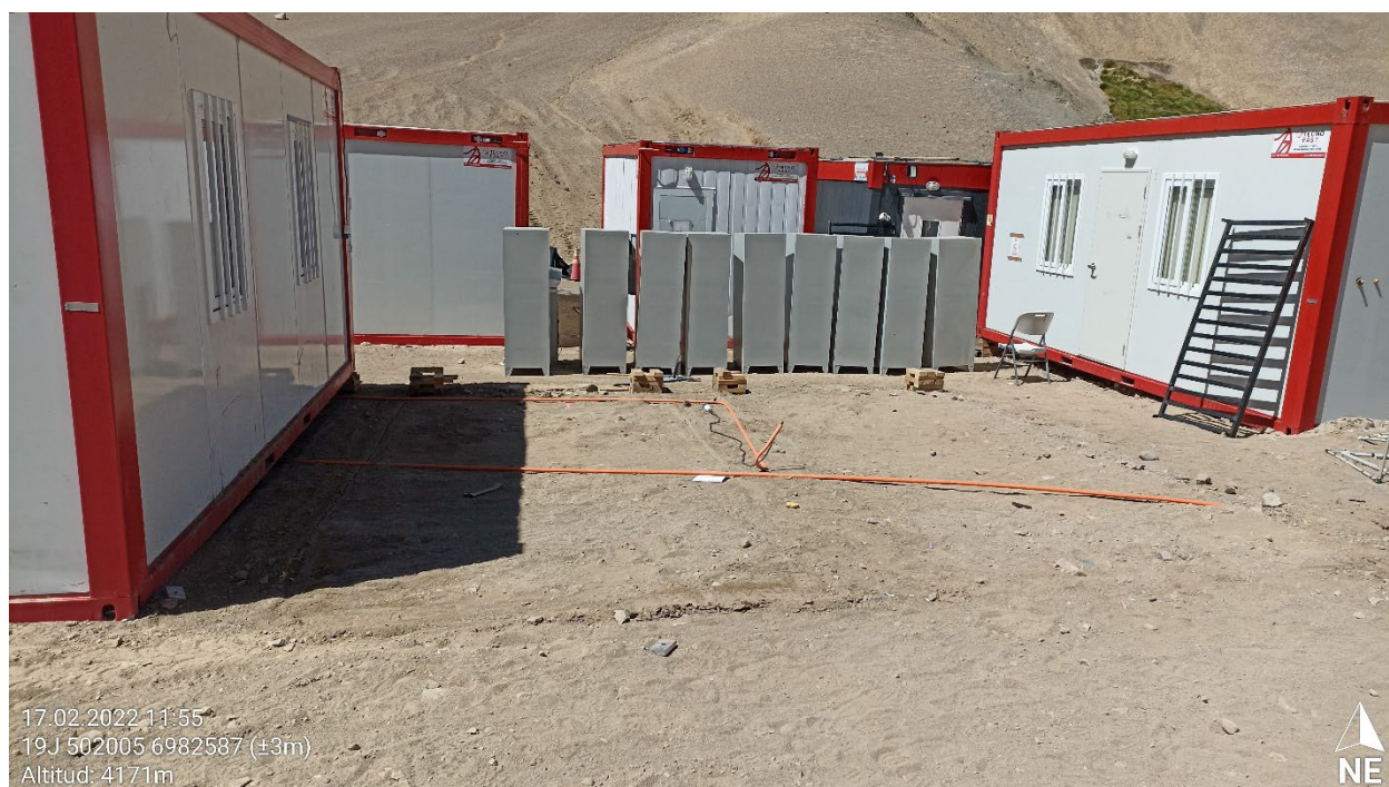
Fotografía 81: Desmovilización del Sistema eléctrico del campamento.
