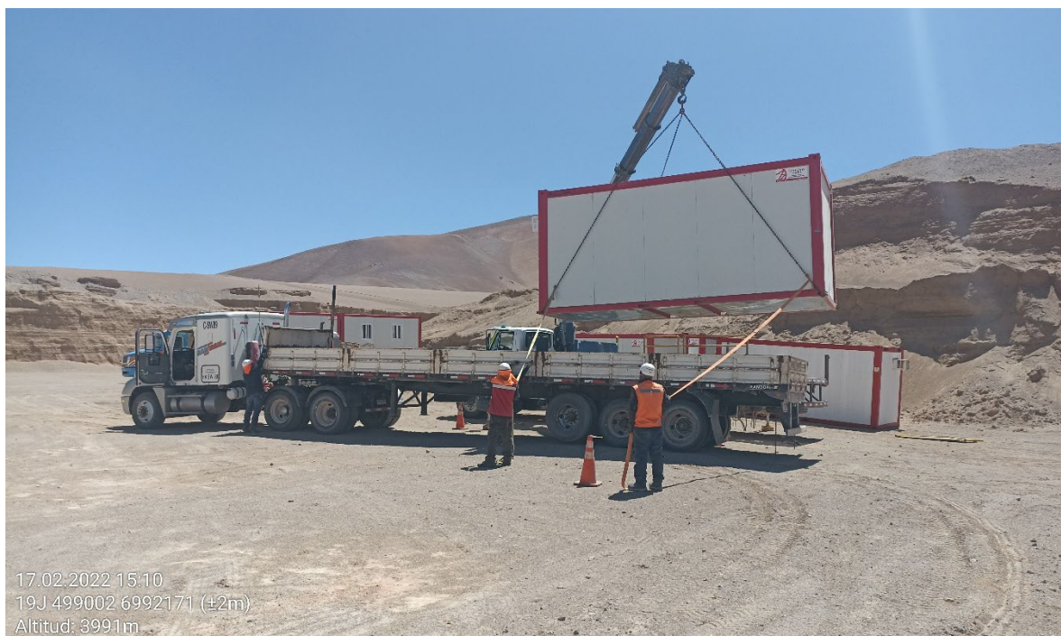
Fotografía 7: Izaje de los módulos del campamento en el sitio de traspaso fuera del sector del Proyecto.
