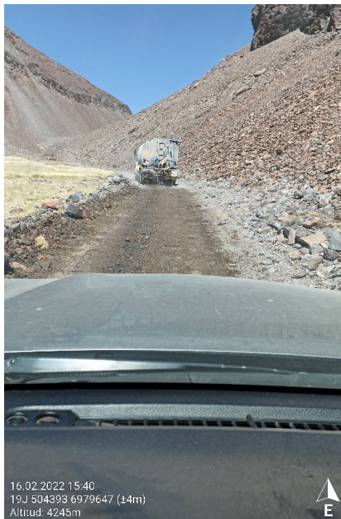
Fotografía 1. Actividad de humectación de camino de acceso realizada el 16 de febrero.
