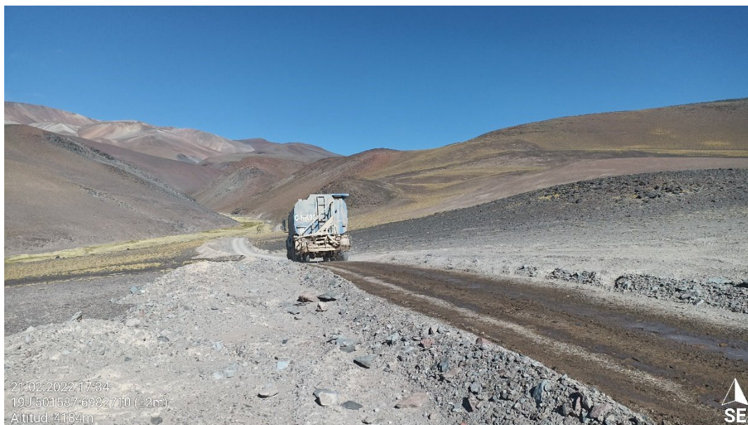
Fotografía 2. Actividad de humectación de camino de acceso realizada el 21 de febrero.
