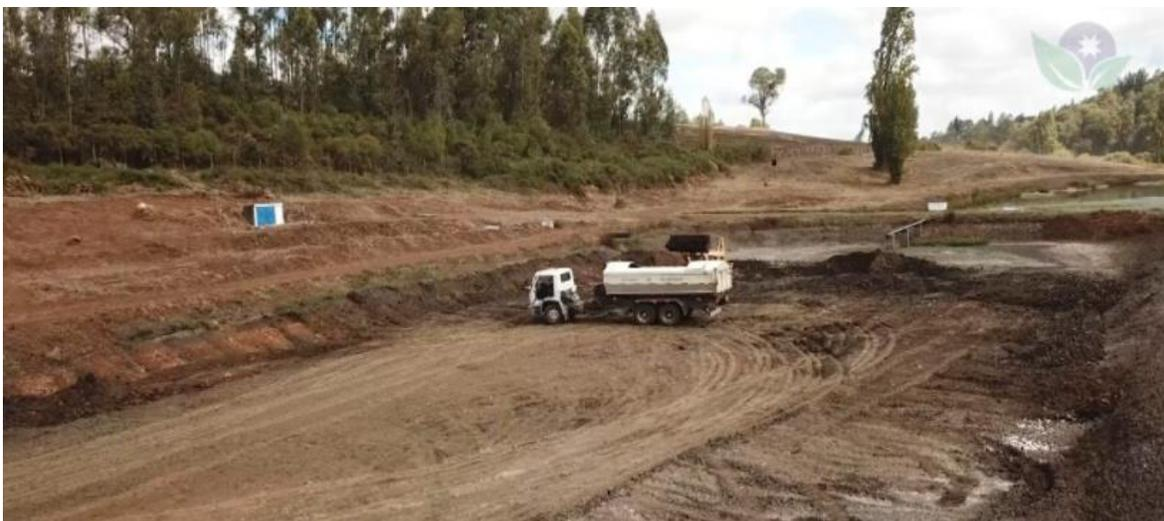
Figura 1. Extracción de lodos laguna N°1 PTAS Perquenco.
