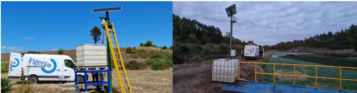
**Figura 10.** Sistema de dosificación provisorio de desinfectante PTAS Perquenco
