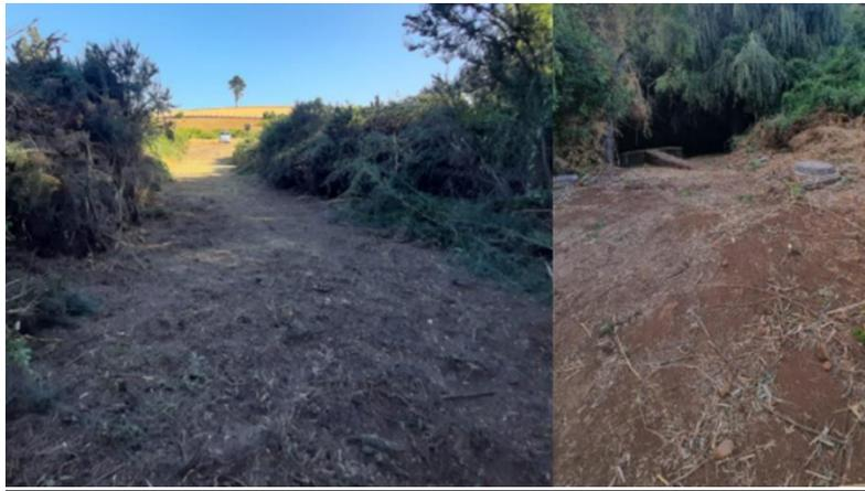
**Figura 14.** Desmalezado acceso descarga Estero Perquenco.
