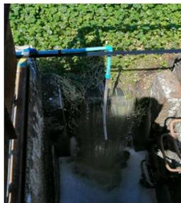
**Figura 11.** Punto de inyección Hipoclorito de Sodio, salida Laguna
