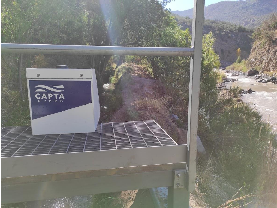
Figura 4: Instalación de CFT Radar en Canal El Manzano, vista trasera
