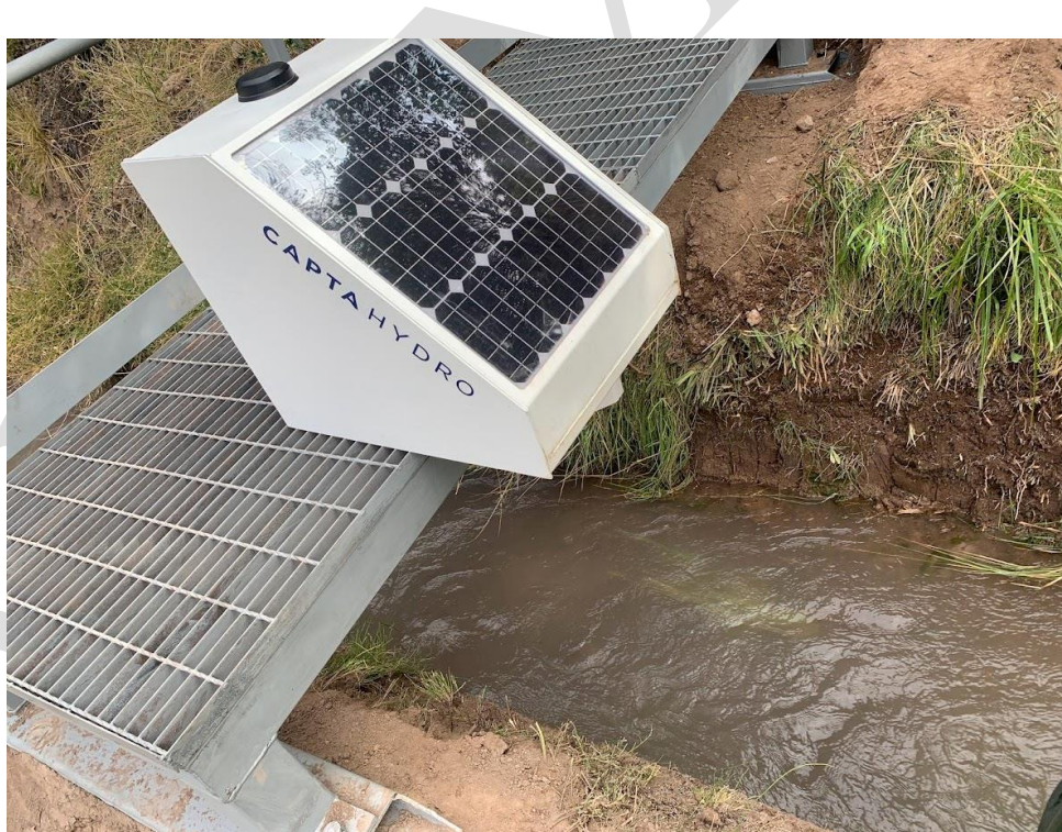
Figura 3: Instalación de CFT Radar en Canal El Manzano, vista lateral
