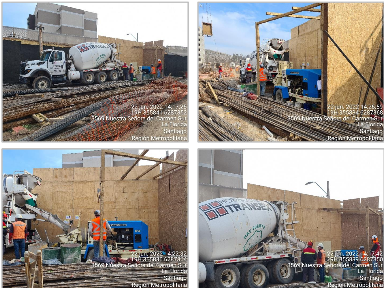
Figura 6: Semi encierro de camión mixer y bomba de hormigón.
