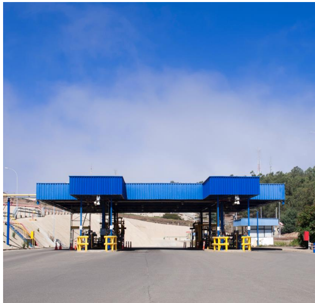
Patio de Carga de Camiones, Terminal Quintero Gasmar
