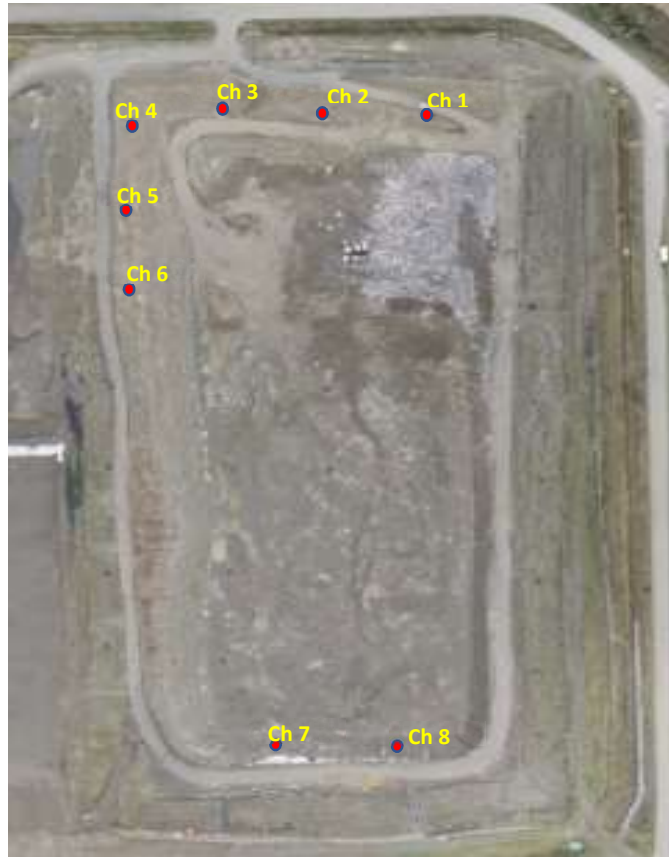
Ilustración 1 Ubicación Chimeneas no unidas a la red de captación de biogás
