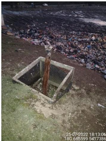
Chimenea lado sur en el empalme con alveolo 2, se debe apagar ya que se esta llegando con la disposición de residuos a ese sector
