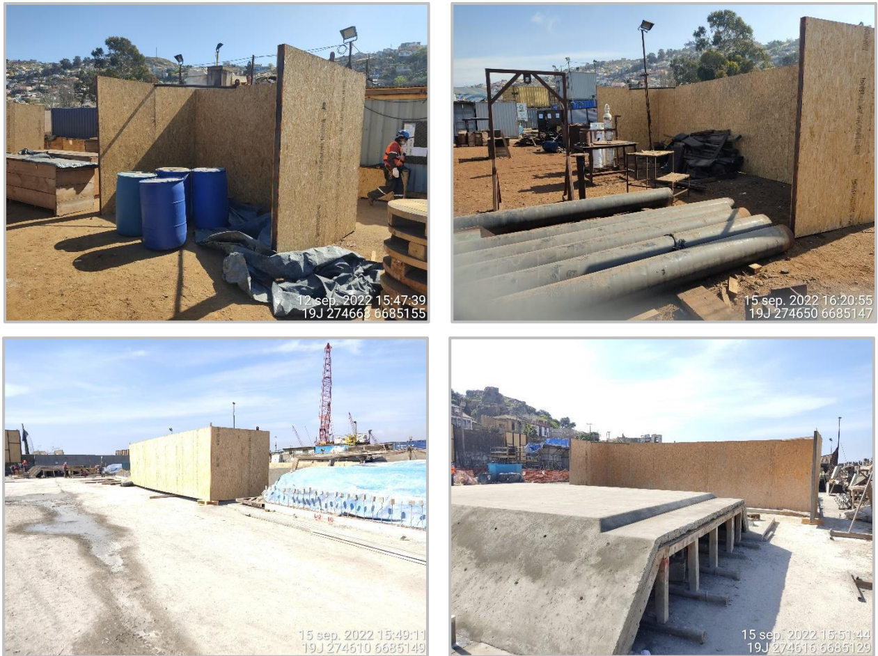
Figura 6: Biombos Acústicos en Patio de Fabricación de Pilotes y Taller de Misceláneos.
