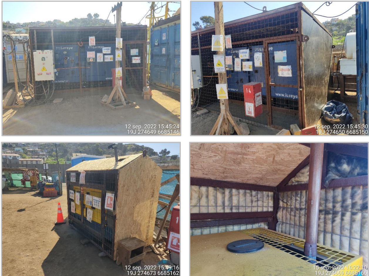
Figura 5: Encierros Acústicos en Grupos Electrónicos en Patio de Fabricación de pilotes y Taller de Misceláneos.
