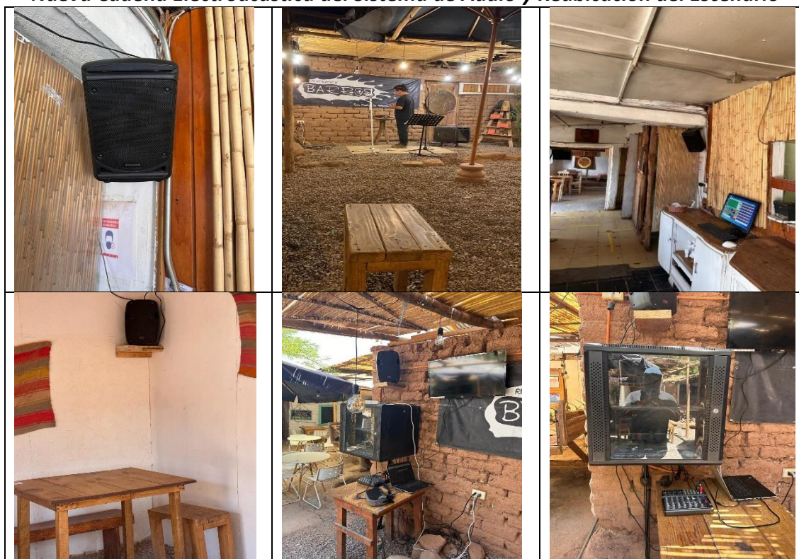
Figura N°5 Registros Fotográficos de la Implementación de Nueva Cadena Electroacústica del Sistema de Audio y Reubicación del Escenario
