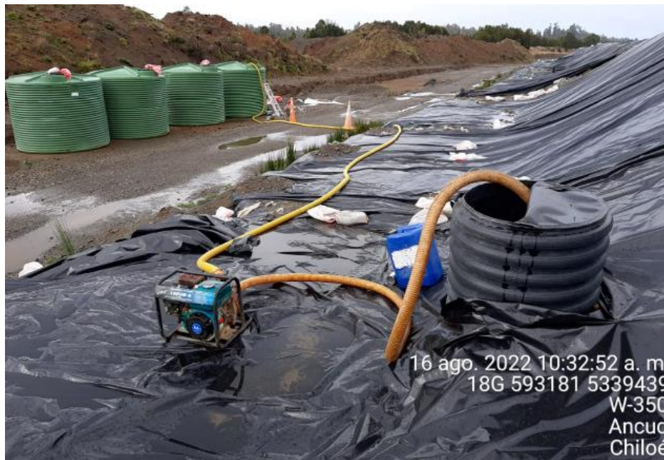
Fotografía N°1: Extracción de Lixiviados desde cámara C12. Tomada: Martes 16 de Agosto del 2022.
