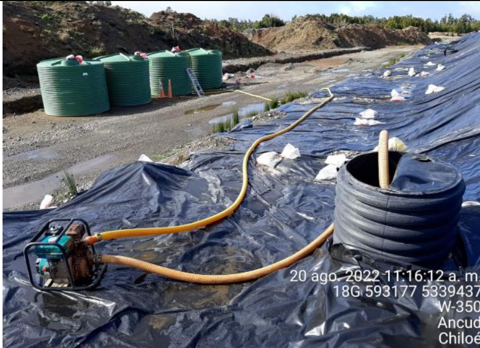
Fotografía N°16: Extracción de Lixiviados desde cámara C12 Tomada: Sábado 20 de Agosto del 2022.
