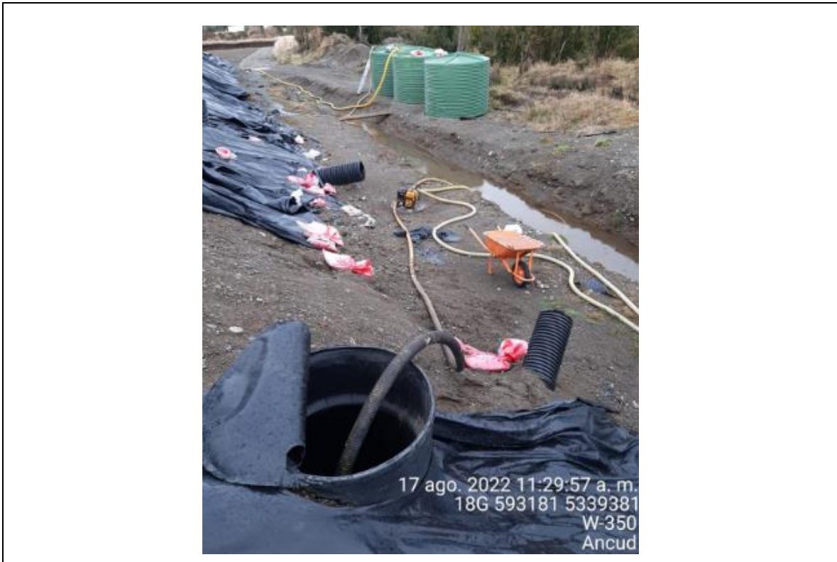
Fotografía N°7: Extracción de Lixiviados desde cámara C03. Tomada: Miércoles 17 de Agosto del 2022.
