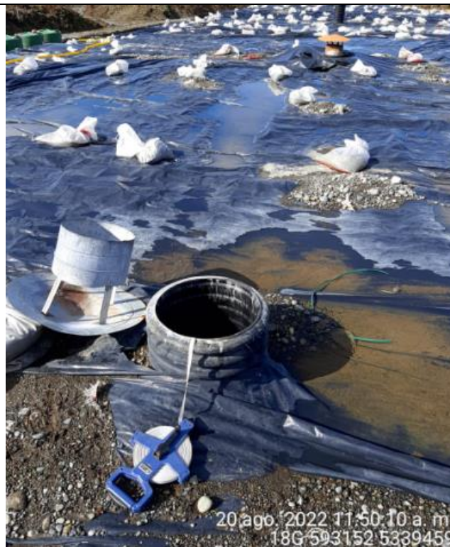
Fotografía N°38: Medición de Niveles de cámaras por Personal Municipal. Tomada: 20 de Agosto del 2022.
