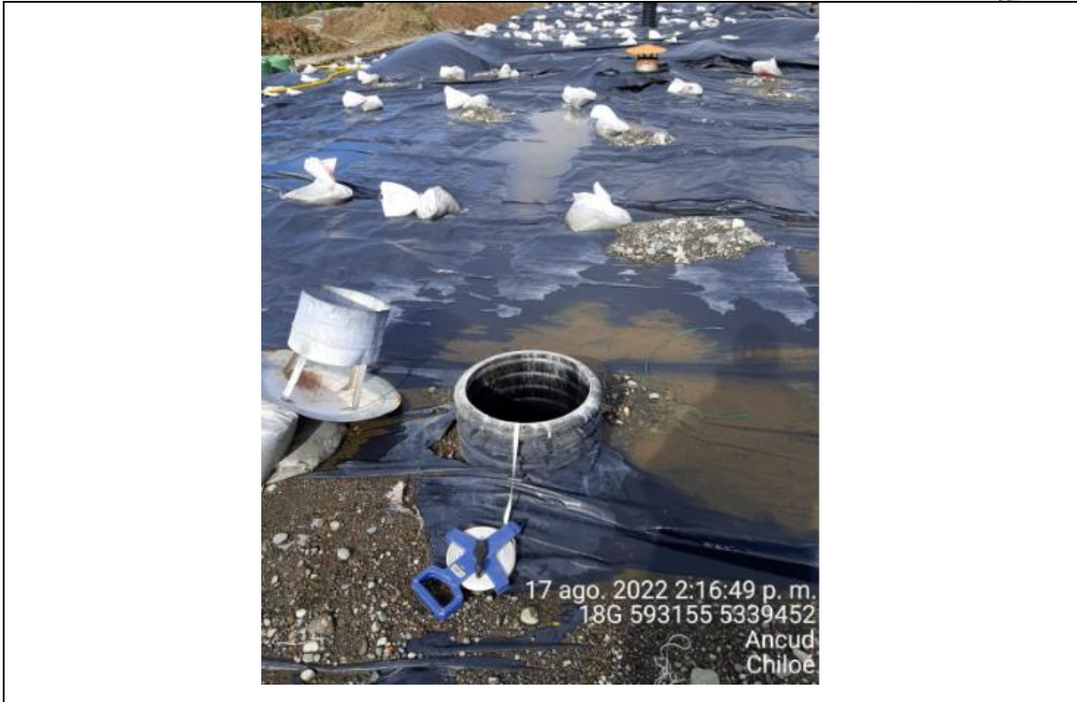
Fotografía N°35: Medición de Niveles de cámaras por Personal Municipal. Tomada: 17 de Agosto del 2022.
