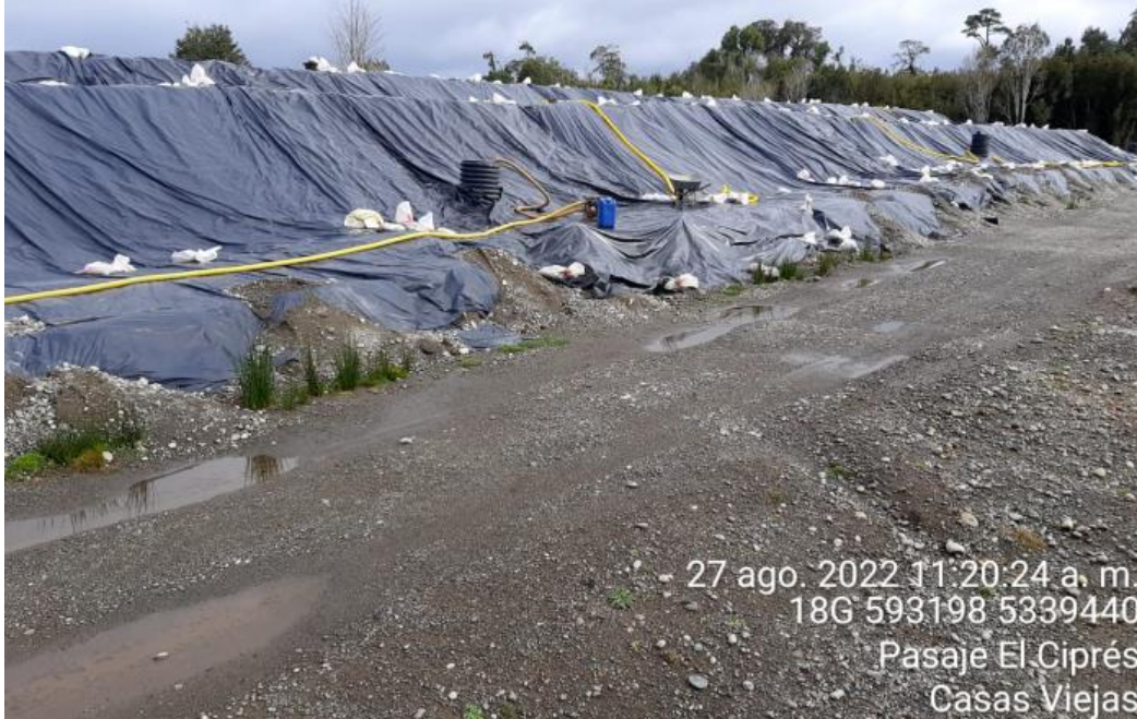
Fotografía N°30: Extracción de Lixiviados cámara C12. Tomada: Sábado 27 de Agosto del 2022.
