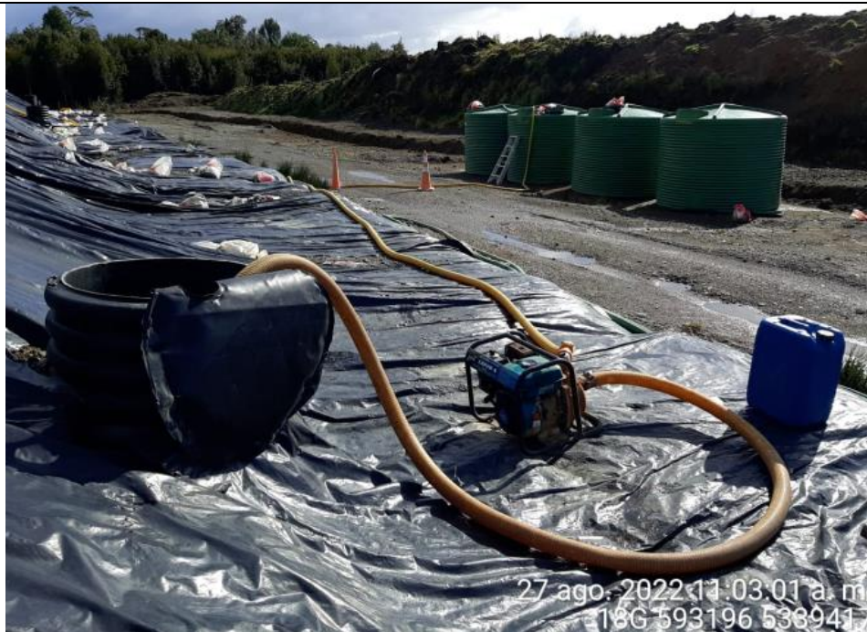
Fotografía N°31: Extracción de Lixiviados cámara C13. Tomada: Sábado 27 de Agosto del 2022.
