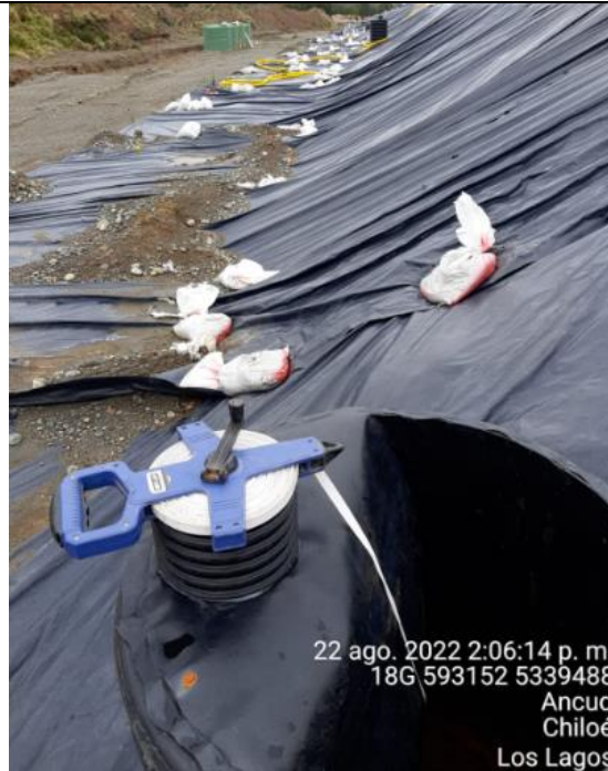
Fotografía N°39: Medición de Niveles de cámaras por Personal Municipal. Tomada: 22 de Agosto del 2022.
