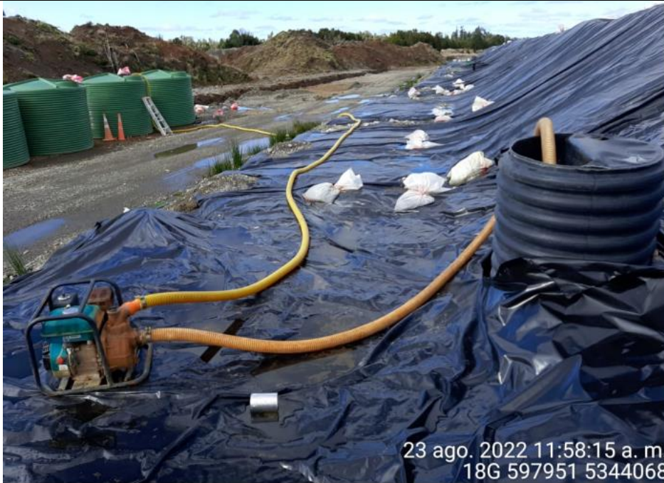
Fotografía N°21: Extracción de Lixiviados desde Cámara C12. Tomada: Martes 23 de Agosto del 2022.
