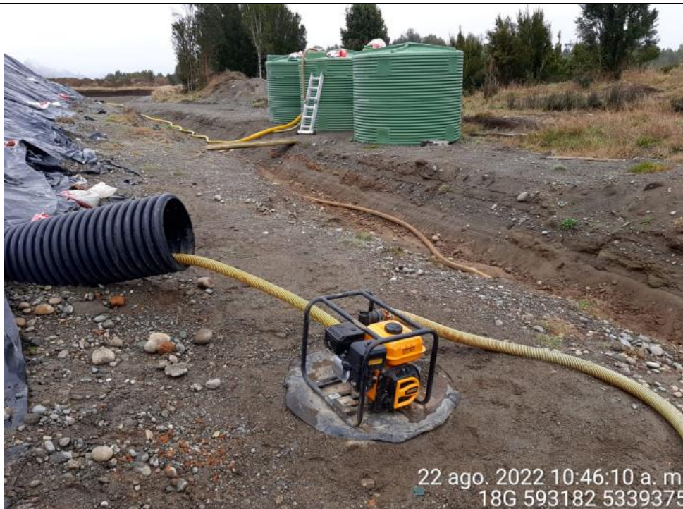
Fotografía N°19: Extracción de Lixiviados desde diagonal D02. Tomada: Lunes 22 de Agosto del 2022.
