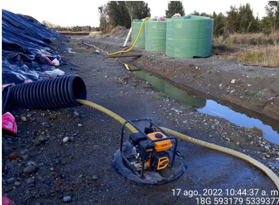
Fotografía N°5: Extracción de Lixiviados desde diagonal D02. Tomada: Miércoles 17 de Agosto del 2022.
