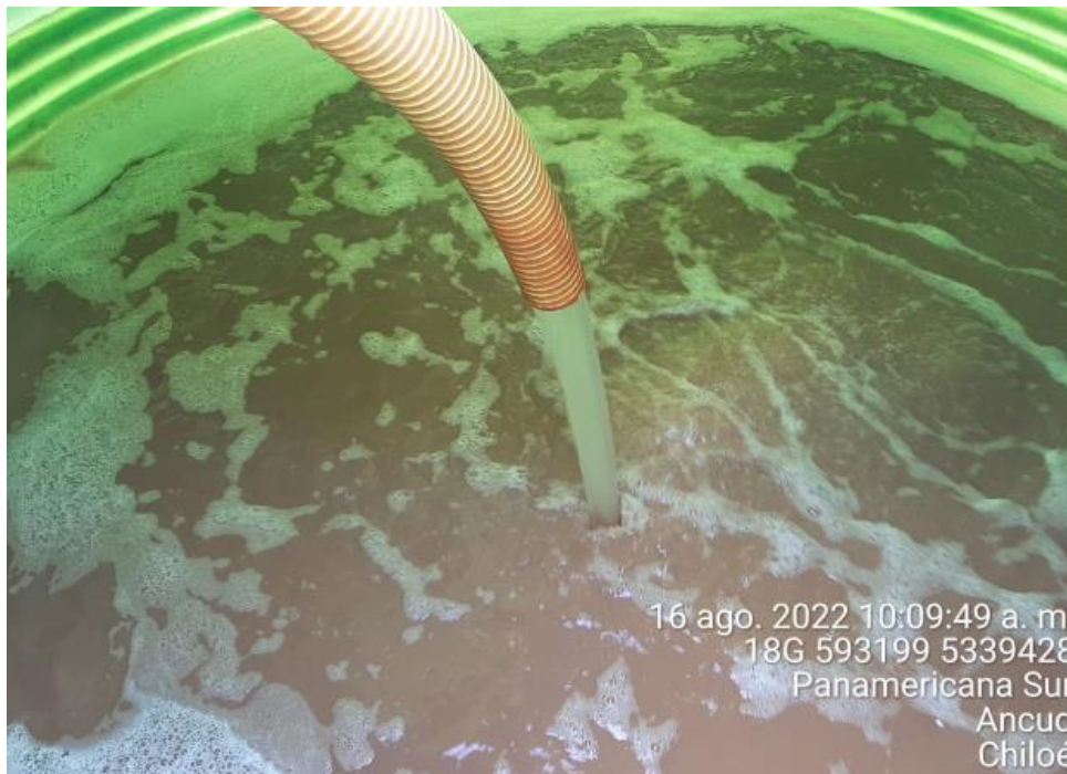
Fotografía N°3: Extracción de Lixiviados a estanque por personal municipal. Tomada: Martes 16 de Agosto del 2022.
