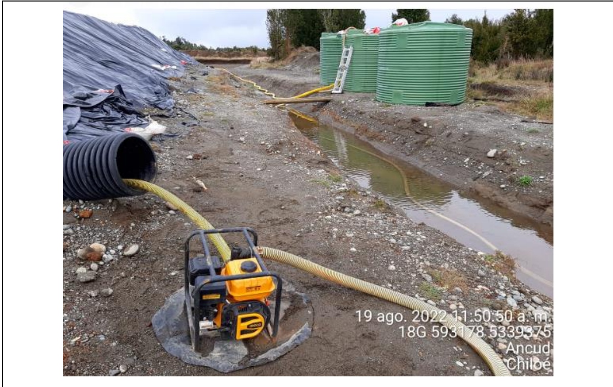
Fotografía N°12: Extracción de Lixiviados desde diagonal D02. Tomada: Viernes 19 de Agosto del 2022.
