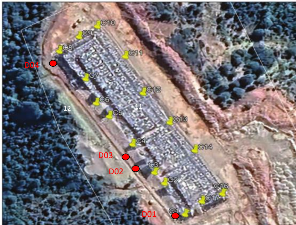
Fotografía N°33: Zanja Sanitaria N°1. Imagen Aérea I. Municipalidad de Ancud.
