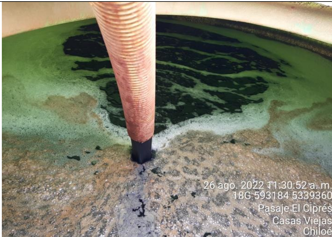
Fotografía N°29: Extracción de Lixiviados a estanque. Tomada: Viernes 26 de Agosto del 2022.
