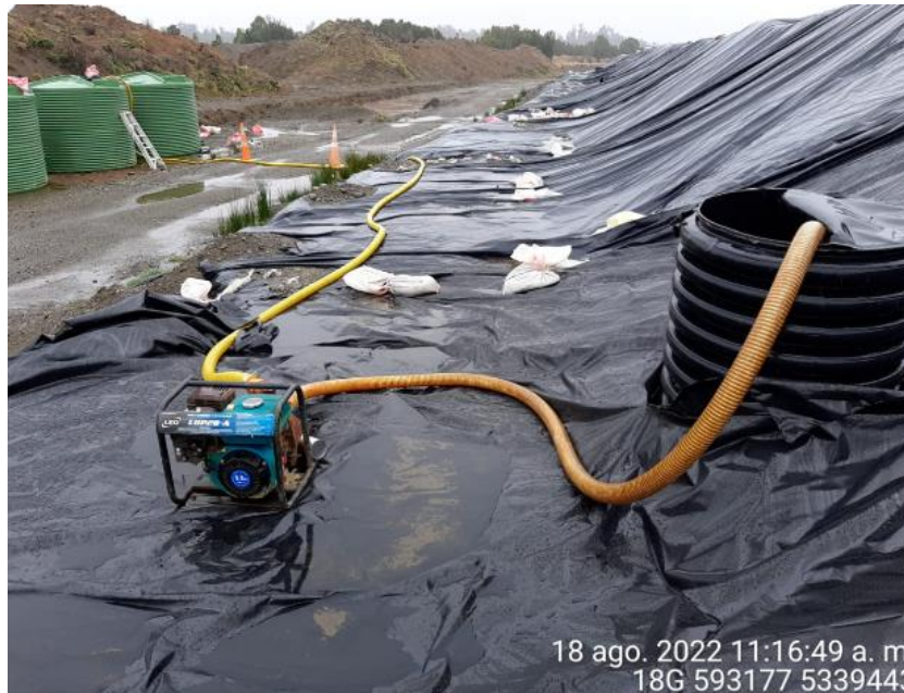
Fotografía N°09: Extracción de Lixiviados desde cámara C12 por personal municipal. Tomada: Jueves 18 de Agosto del 2022.
