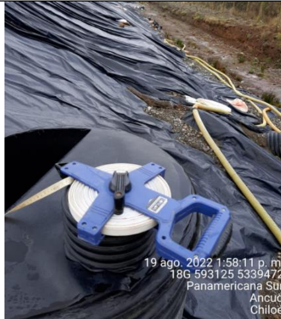
Fotografía N°37: Medición de Niveles de cámaras por Personal Municipal. Tomada: 19 de Agosto del 2022.
