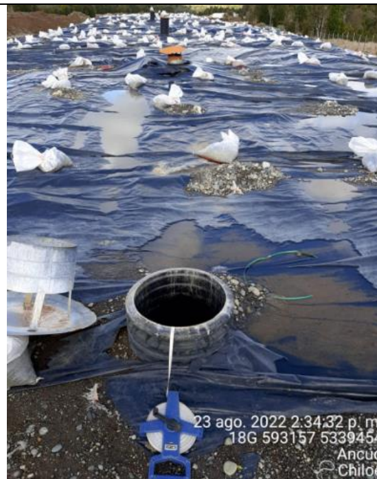
Fotografía N°40: Medición de Niveles de cámaras por Personal Municipal. Tomada: 23 de Agosto del 2022.
