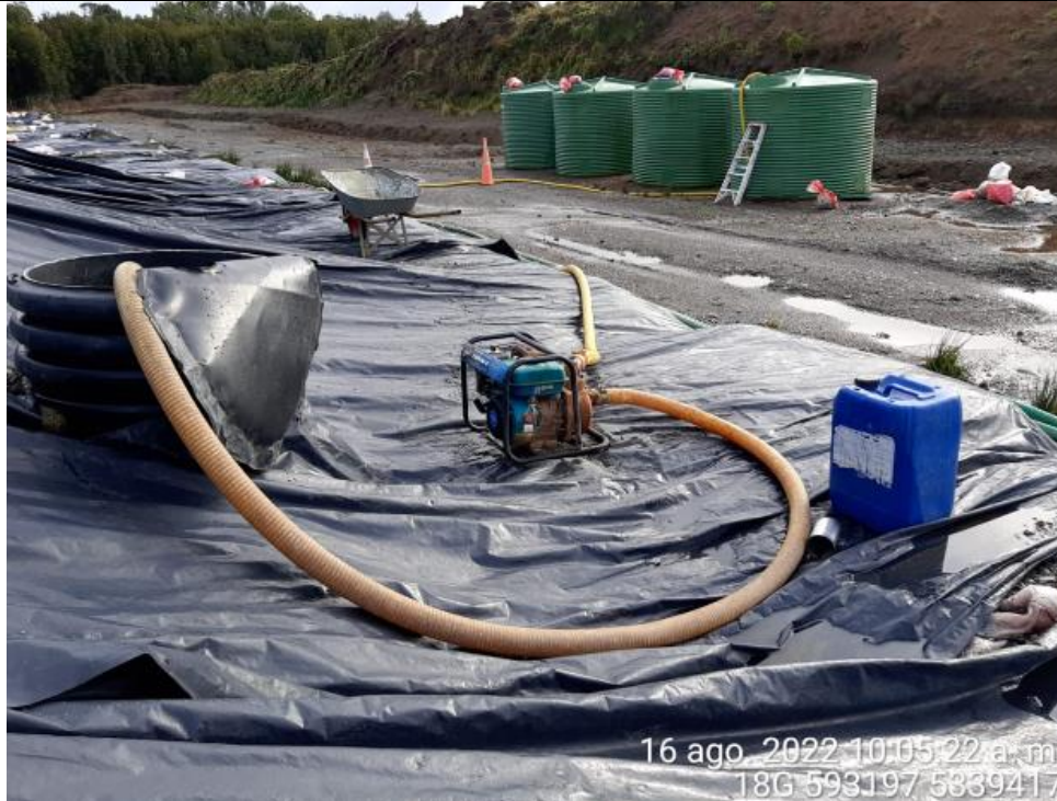
Fotografía N°2: Extracción de Lixiviados desde cámara C13. Tomada: Martes 16 de Agosto del 2022.
