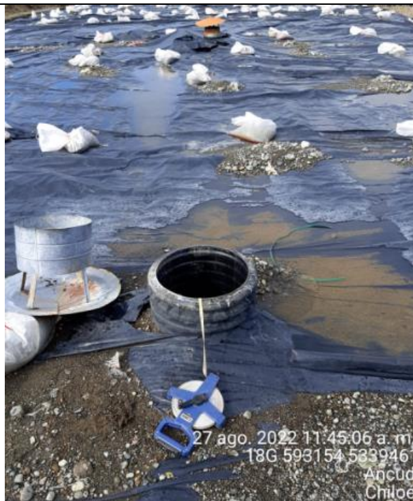
Fotografía N°44: Medición de Niveles de cámaras por Personal Municipal. Tomada: 27 de Agosto del 2022.
