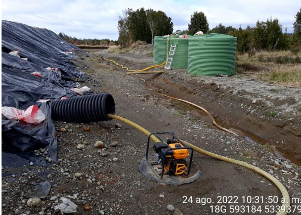
Fotografía N°24: Extracción de Lixiviados desde diagonal D2 Tomada: Miércoles 24 de Agosto del 2022.
