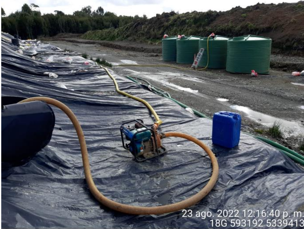
Fotografía N°22: Extracción de Lixiviados desde Cámara C13. Tomada: Martes 23 de Agosto del 2022.
