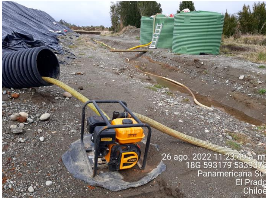
Fotografía N°28: Extracción de Lixiviados diagonal. Tomada: Viernes 26 de Agosto del 2022.
