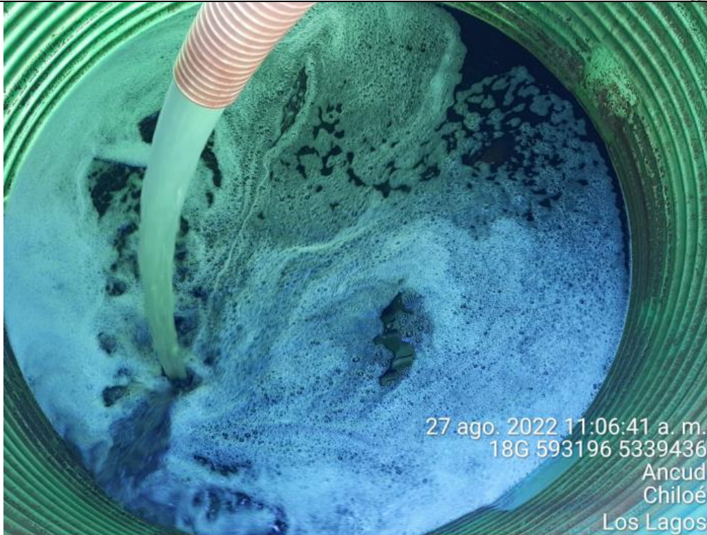
Fotografía N°32: Extracción de Lixiviados a estanque. Tomada: Sábado 27 de Agosto del 2022.
