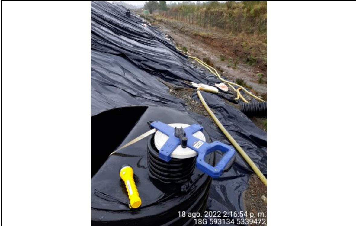
Fotografía N°36: Medición de Niveles de cámaras por Personal Municipal. Tomada: 18 de Agosto del 2022.
