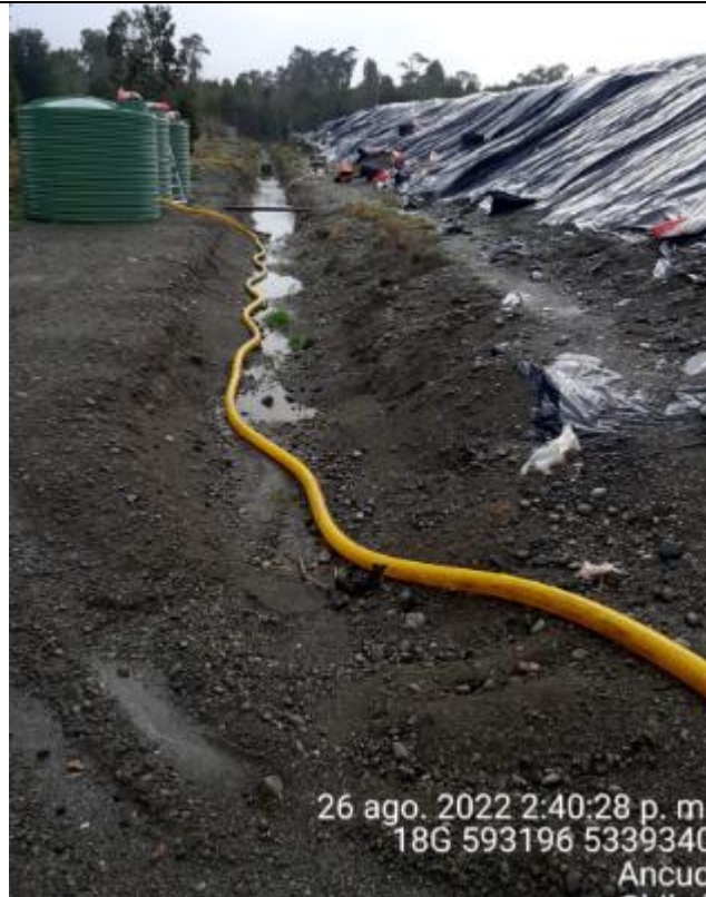
Fotografía N°54: Estado canales aguas lluvias
