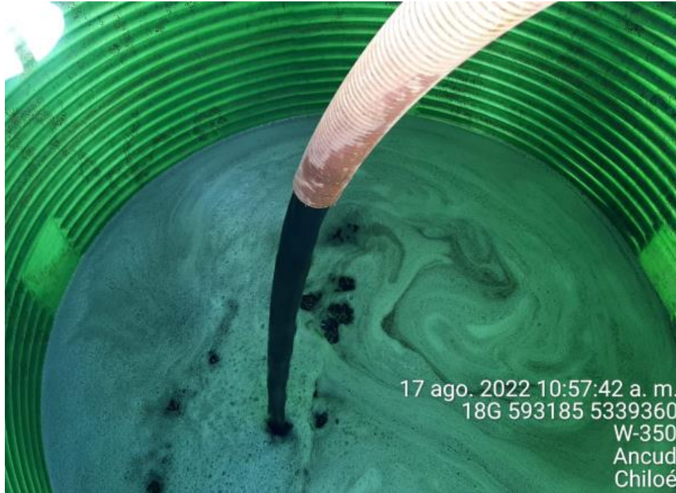
Fotografía N°8: Extracción de Lixiviados a estanque por personal municipal. Tomada: Miércoles 17 de Agosto del 2022.
