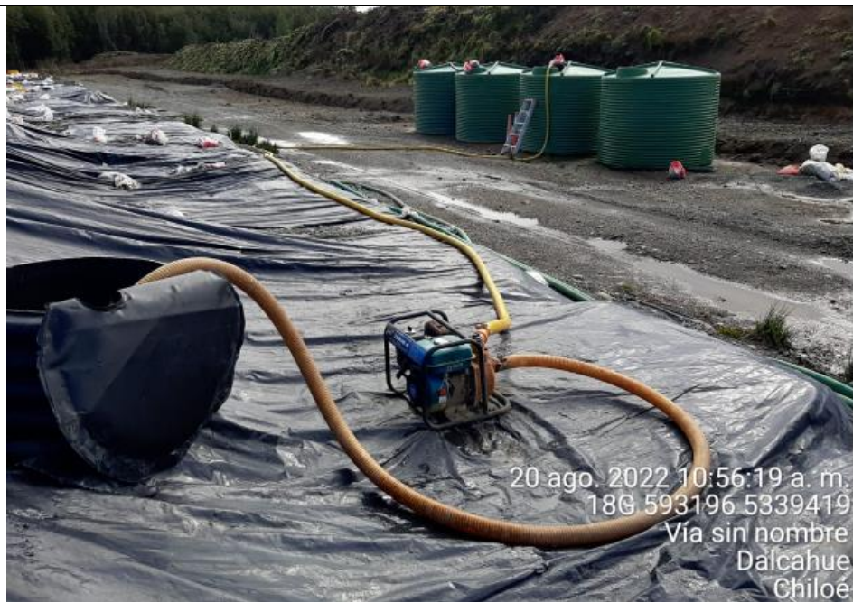
Fotografía N°17: Extracción de Lixiviados desde cámara C13. Tomada: Sábado 20 de Agosto del 2022.
