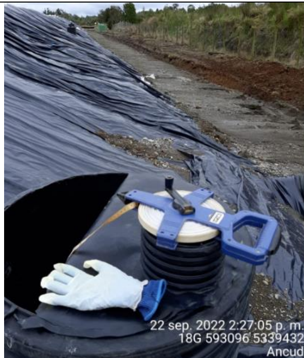
Fotografía N°21: Medición de Niveles de cámaras por Personal Municipal. Tomada: 22 de Septiembre del 2022.
