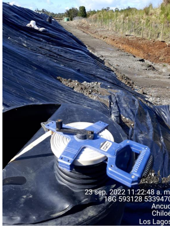
Fotografía N°22: Medición de Niveles de cámaras por Personal Municipal. Tomada: 23 de Septiembre del 2022.
