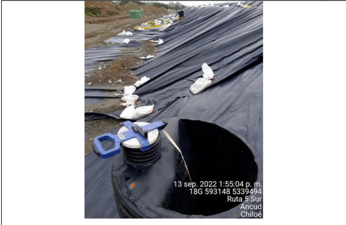
Fotografía N°16: Medición de Niveles de cámaras por Personal Municipal. Tomada: 13 de Septiembre del 2022.
