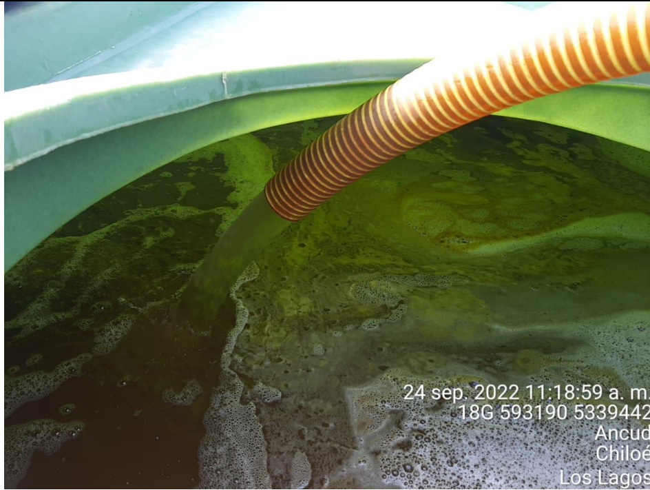
Fotografía N°12: Extracción de Lixiviados a estanque. Tomada: Sábado 24 de Septiembre del 2022.
