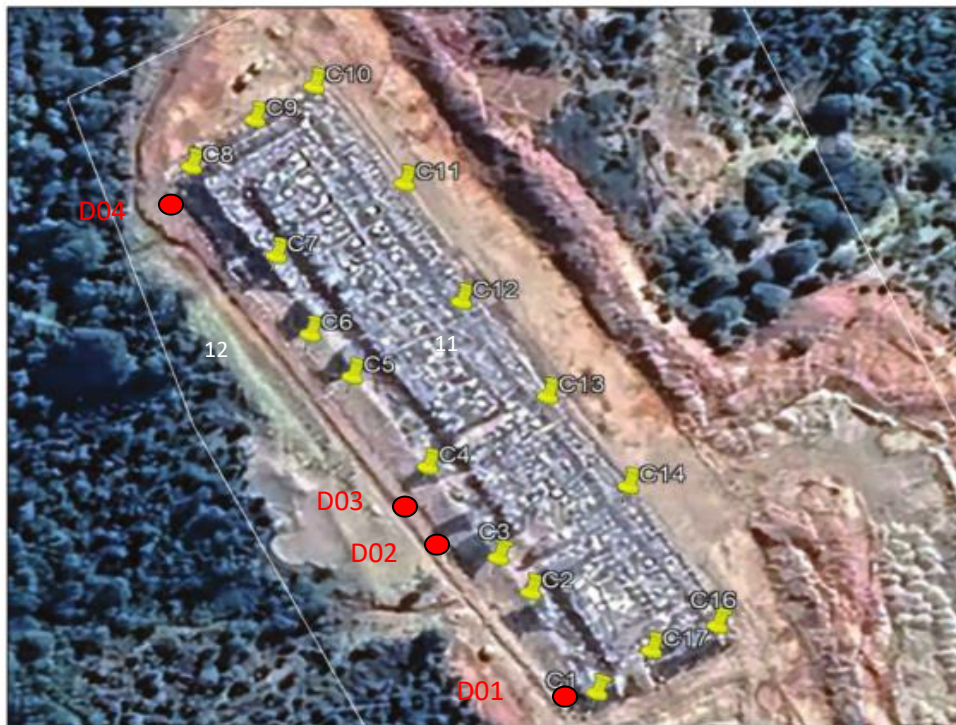
Fotografía N°14: Zanja Sanitaria N°1. Imagen Aérea I. Municipalidad de Ancud.
