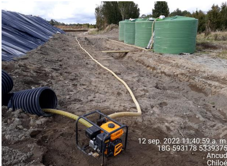
Fotografía N°1: Extracción de Lixiviados desde diagonal D02. Tomada: Lunes 12 de Septiembre del 2022.
