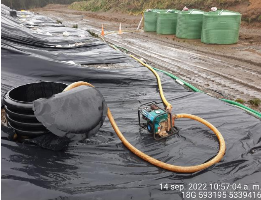
Fotografía N°4: Extracción de Lixiviados desde cámara C13 por personal municipal. Tomada: Miércoles 14 de Septiembre del 2022.
