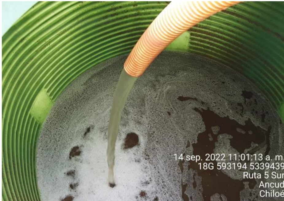
Fotografía N°5: Extracción de Lixiviados a estanque por personal municipal. Tomada: Miércoles 14 de Septiembre del 2022.
