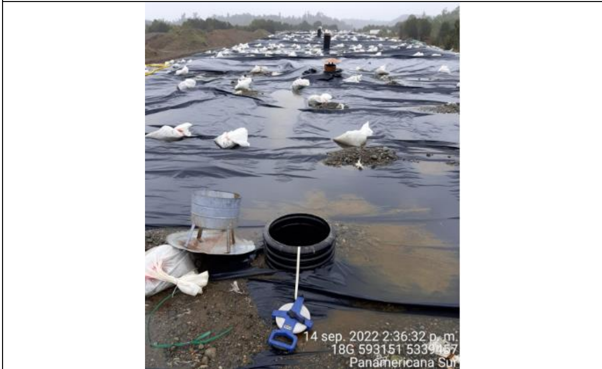
Fotografía N°17: Medición de Niveles de cámaras por Personal Municipal. Tomada: 14 de Septiembre del 2022.
