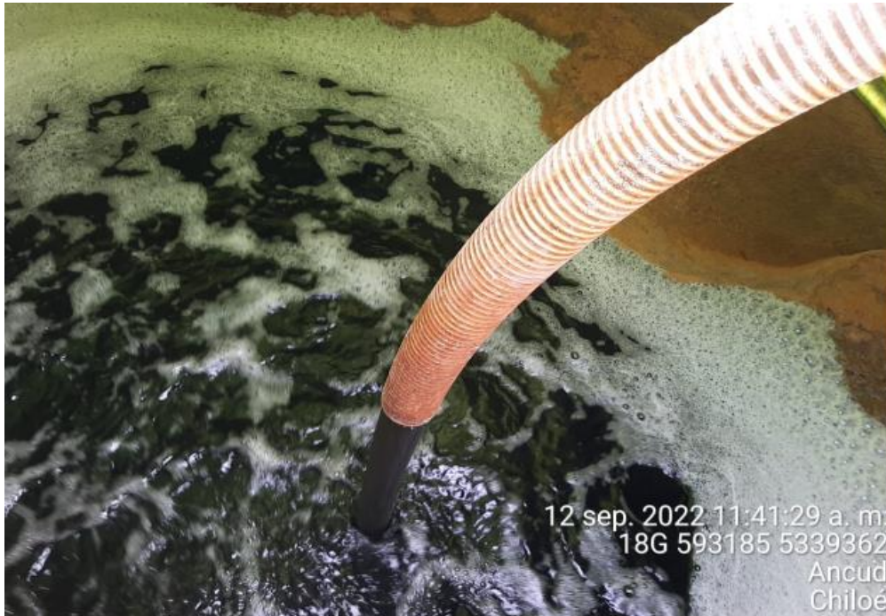
Fotografía N°2: Extracción de Lixiviados a estanque por personal municipal. Tomada: Lunes 12 de Septiembre del 2022.
