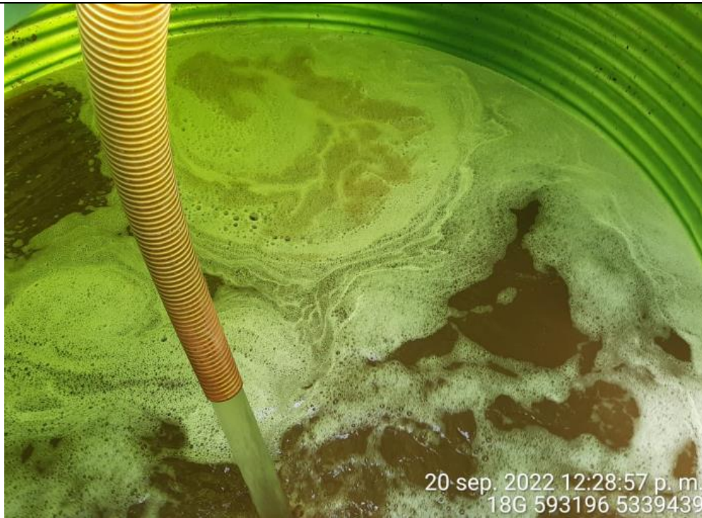
Fotografía N°9: Extracción de Lixiviados a estanque. Tomada: Martes 20 de Septiembre del 2022.
