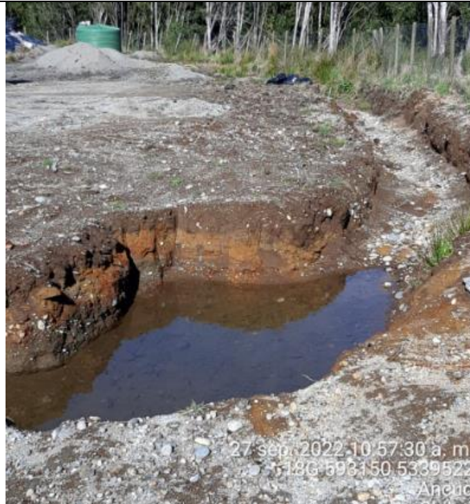
Fotografía N°30: Estado canales aguas lluvias
