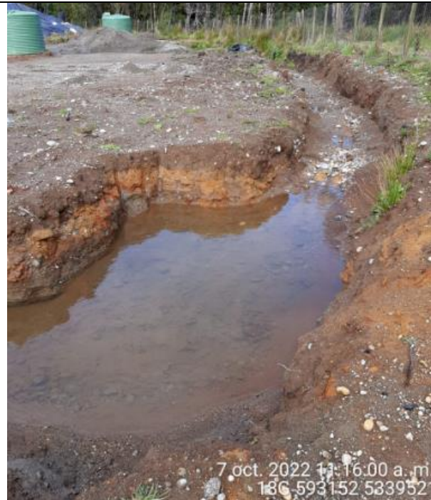
Fotografía N°39: Estado canales aguas lluvias
