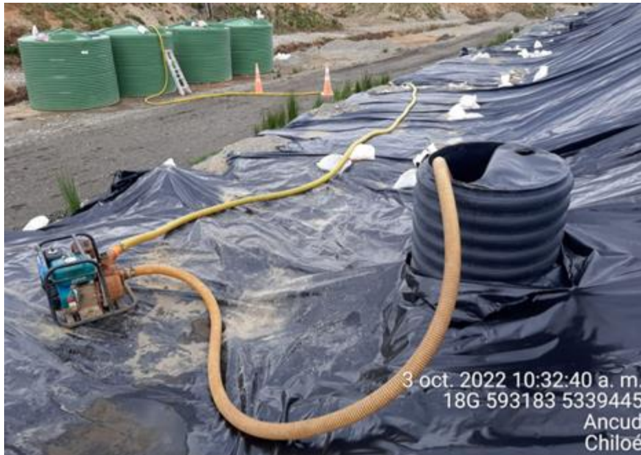
Fotografía N°9: Extracción de Lixiviados desde cámara C12 por personal municipal. Tomada: Lunes 03 de Octubre del 2022.
