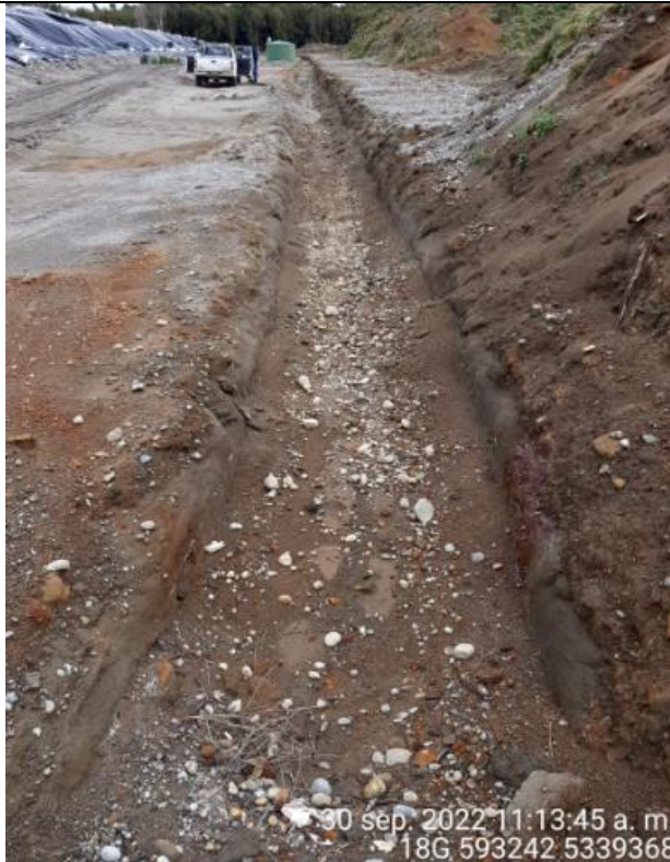
Fotografía N°33: Estado canales aguas lluvias
