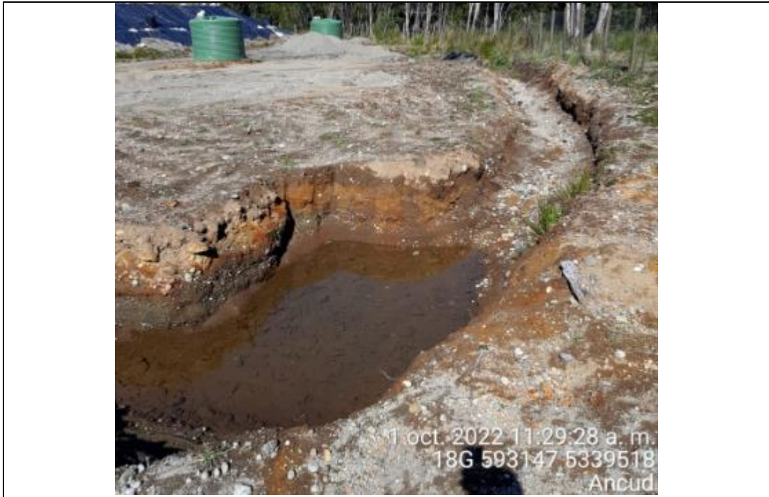
Fotografía N°34: Estado canales aguas lluvias
