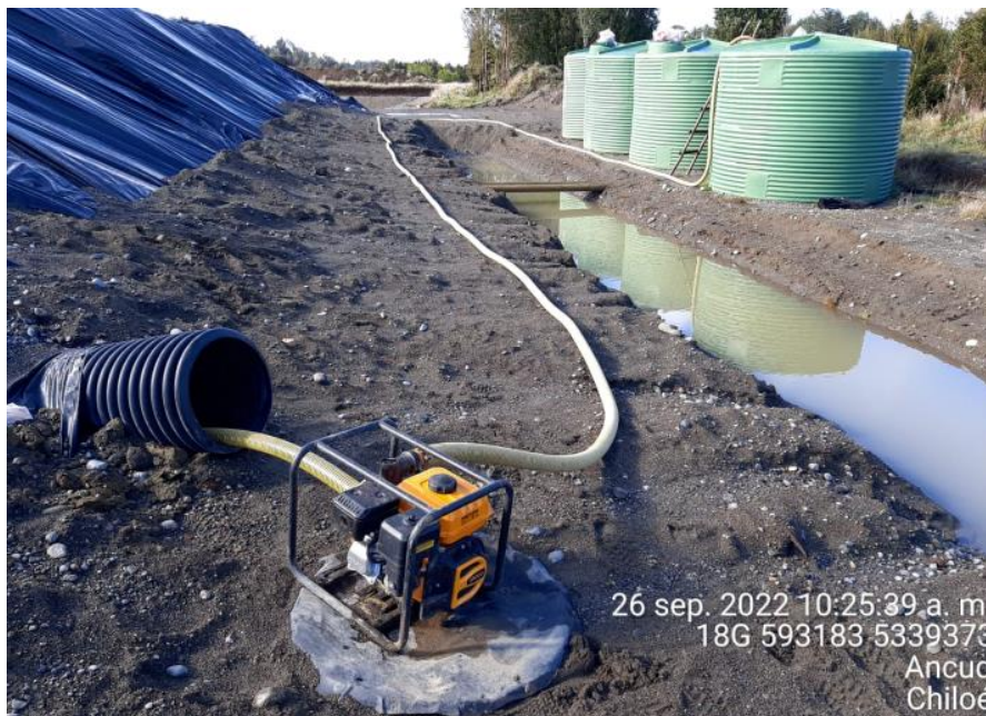
Fotografía N°1: Extracción de Lixiviados desde diagonal D02. Tomada: Lunes 26 de Septiembre del 2022.
