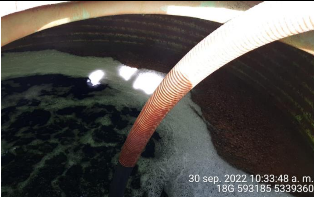
Fotografía N°8: Extracción de Lixiviados a estanque. Tomada: Viernes 30 de Septiembre del 2022.
