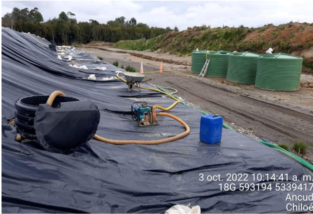
Fotografía N°10: Extracción de Lixiviados desde cámara C13 por personal municipal. Tomada: Lunes 03 de Octubre del 2022.
