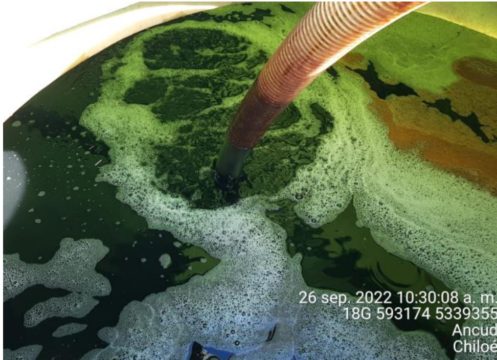
Fotografía N°2: Extracción de Lixiviados a estanque por personal municipal. Tomada: Lunes 26 de Septiembre del 2022.
