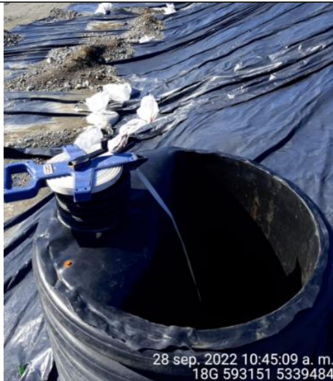
Fotografía N°19: Medición de Niveles de cámaras por Personal Municipal. Tomada: 28 de Septiembre del 2022.
