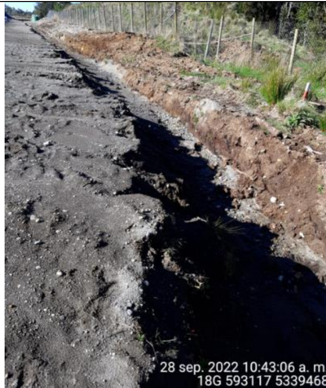
Fotografía N°31: Estado canales aguas lluvias
