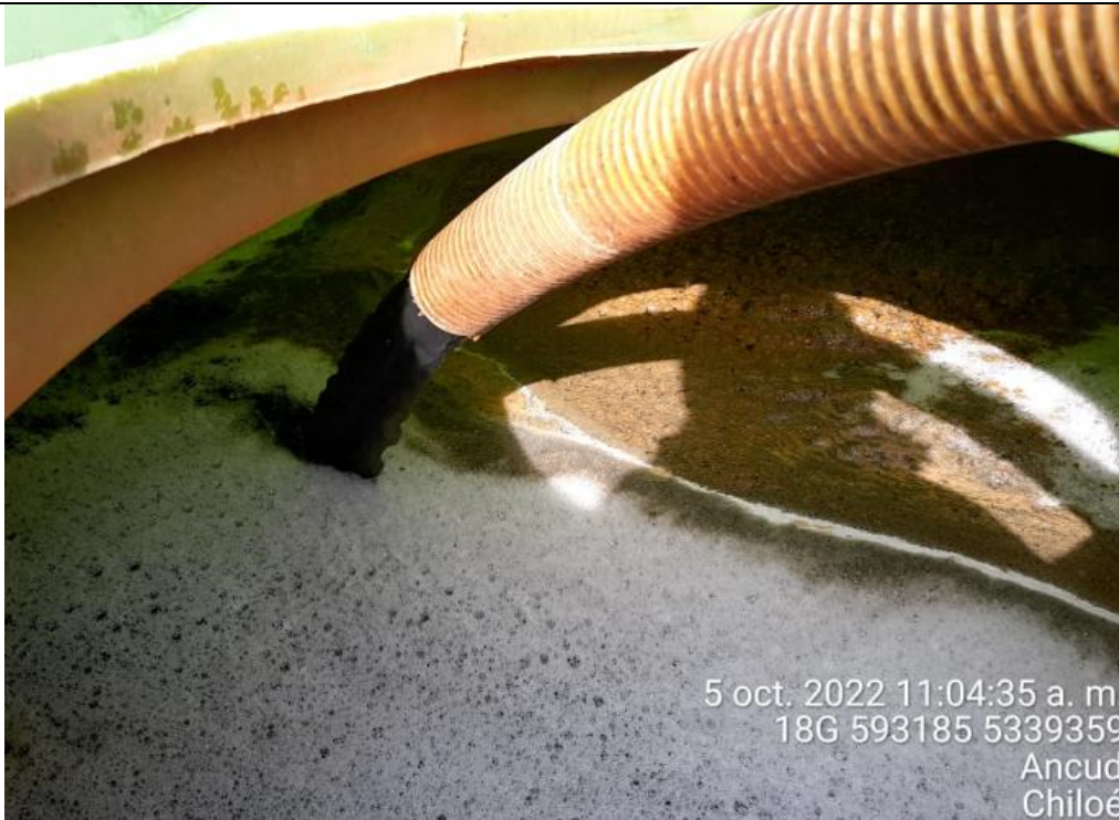
Fotografía N°13: Extracción de Lixiviados a estanque. Tomada: Miércoles 05 de Octubre del 2022.
