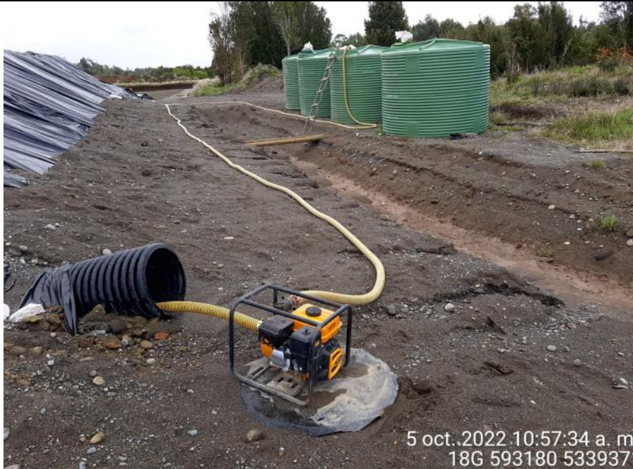
Fotografía N°12: Extracción de Lixiviados desde diagonal D2 Tomada: Miércoles 05 de Octubre del 2022.
