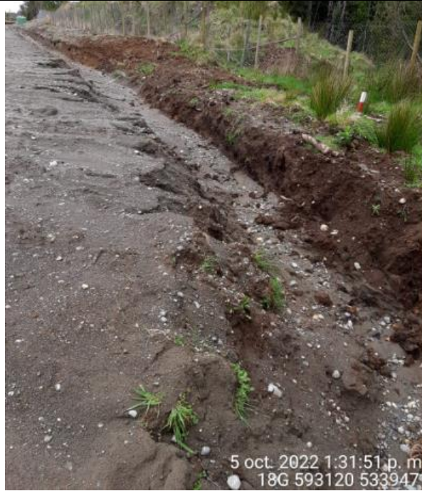
Fotografía N°37: Estado canales aguas lluvias
