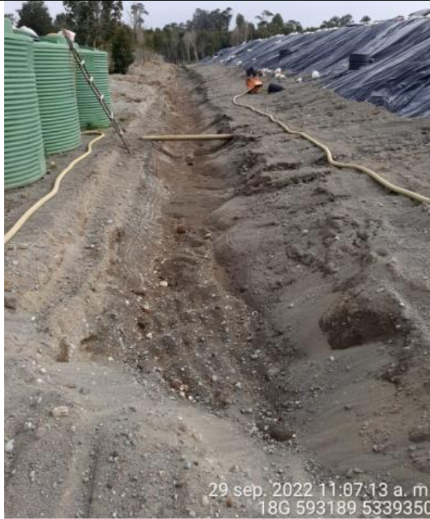
Fotografía N°32: Estado canales aguas lluvias
