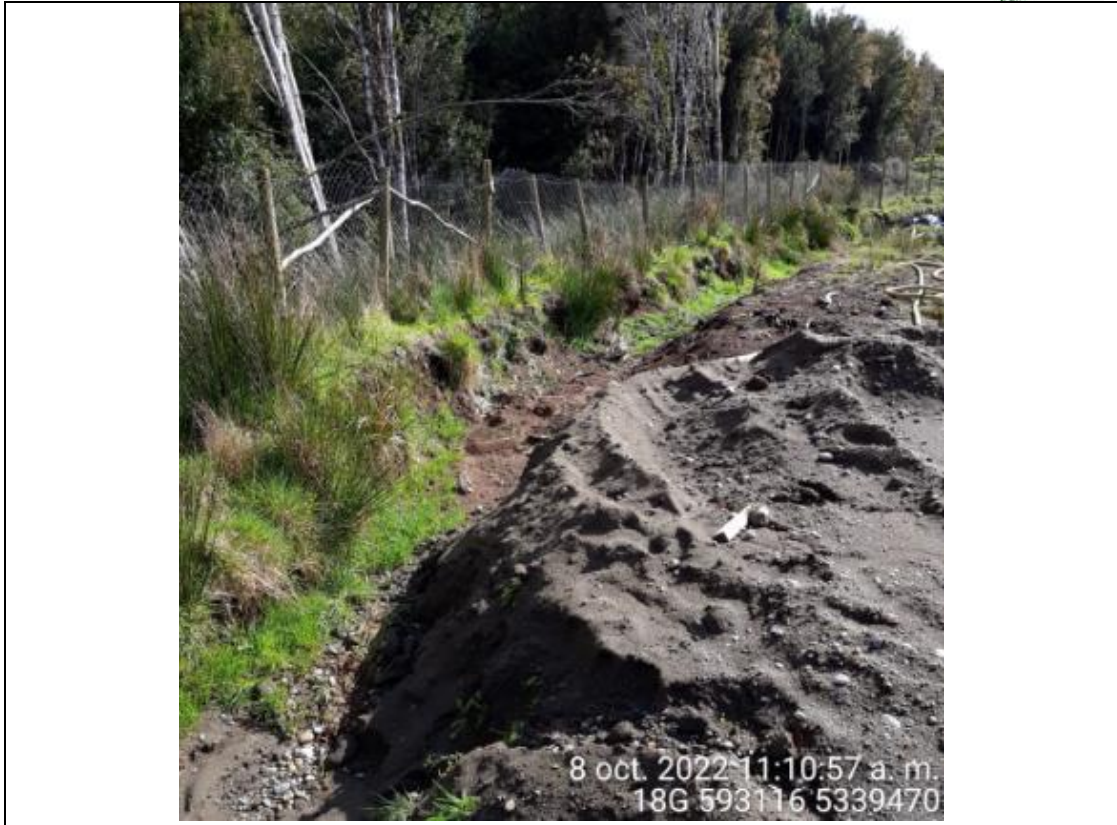
Fotografía N°40: Estado canales aguas lluvias
