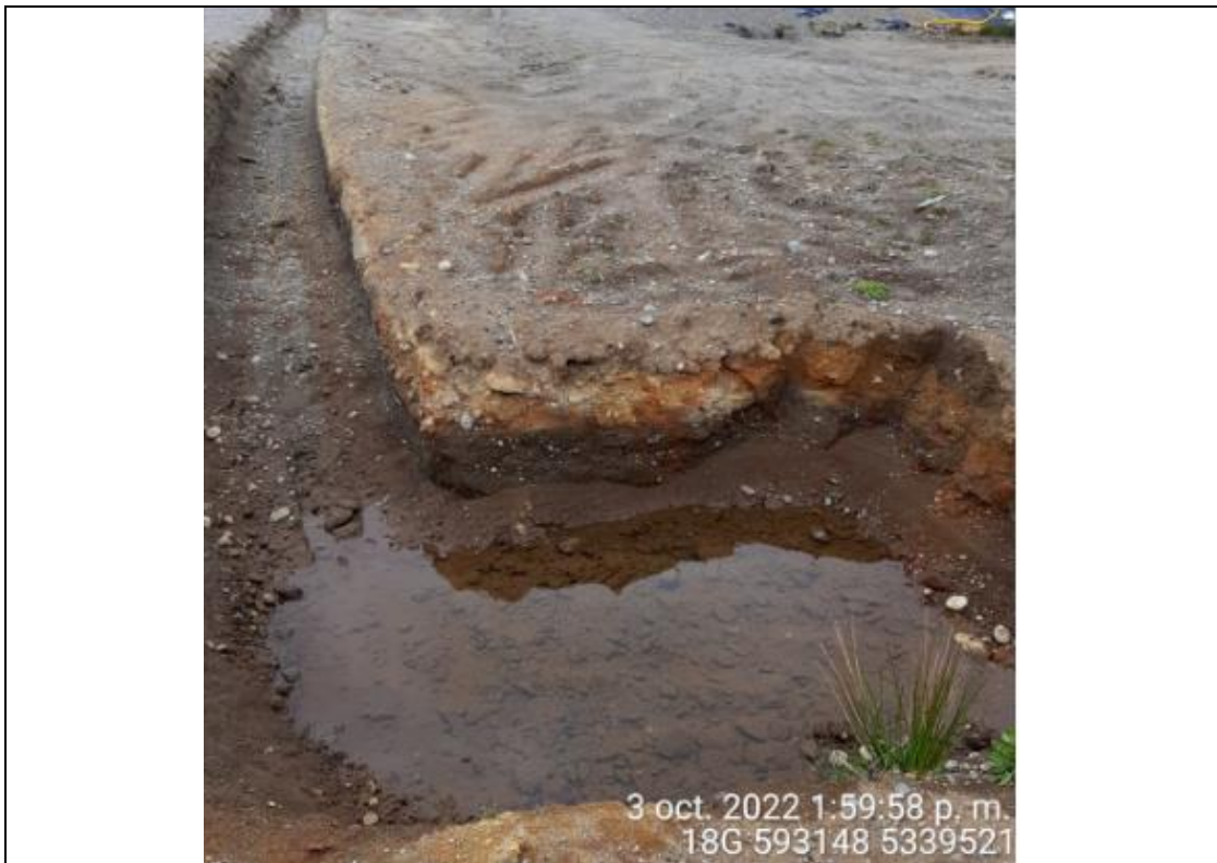
Fotografía N°35: Estado canales aguas lluvias
