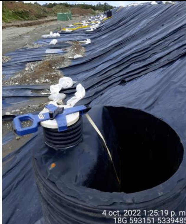
Fotografía N°24: Medición de Niveles de cámaras por Personal Municipal. Tomada: 04 de Octubre del 2022.
