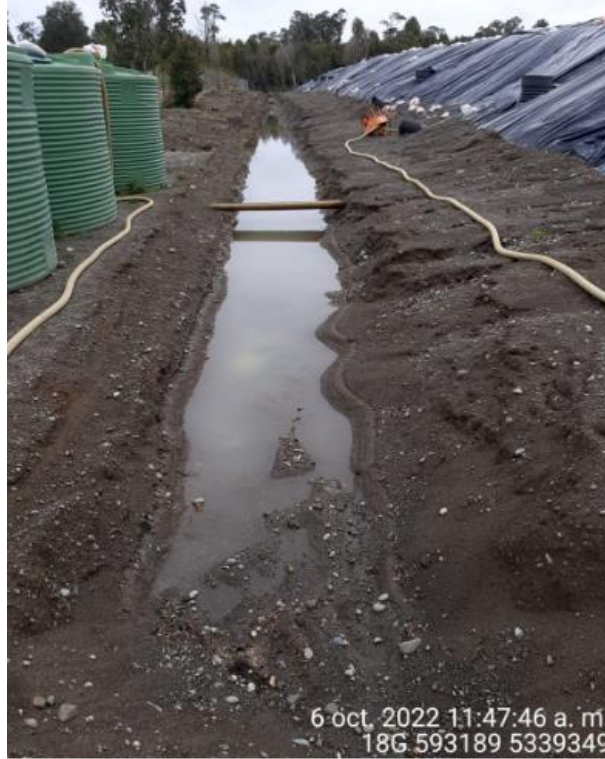
Fotografía N°38: Estado canales aguas lluvias
