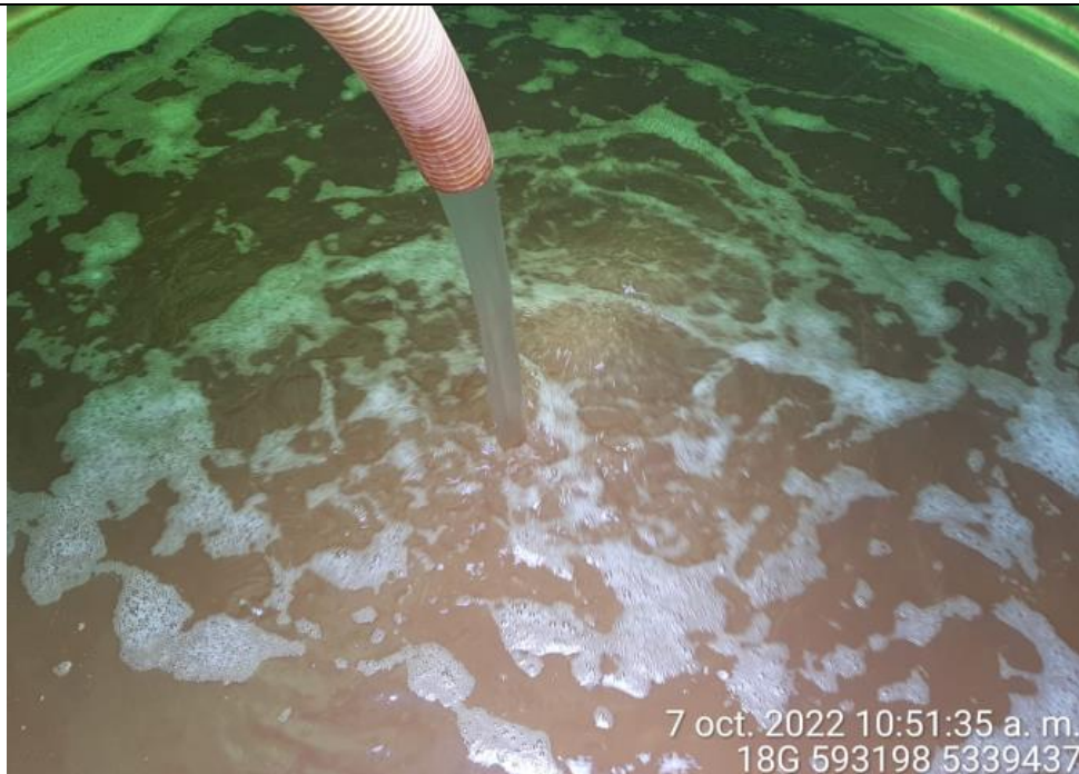
Fotografía N°15: Extracción de Lixiviados a estanque. Tomada: Viernes 07 de Octubre del 2022.
