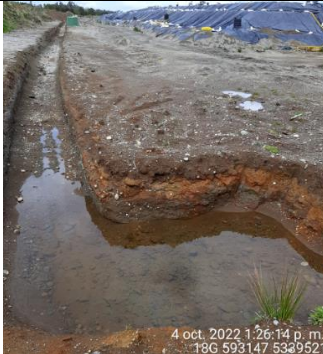
Fotografía N°36: Estado canales aguas lluvias
