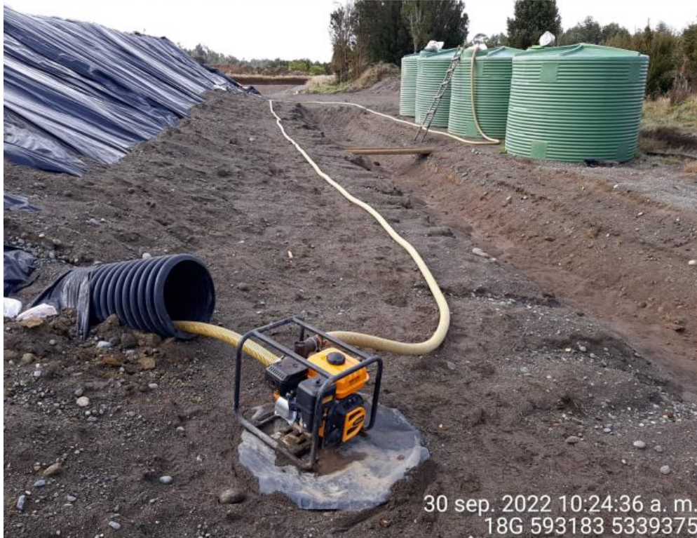
Fotografía N°7: Extracción de Lixiviados desde diagonal D2 Tomada: Viernes 30 de Septiembre del 2022.
