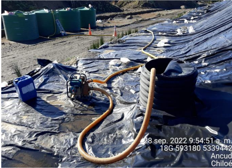
Fotografía N°4: Extracción de Lixiviados desde cámara C12 por personal municipal. Tomada: Miércoles 28 de Septiembre del 2022.
