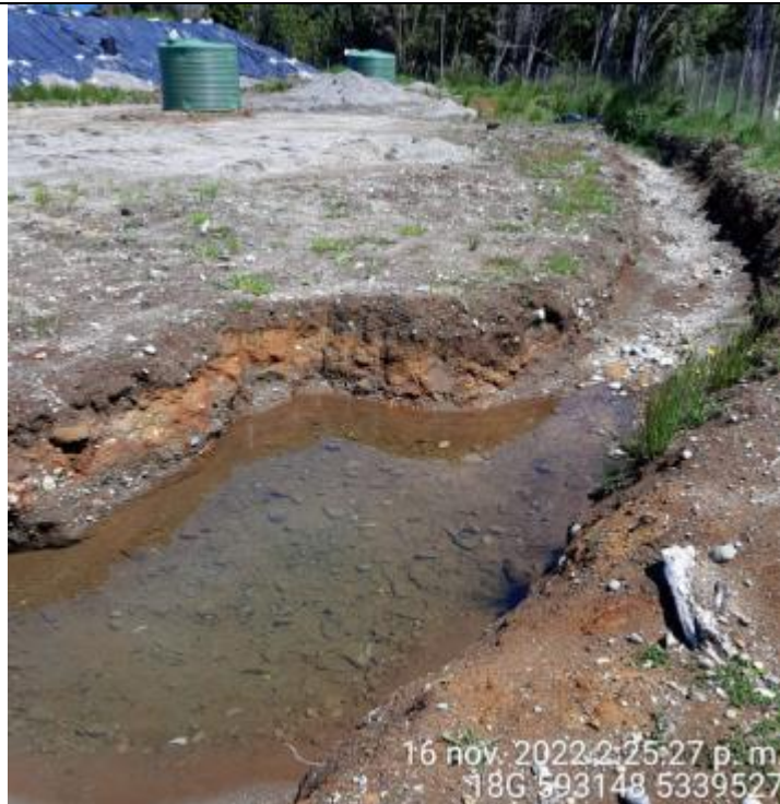
Fotografía N°49: Estado canales aguas lluvias
