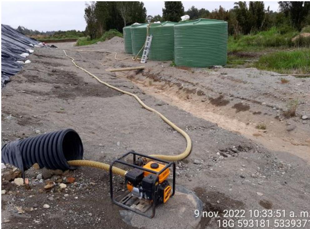
Fotografía N°5: Extracción de Lixiviados desde diagonal D02 por personal municipal. Tomada: Miércoles 09 de Noviembre del 2022.
