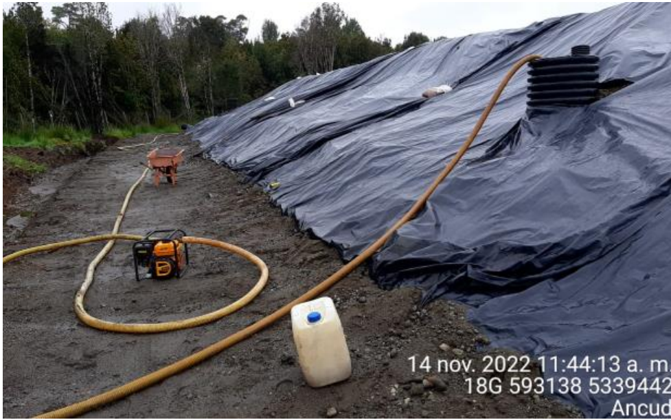
Fotografía N°17: Extracción de Lixiviados desde cámara C07 por personal municipal. Tomada: Lunes 14 de noviembre del 2022.
