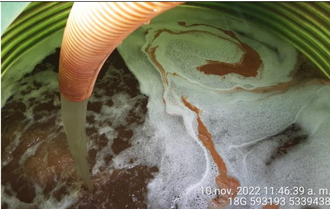
Fotografía N°11: Extracción de Lixiviados a estanque. Tomada: Jueves 10 de Noviembre del 2022.
