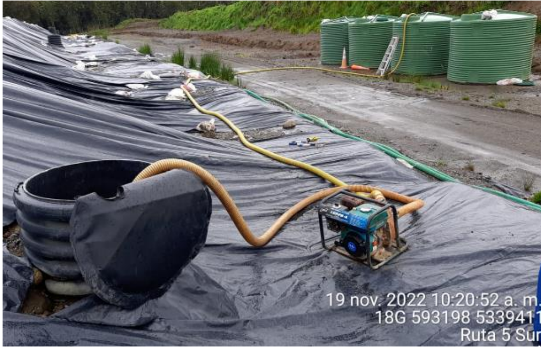
Fotografía N°27: Extracción de Lixiviados desde cámara C13 por personal municipal. Tomada: Sábado 19 de Noviembre del 2022.
