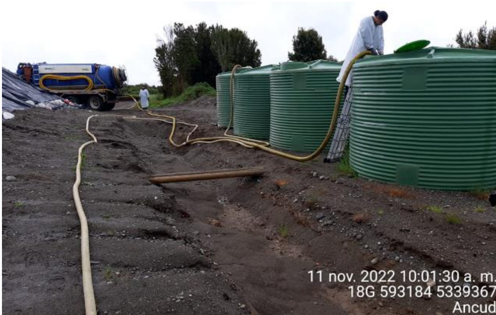
Fotografía N°13: Retiro de Lixiviados por parte de empresa Tresol. Tomada: Viernes 11 de Noviembre del 2022.
