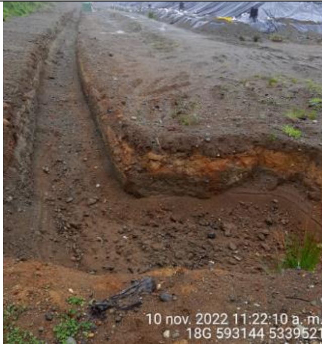
Fotografía N°44: Estado canales aguas lluvias
