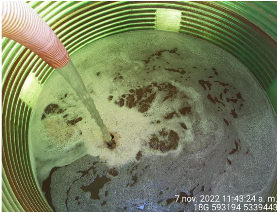
Fotografía N°3: Extracción de Lixiviados a estanque por personal municipal. Tomada: Lunes 07 de Noviembre del 2022.
