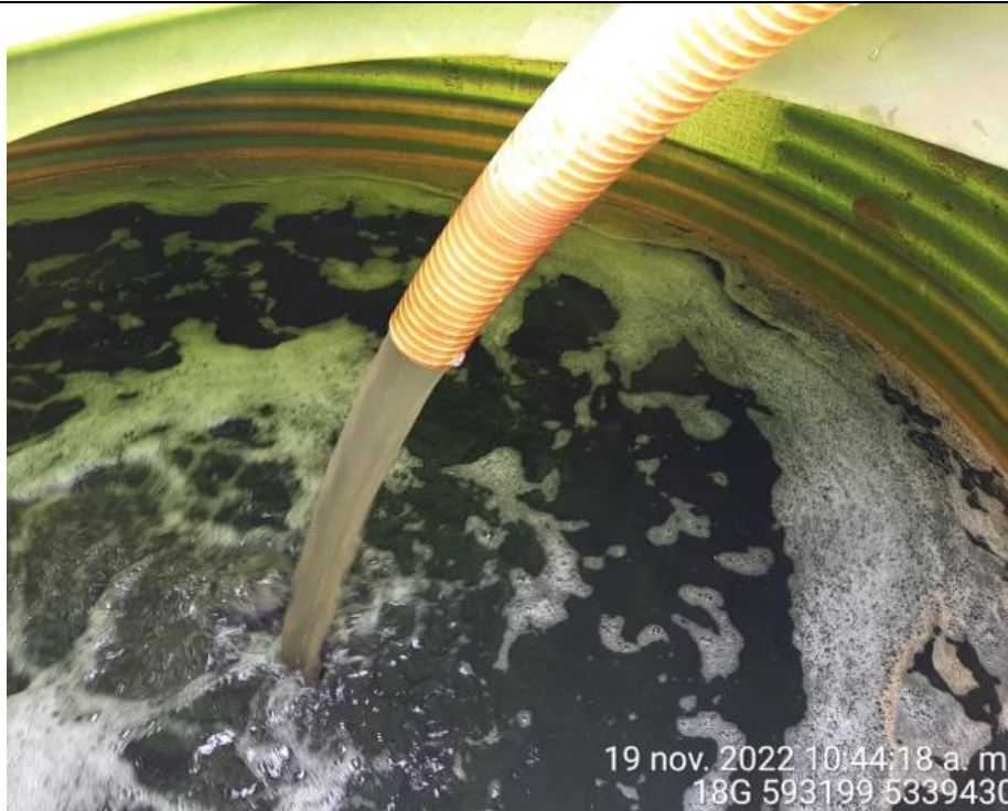
Fotografía N°28: Extracción de Lixiviados a estanque. Tomada: Sábado 19 de Noviembre del 2022.
