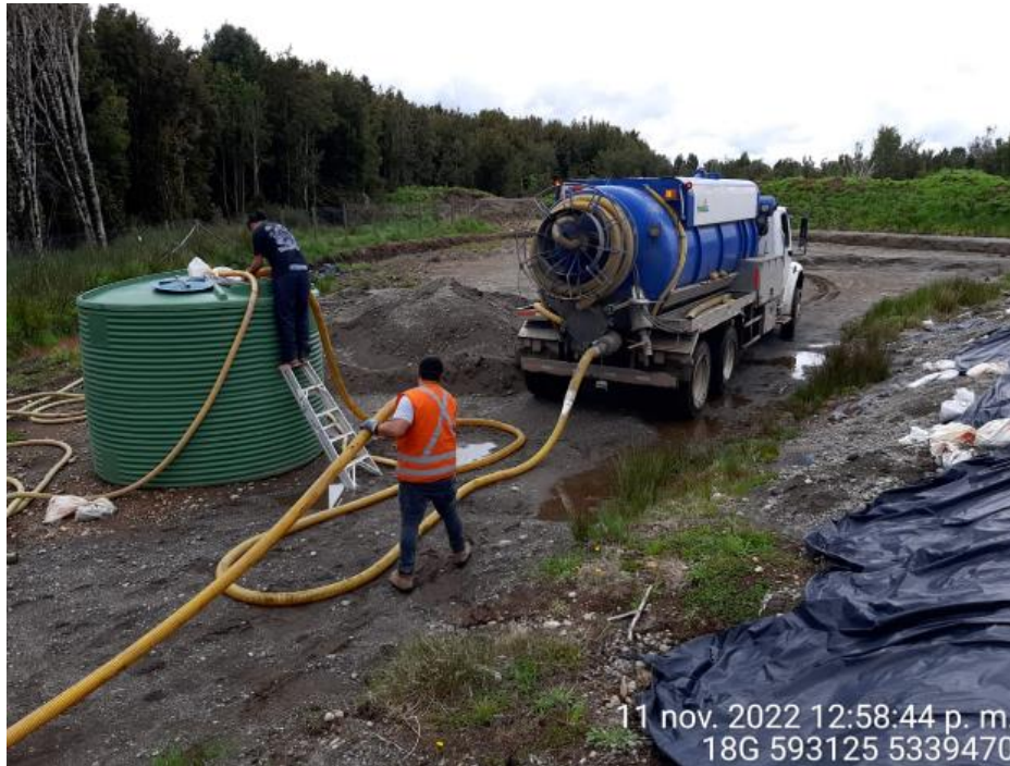
Fotografía N°12: Retiro de Lixiviados por parte de empresa Tresol. Tomada: Viernes 11 de Noviembre del 2022.
