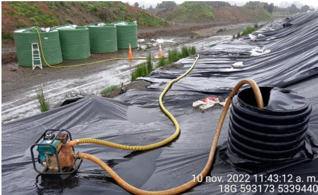
Fotografía N°9: Extracción de Lixiviados desde cámara C12 por personal municipal. Tomada: Jueves 10 de Noviembre del 2022.
