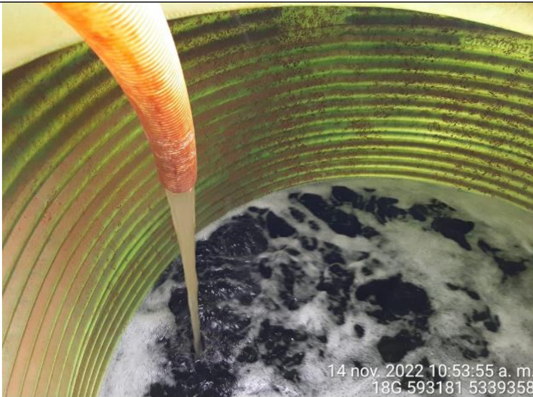
Fotografía N°18: Extracción de Lixiviados a estanque. Tomada: Lunes 14 de noviembre del 2022.
