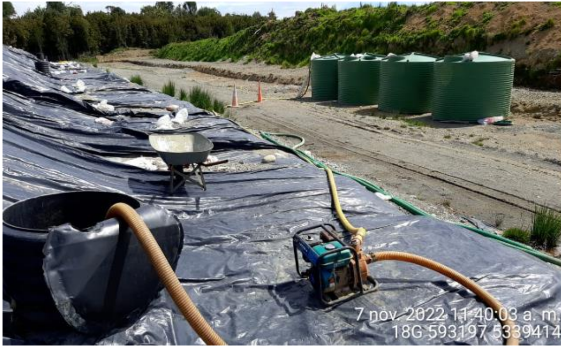
Fotografía N°2: Extracción de Lixiviados desde cámara C13. Tomada: Lunes 07 de Noviembre del 2022.
