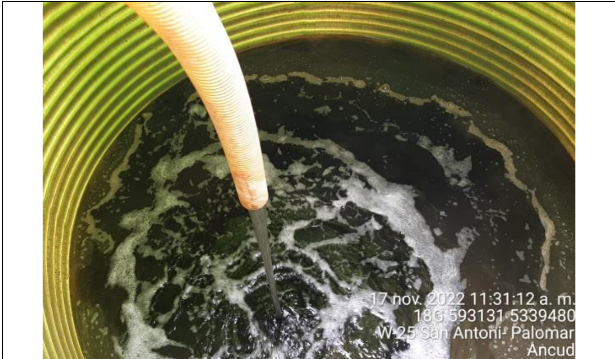
Fotografía N°25: Extracción de Lixiviados a estanque. Tomada: Jueves 17 de Noviembre del 2022.
