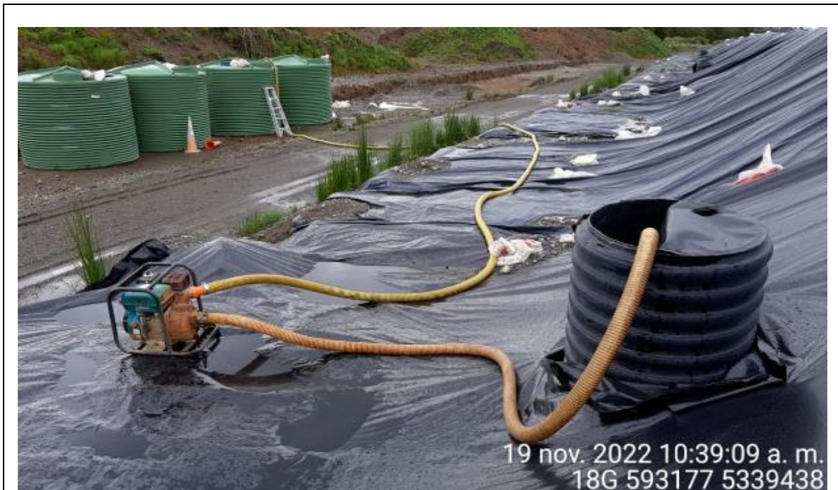
Fotografía N°26: Extracción de Lixiviados desde cámara C12 por personal municipal. Tomada: Sábado 19 de Noviembre del 2022.
