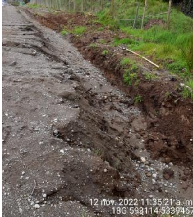
Fotografía N°46: Estado canales aguas lluvias
