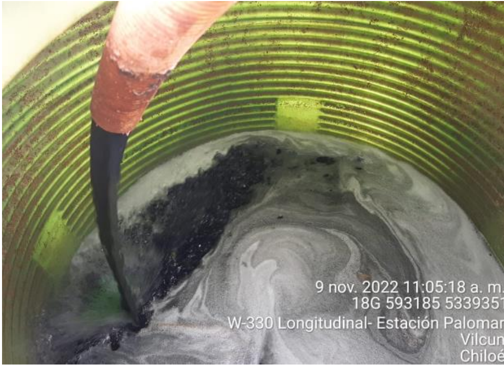
Fotografía N°8: Extracción de Lixiviados a estanque por personal municipal. Tomada: Miércoles 09 de Noviembre del 2022.
