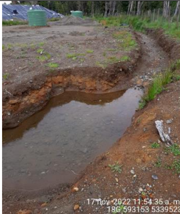
Fotografía N°50: Estado canales aguas lluvias
