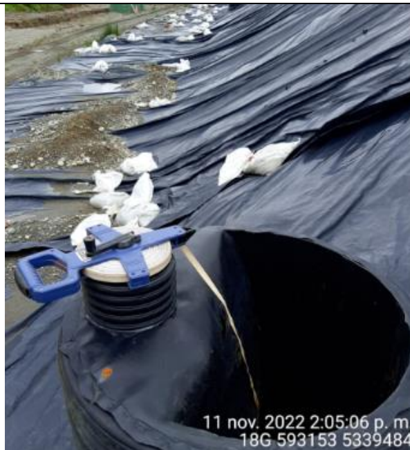
Fotografía N°34: Medición de Niveles de cámaras por Personal Municipal. Tomada: 11 de Noviembre del 2022.
