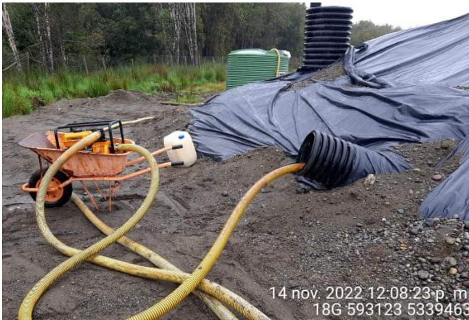
Fotografía N°17: Extracción de Lixiviados desde diagonal D04 por personal municipal. Tomada: Lunes 14 de noviembre del 2022.
