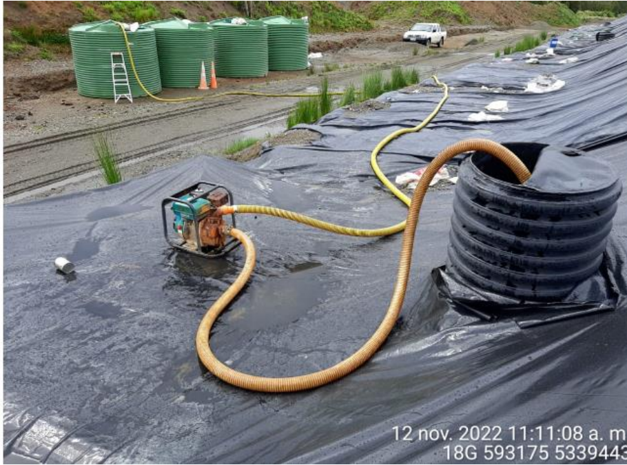
Fotografía N°14: Extracción de Lixiviados desde cámara C12 por personal municipal. Tomada: Sábado 12 de Noviembre del 2022.
