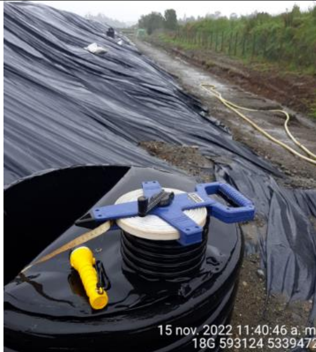
Fotografía N°37: Medición de Niveles de cámaras por Personal Municipal. Tomada: 15 de Noviembre del 2022.
