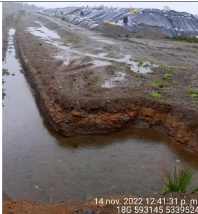
Fotografía N°47: Estado canales aguas lluvias
