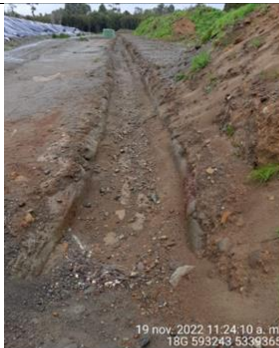
Fotografía N°51: Estado canales aguas lluvias
