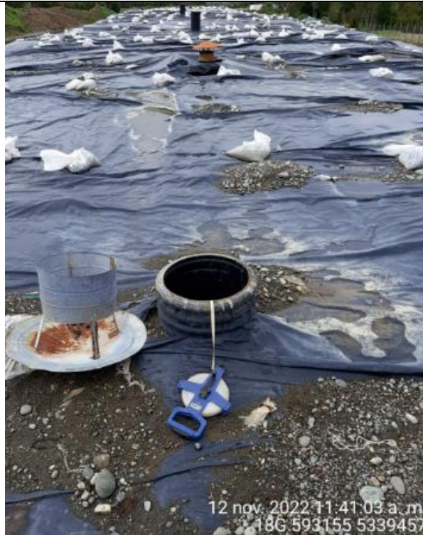
Fotografía N°35: Medición de Niveles de cámaras por Personal Municipal. Tomada: 12 de Noviembre del 2022.
