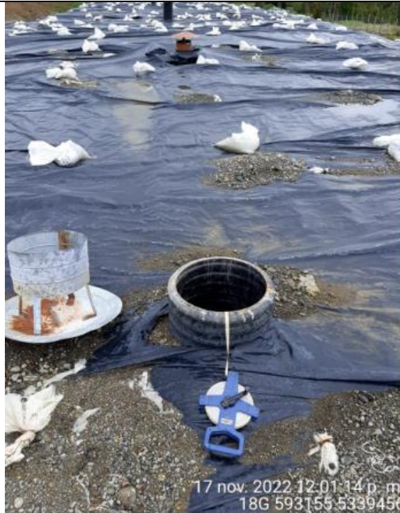
Fotografía N°39: Medición de Niveles de cámaras por Personal Municipal. Tomada: 17 de Noviembre del 2022.
