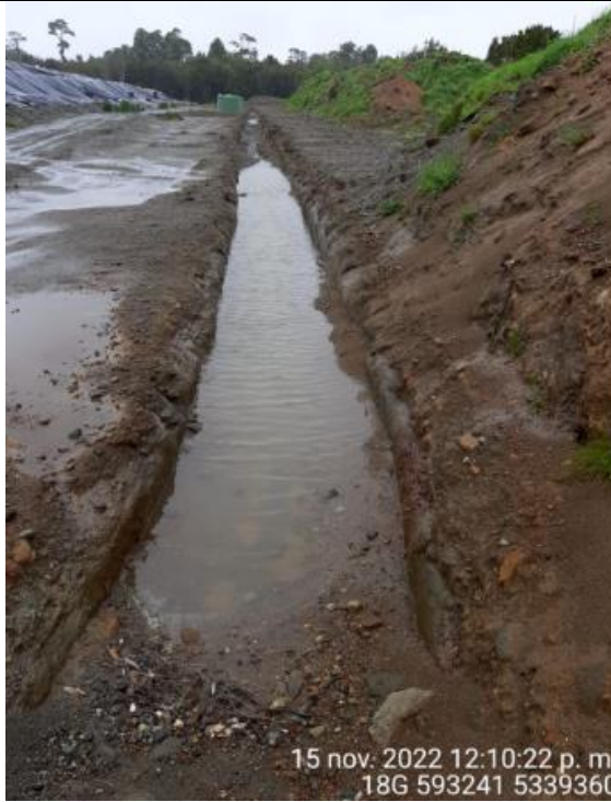
Fotografía N°48: Estado canales aguas lluvias
