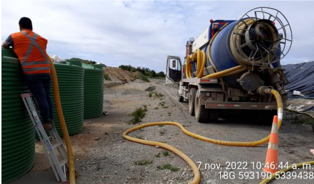
Fotografía N°4: Retiro de Lixiviados por parte de empresa Tresol. Tomada: Lunes 07 de Noviembre del 2022.
