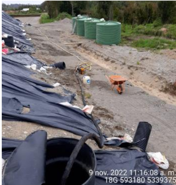
Fotografía N°7: Extracción de Lixiviados desde cámara C03 por personal municipal. Tomada: Miércoles 09 de Noviembre del 2022.
