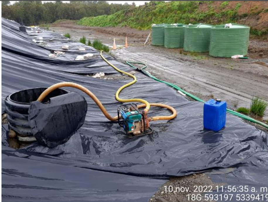
Fotografía N°10: Extracción de Lixiviados desde cámara C13 por personal municipal. Tomada: Jueves 10 de Noviembre del 2022.
