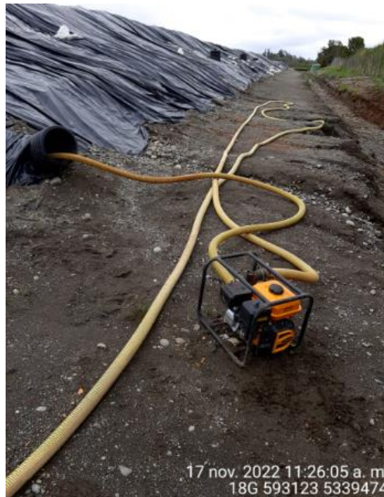
Fotografía N°24: Extracción de Lixiviados desde diagonal D04 por personal municipal. Tomada: Jueves 17 de noviembre del 2022.
