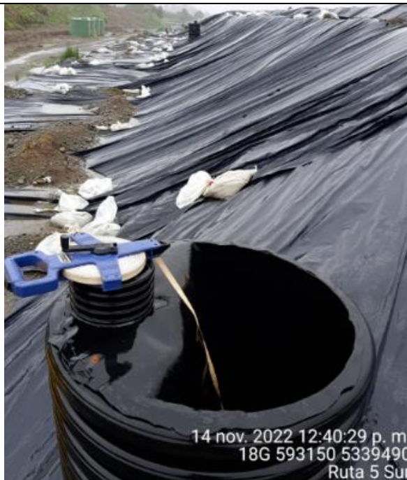
Fotografía N°36: Medición de Niveles de cámaras por Personal Municipal. Tomada: 14 de Noviembre del 2022.
