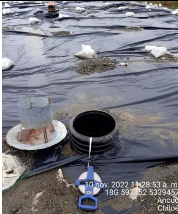
Fotografía N°33: Medición de Niveles de cámaras por Personal Municipal. Tomada: 10 de Noviembre del 2022.
