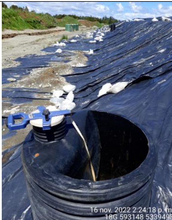
Fotografía N°38: Medición de Niveles de cámaras por Personal Municipal. Tomada: 16 de Noviembre del 2022.
