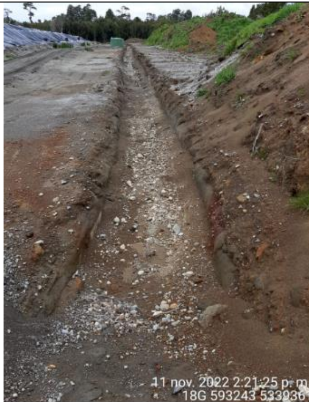
Fotografía N°45: Estado canales aguas lluvias
