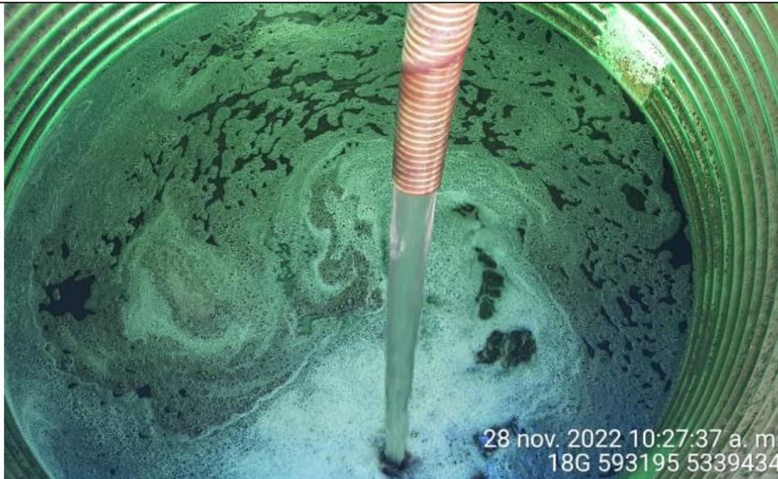
Fotografía N°13: Extracción de Lixiviados a estanque.
