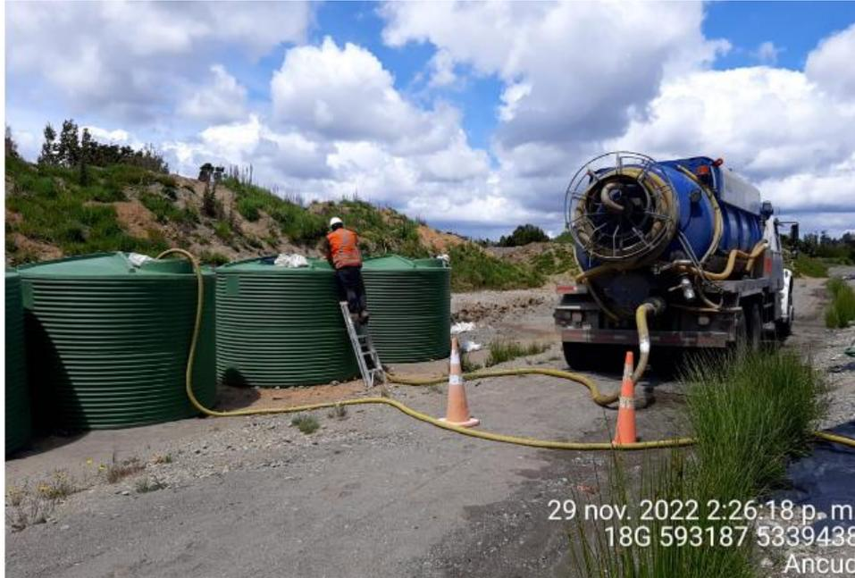
Fotografía N°14: Retiro Lixiviado a disposición final por parte de empresa Tresol.
