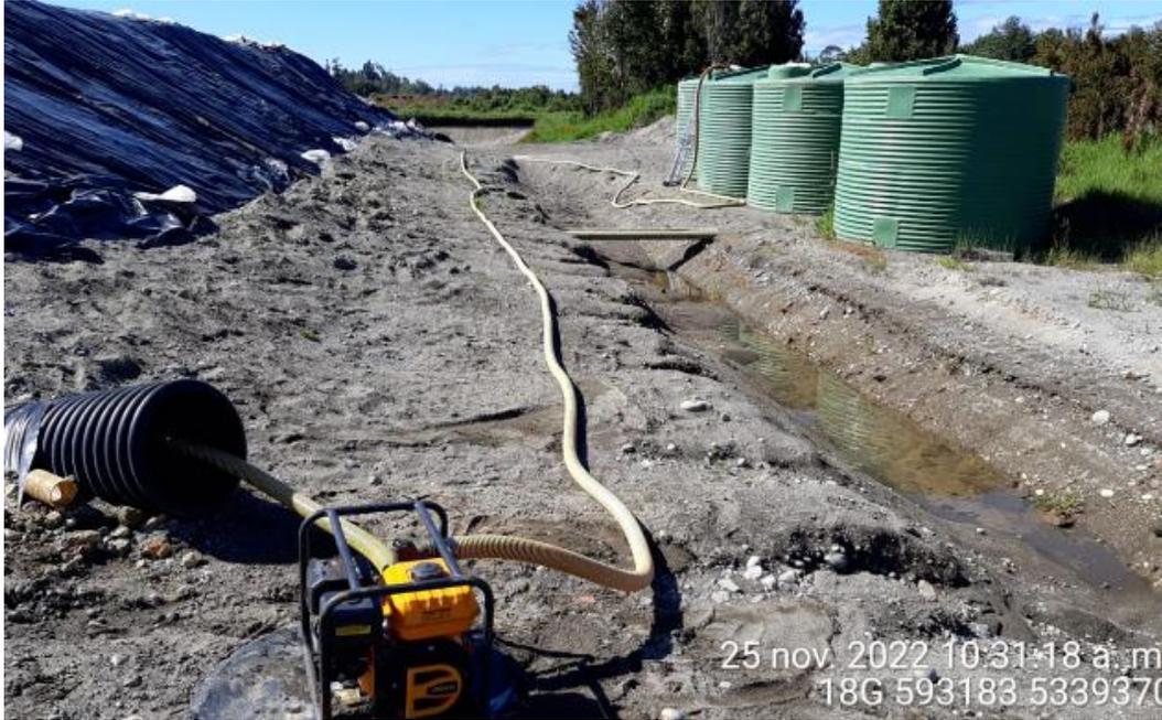
Fotografía N°8: Extracción de Lixiviados desde diagonal D02.
