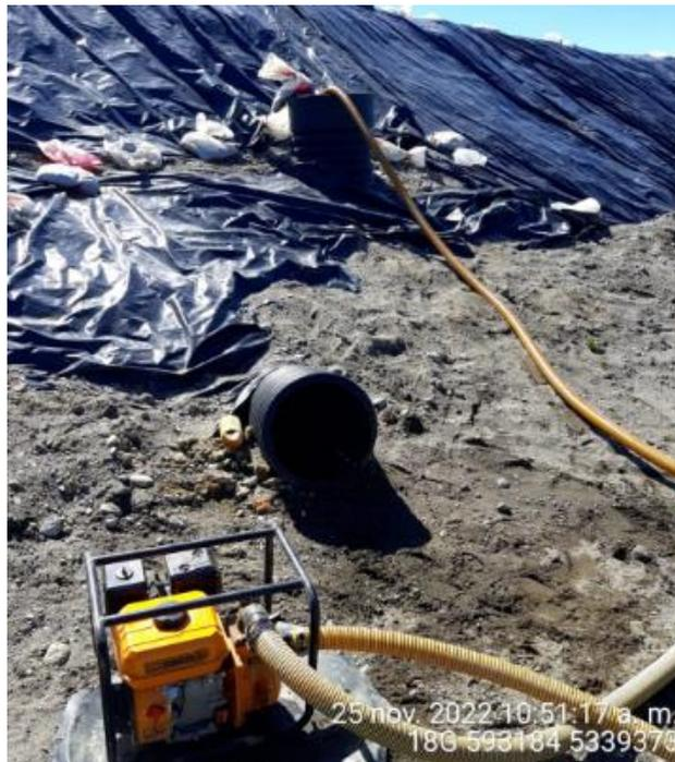
Fotografía N°9: Extracción de Lixiviados desde cámara C02.
