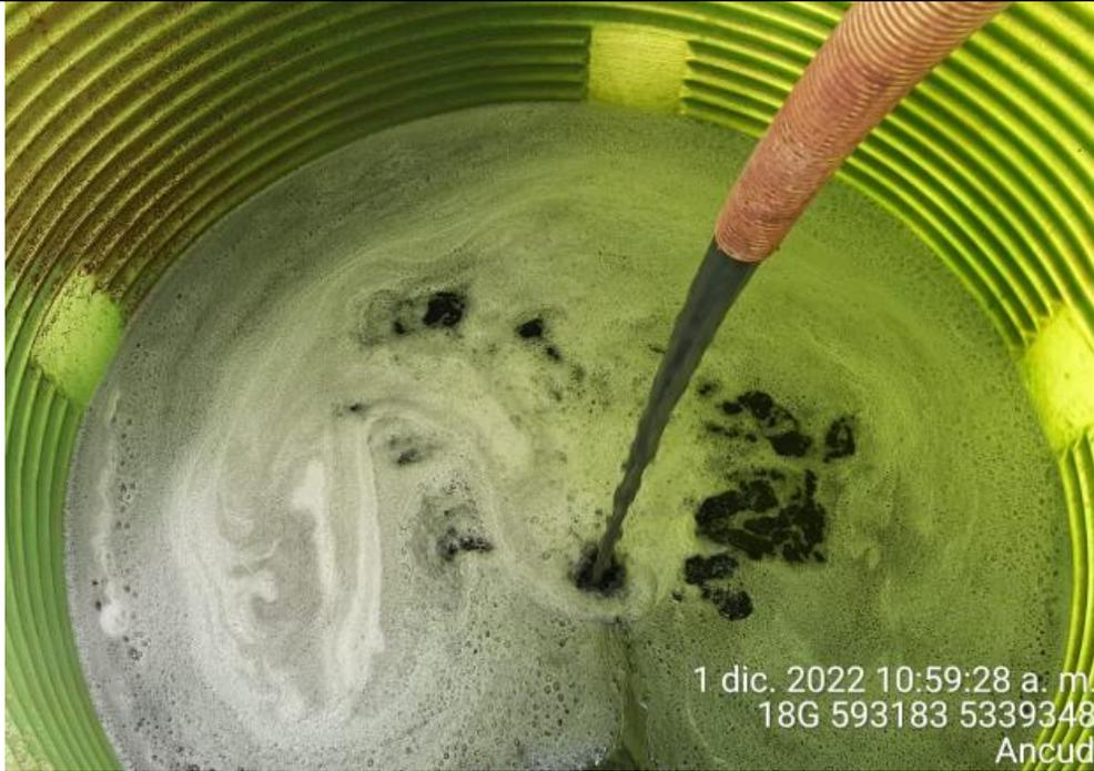
Fotografía N°18: Extracción de Lixiviados a estanque.
