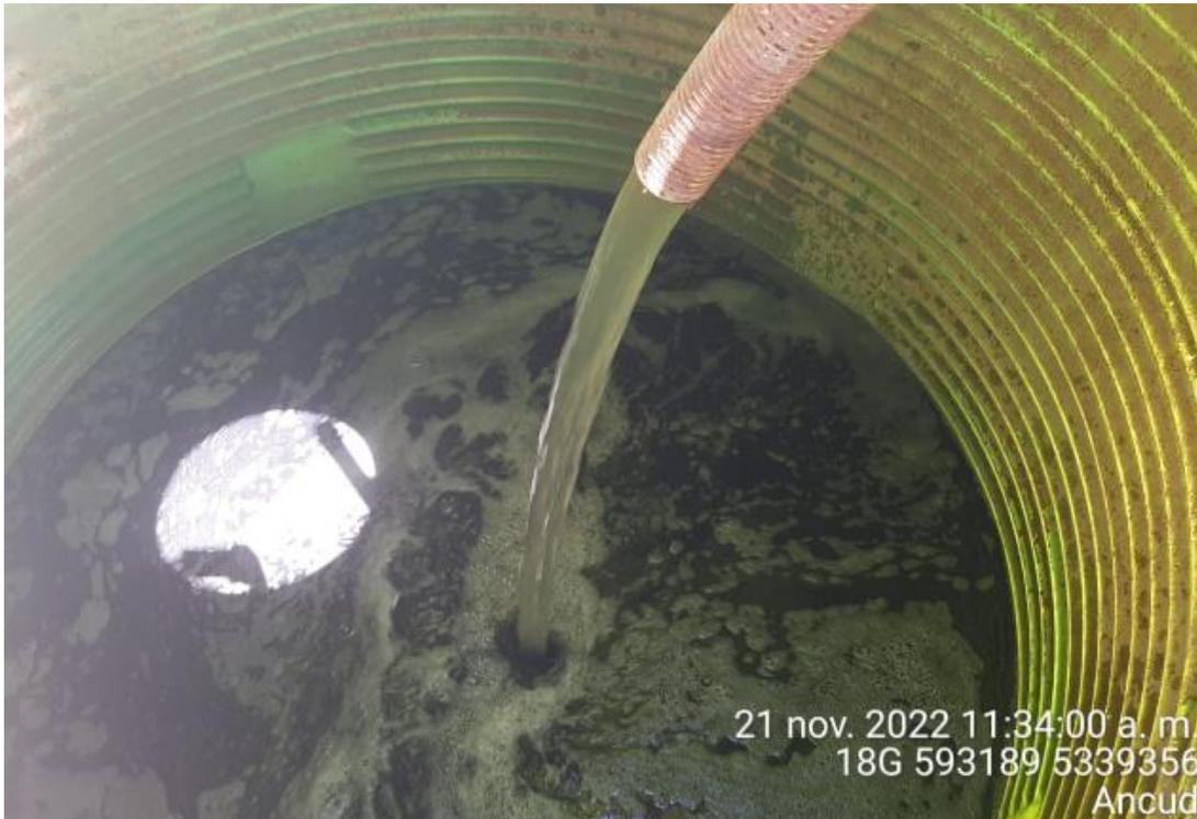
Fotografía N°3: Extracción de Lixiviados a estanque por personal municipal.
