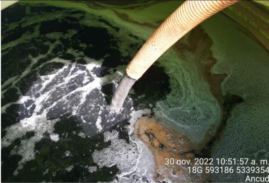
Fotografía N°16: Extracción de Lixiviados a estanque.
