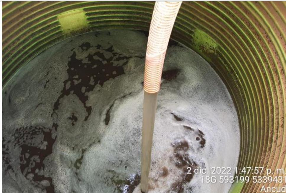
Fotografía N°21: Extracción de Lixiviados a estanque.
