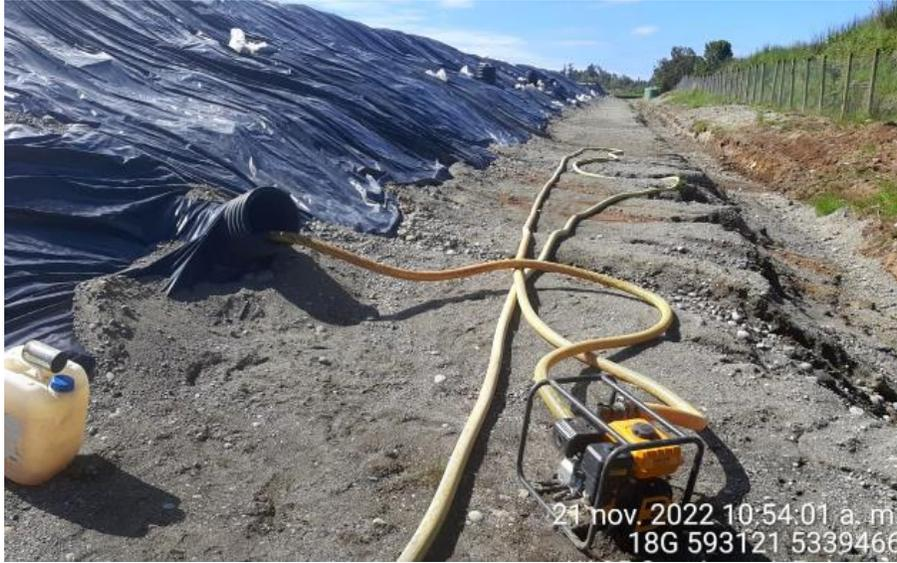
Fotografía N°2: Extracción de Lixiviados desde diagonal D04.
