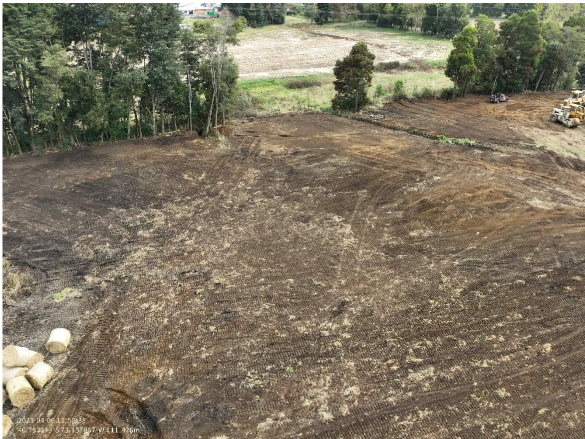
Figura 4: Vista detallada de zona de apozamiento luego de retiro y nivelación (Fecha 06/04/2023)
