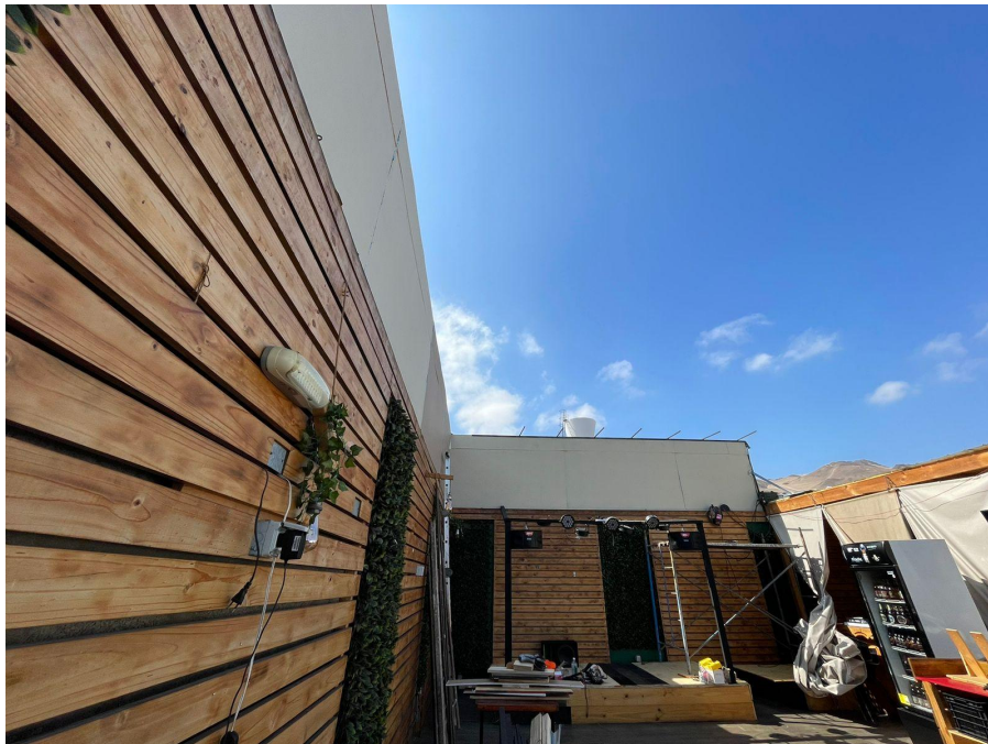
FOTOS 14 – Instalación alas superiores levantamiento muros
