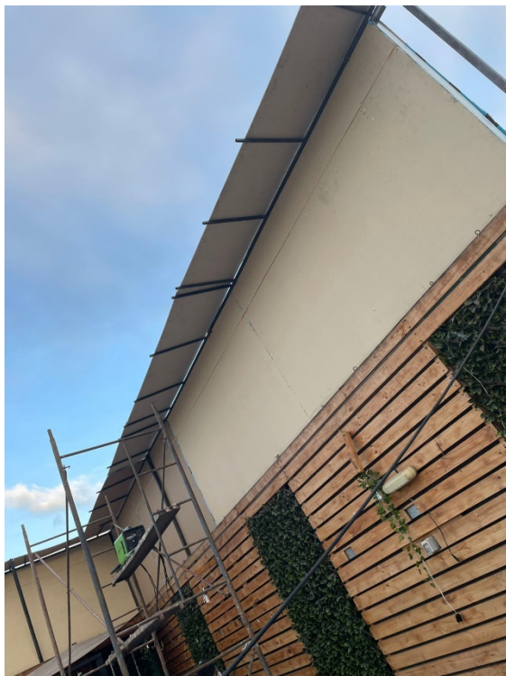
FOTO 16 – Instalación de alas levantamiento muro este
