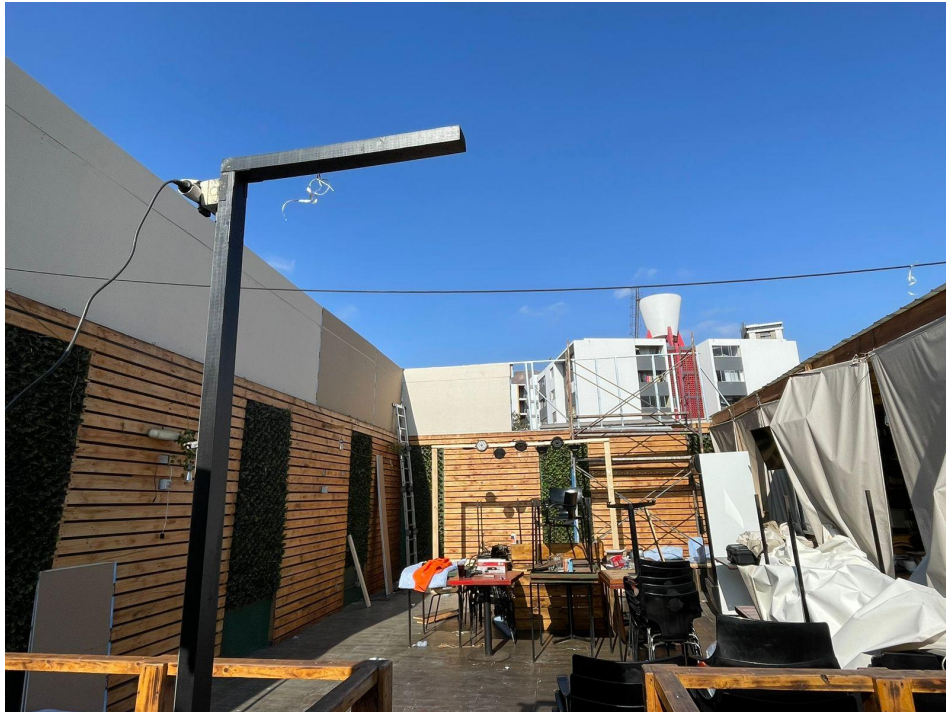
FOTO 11 – Avance levantamiento muro sur
