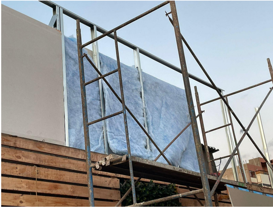
FOTO 8 – Fotografía instalación de aislante térmico acústico Fiber
