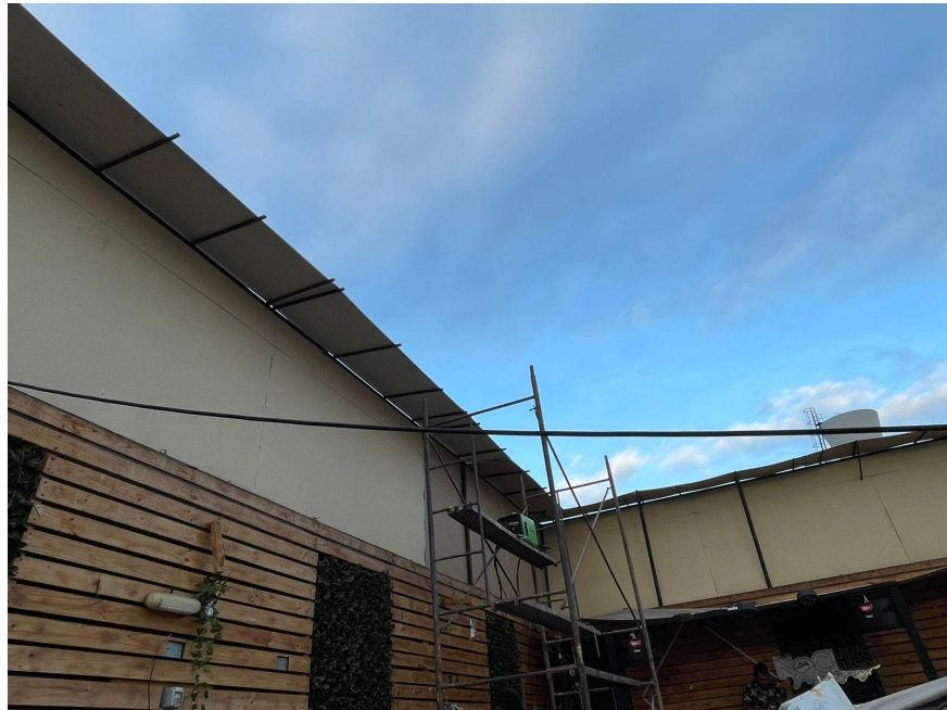
FOTO 15 – Instalación de alas levantamiento muro este
