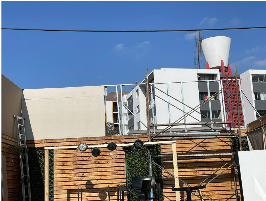
FOTO 12 – Levantamiento terminado muro este y sur
