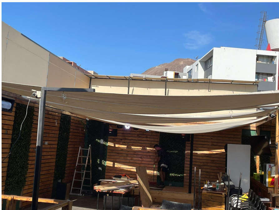
FOTO 17 – Re instalación de lonas techo 2 piso
