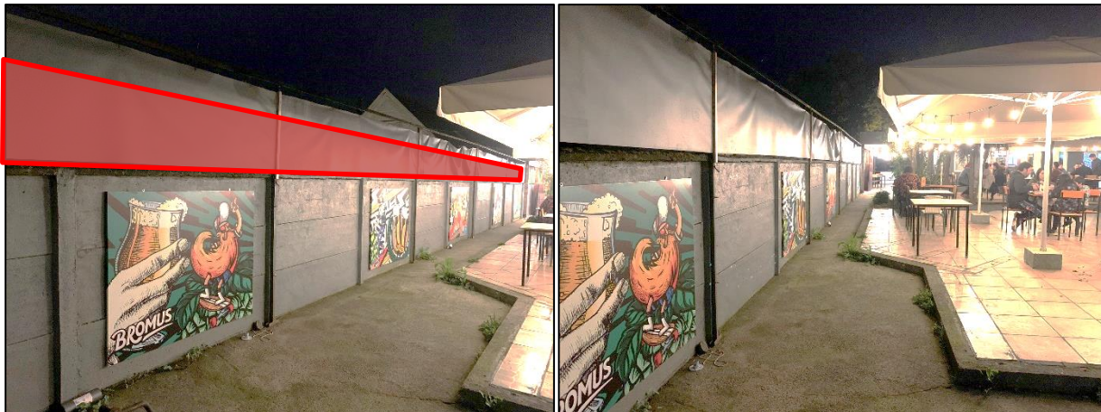
Ilustración 8. Aumento de altura de muro perimetral.
