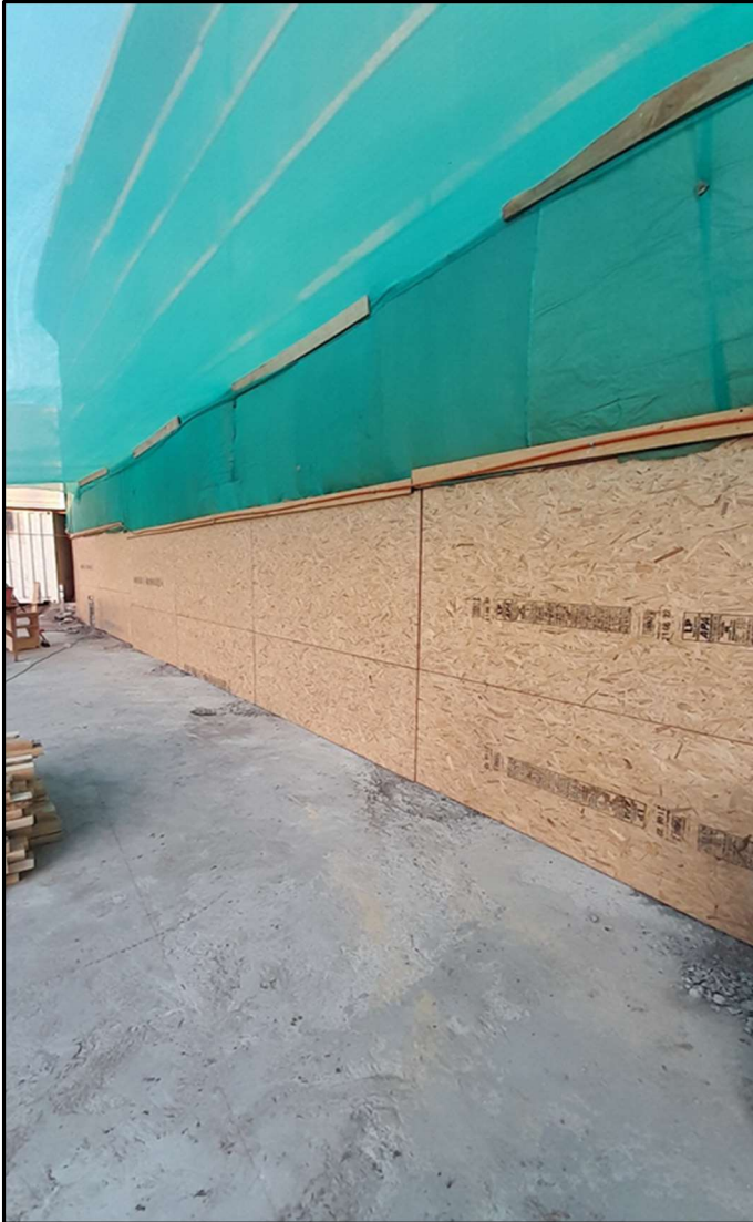
Imágenes de colocación de planchas de OSB de 15 mm en cierre acústico
