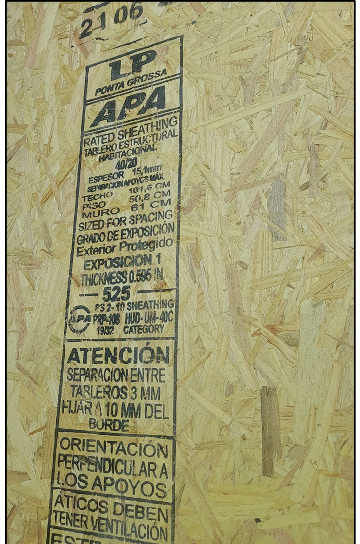
Imágenes de colocación de planchas de OSB de 15 mm en cierre acústico
