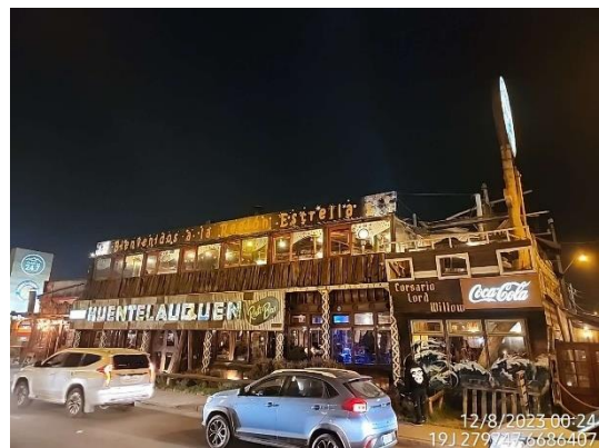
Vista general de Unidad Inspeccionada
